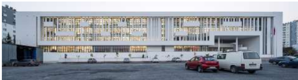
Şekil 81. Mezitli Belediyesi Kuzeydoğu Cephesi [132]
