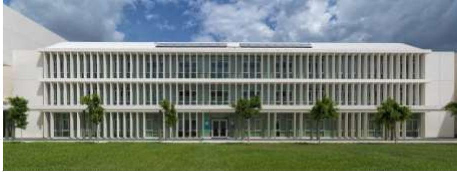
Şekil 83. TAC-SEV Eğitim Kampüsü Güneybatı Cephesi [134]
