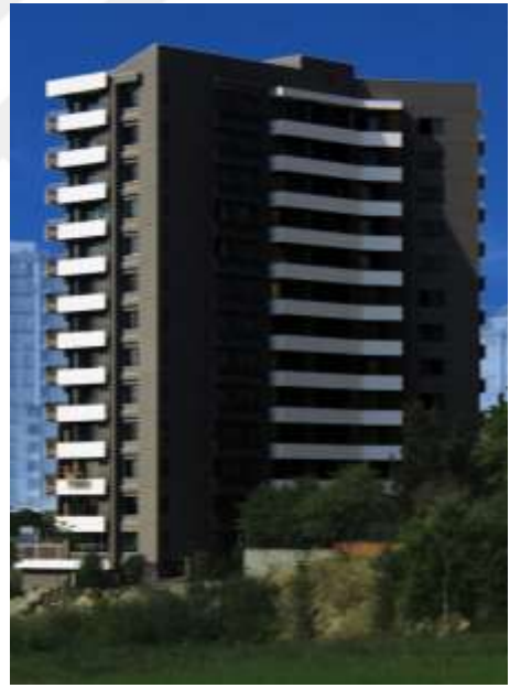
Şekil 54. Arıkoğlu Plaza Kuzey Cephesi [111]
