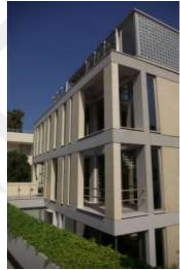
Şekil 68. MDTO Kuzey Cephesi [126]
