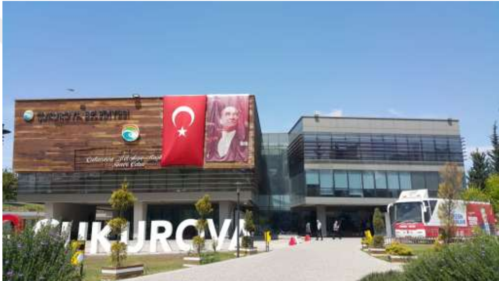
Şekil 61. Çukurova Belediyesi Doğu Cephesi [118]
