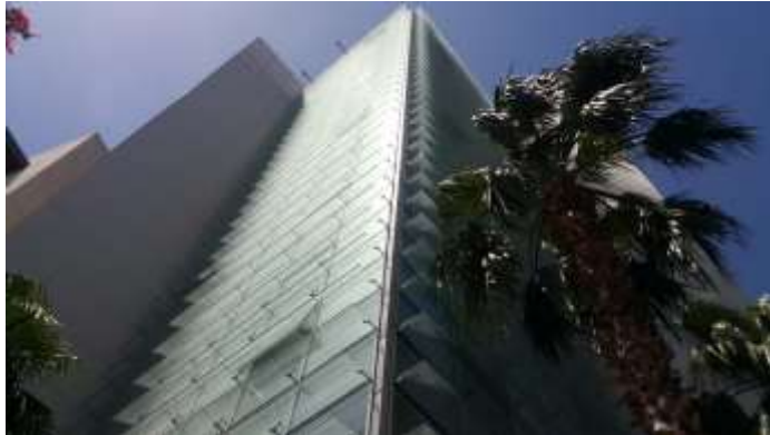
Şekil 41. İş Bankası Cam Kule Genel Görünüm [102]
