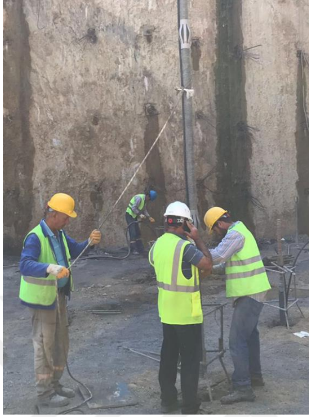
Şekil 4.14: Mikro kazık donatısının yerleştirilmesi
