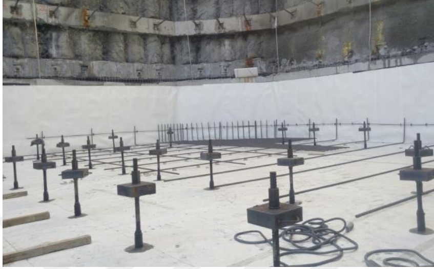
Şekil 4.36: Temel izolasyonları tamamlanmış mikro kazıklar
