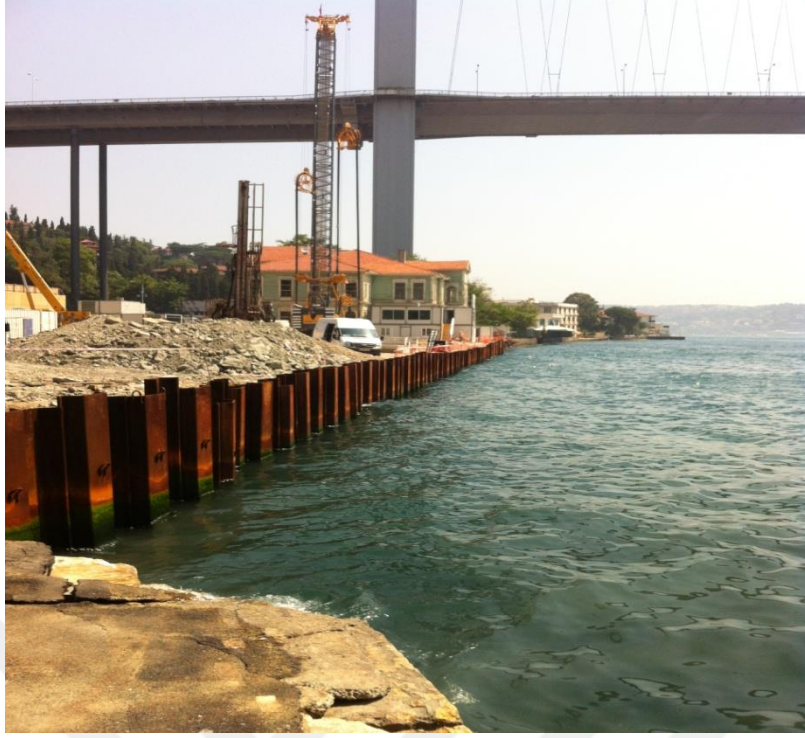
Şekil 2.3: Palplanş uygulamalarına örnek bir fotoğraf (ZETAS - İstanbul/Ortaköy)
