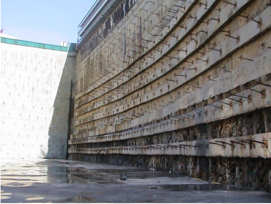
Şekil 2.1: Öngermeli ankraj destekli fore kazıklı iksa sistemi (ZETAS - İstanbul/Maslak)
