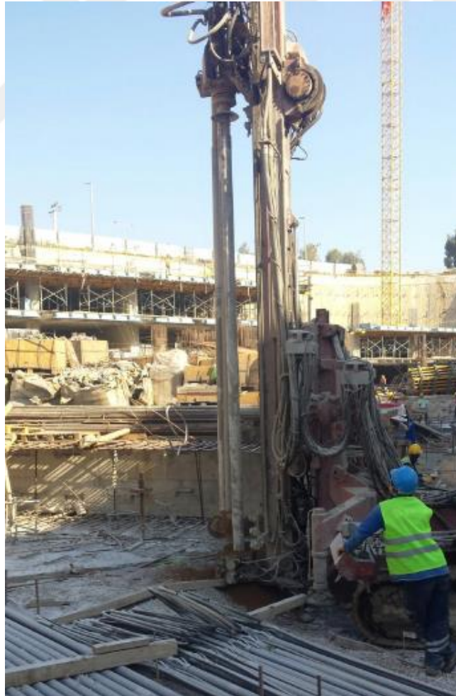
řekil 4.35: Sıkıřık řantiye kořullarında mikro kazık imalatının yapılması
