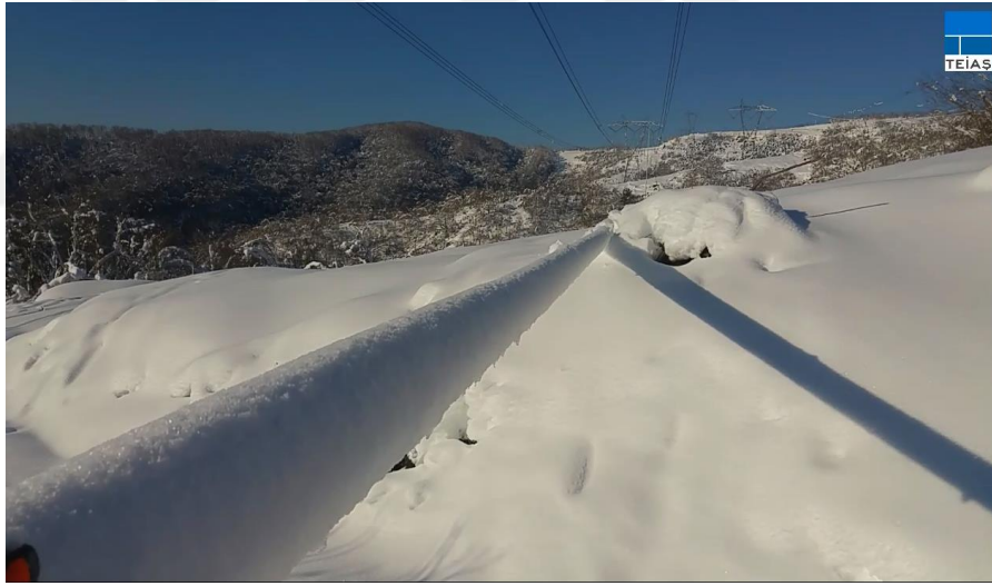
Şekil 1.13: Buzla kaplı 154 kV enerji iletim hattı iletkenleri
