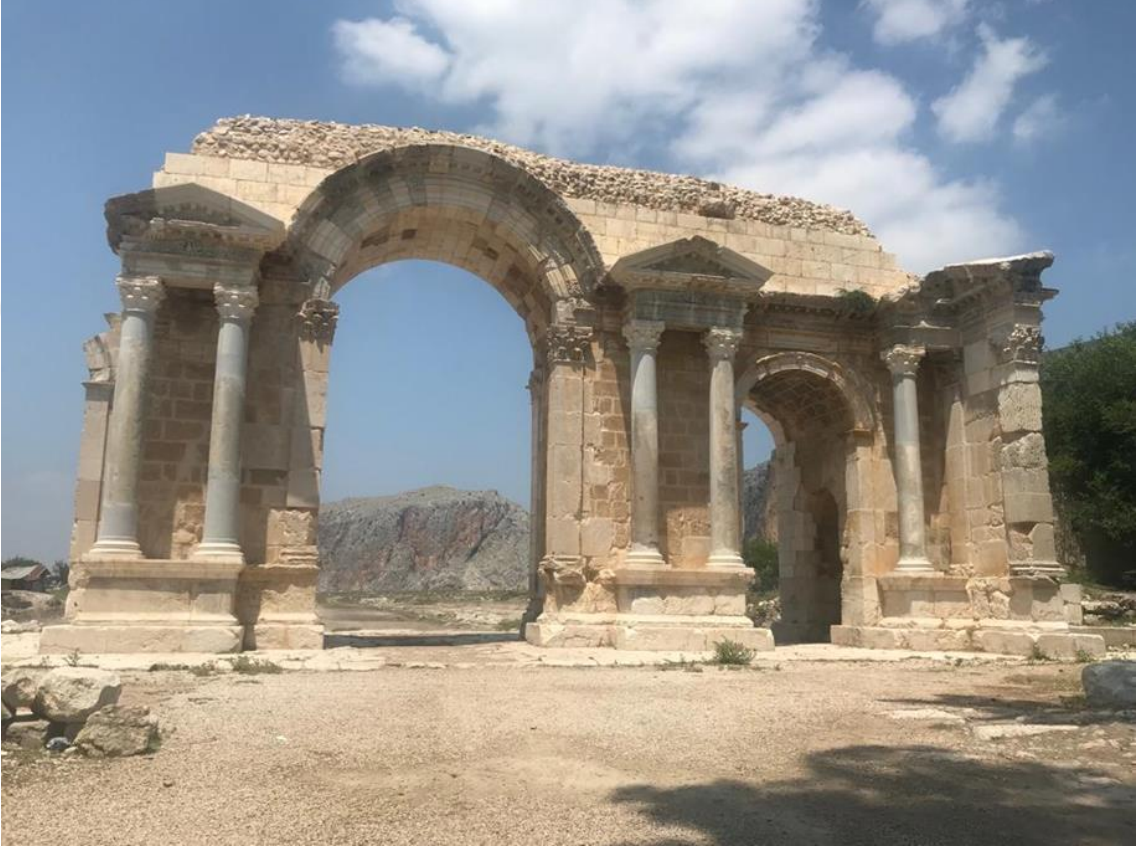
Şekil 5.65. Anavarza Antik Kenti Restorasyon Sonrası Zafer Takı (Kişisel Arşiv, 2022)
