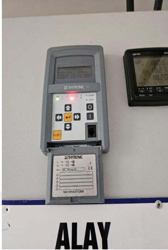
Şekil 2.11. Aşırı Akım Koruma rölesinin ön ve arka görünümü
