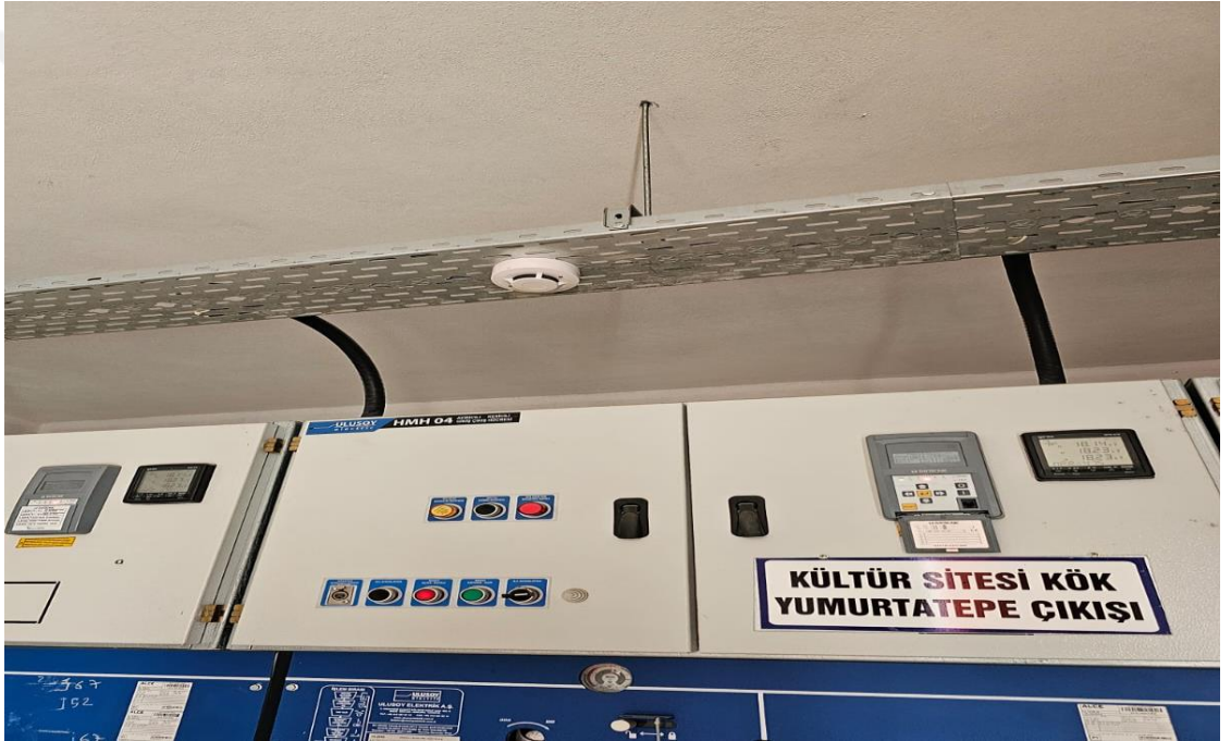
Şekil 2.13. Aşırı akım koruma Rölesinin Montaj yeri
