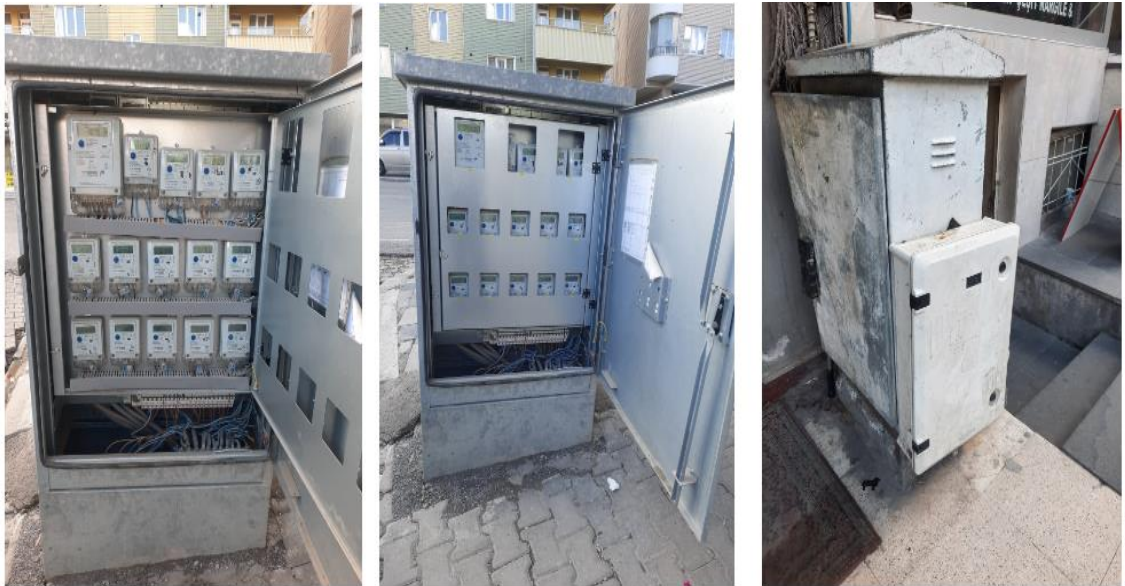
Şekil 3.19. Box panoya sayaç montajı
