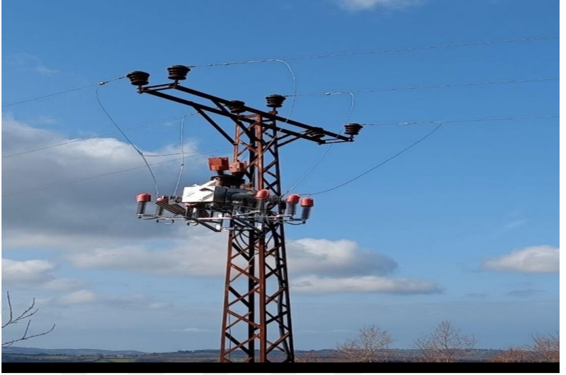
Şekil 3.7. Van İli Gevaş ilçesinde montajı yapılan Direk Tipi Otomatik Tekrar Kapamalı Kesici
