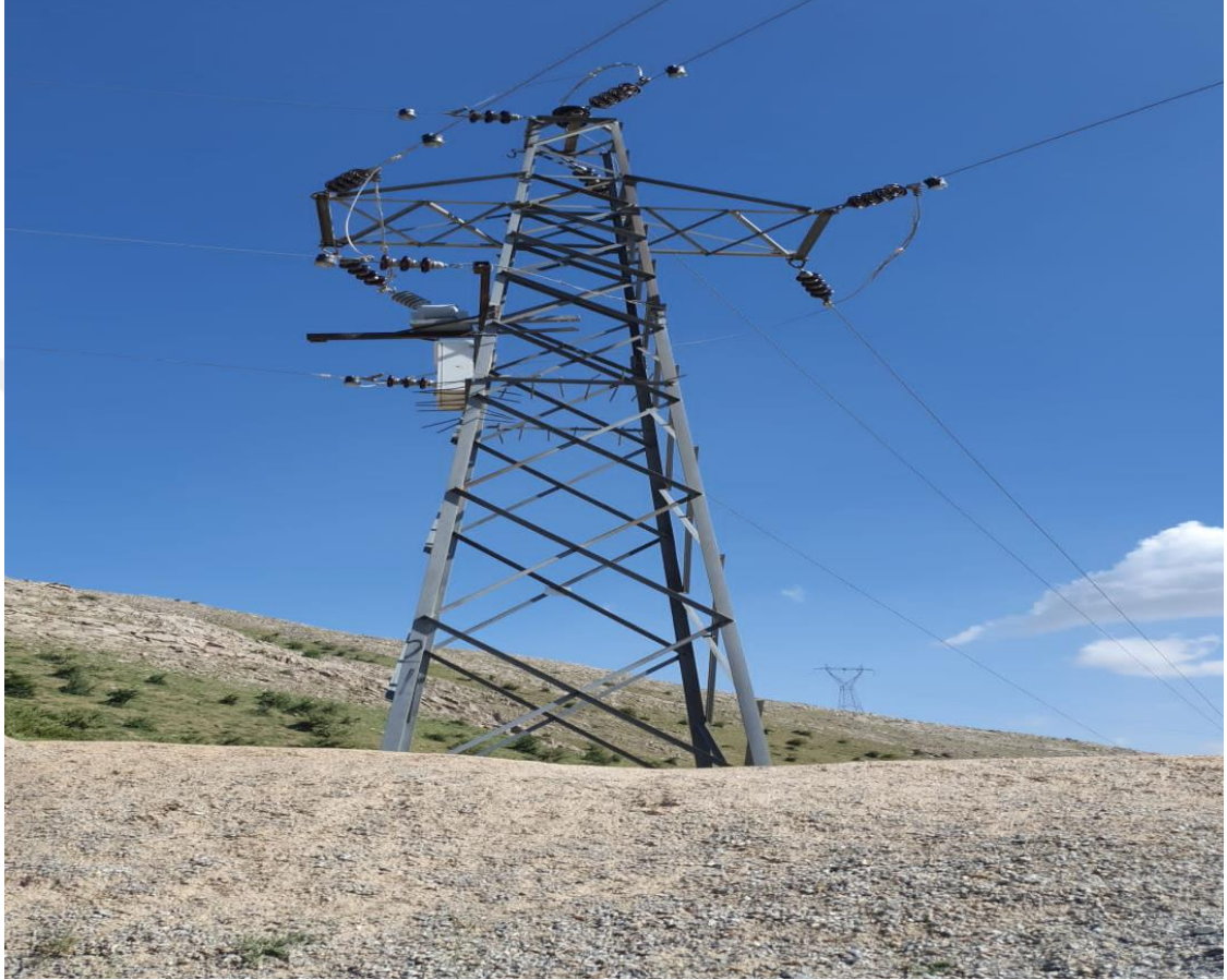
Şekil 3.13. Bitlis ili Hizan fiderinden bransman alan ve çıkışına takılan haberleşmeli arıza gösterge cihazının sahadaki montajı
