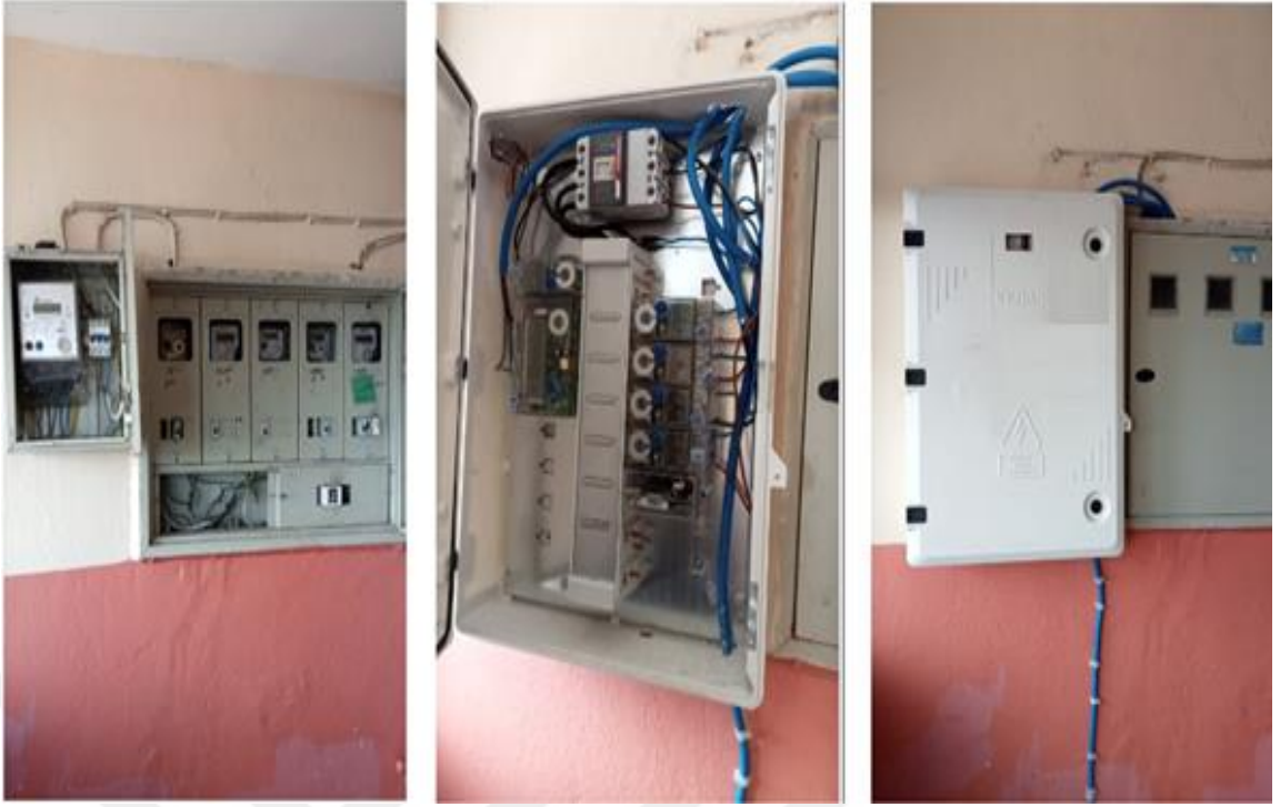
Şekil 3.18. Binalarda yatay elektrik panosuna sayaç montajı
