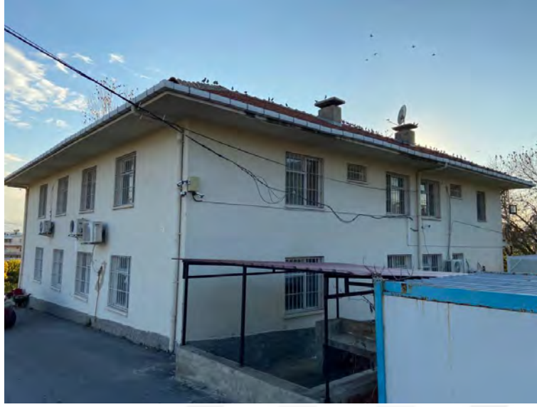
Şekil 5.12 Eski Smyrna kazı evi kuzeydoğu cephesi (Bora Ertüzün arşivi, 2021)
