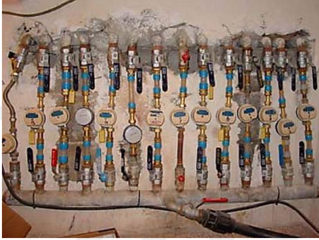
Şekil 2.21. Tasarım kriterlerine uygun olarak kurulmayan sayaçlar (Palau vd. 2018)
