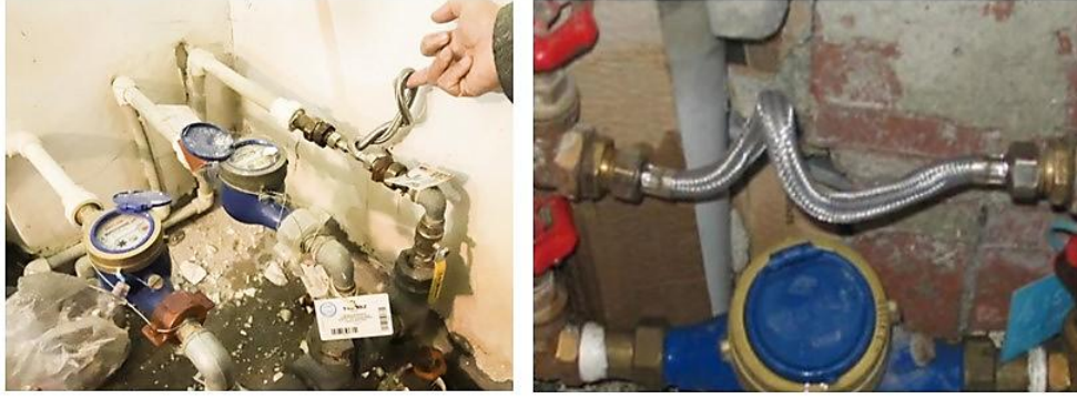
Şekil 2.7. Yasadışı bağlantı (Anonim 9-10)
