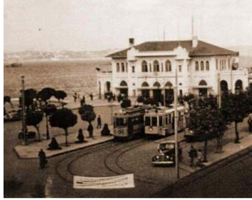
Şekil 5.3: Kadıköy İskele ve Tramvay hattı (Kadıköy Belediyesi, 2018).
