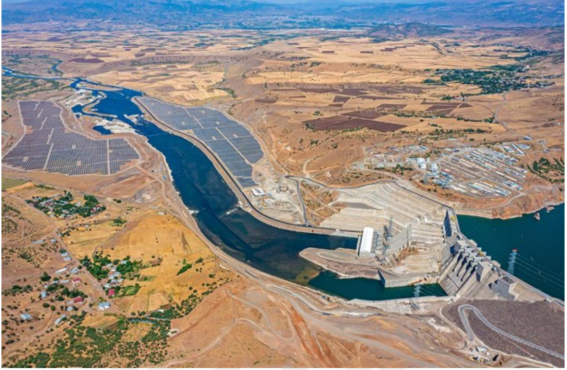
Şekil 3.6. Aşağı Kaleköy Barajı ve HES
