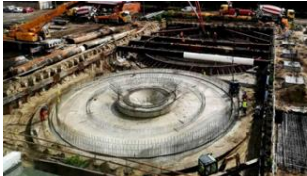
Şekil 2.3. Bir dairesel temelin inşası (Url-1).
