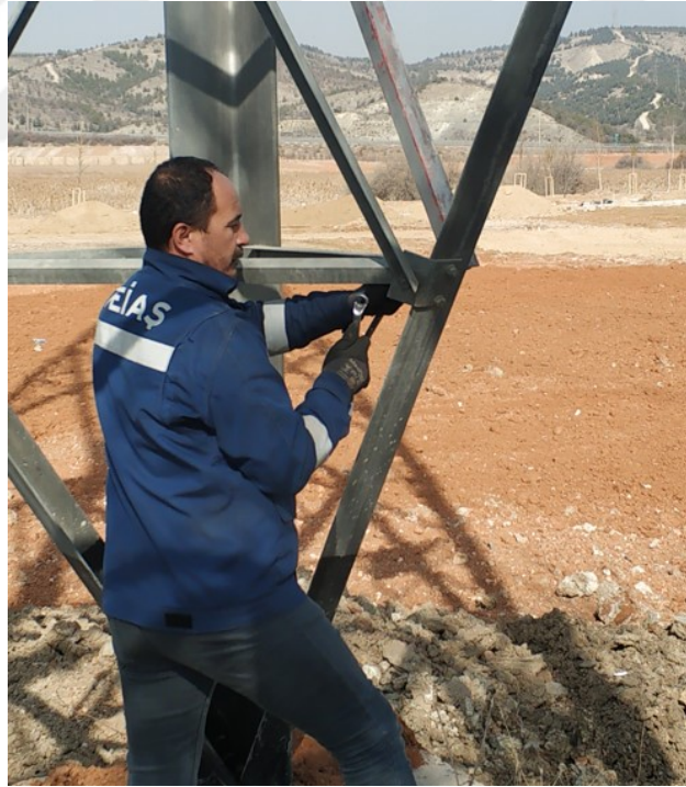
Şekil 2.3. Enerji taşıyan direkte el ile sökme işlemi
