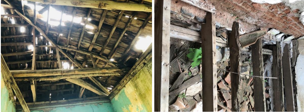
Şekil 5.68 Öğretmenevinin çatı taşıyıcı ve döşeme sistemi (İdeli Kişisel Arşivi, 2024)
