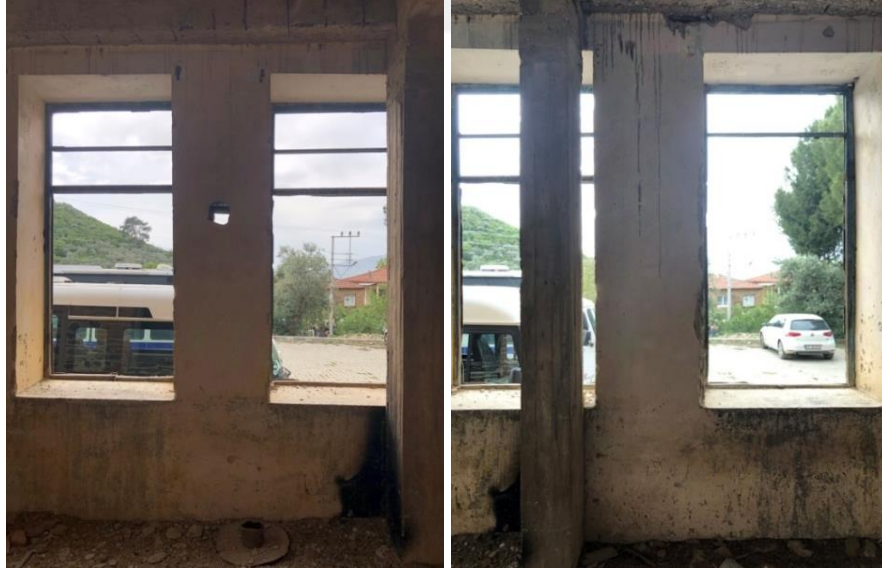
Şekil 5.20 ZK02 odasının batı cephesindeki pencere boşlukları (İdeli Kişisel Arşivi, 2024)
