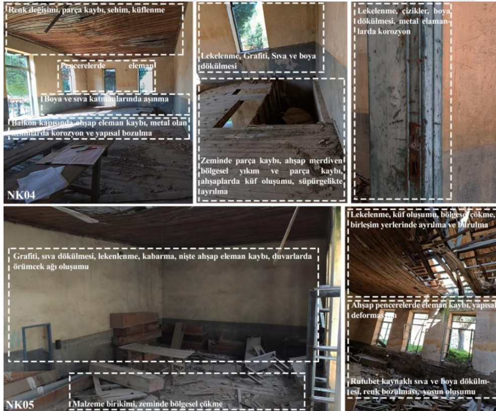
Şekil 5.57 Birinci kat NK04 ve NK05 bozulmaları (İdeli Kişisel Arşivi, 2024)
