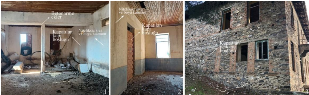
Şekil 6.7 Temizleme ve güçlendirme çalışması (İdeli Kişisel Arşivi, 2024)
