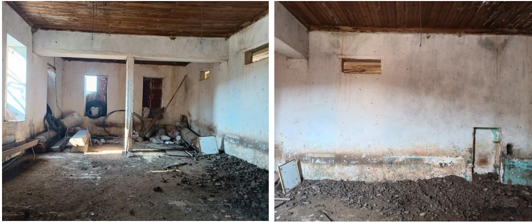
Şekil 5.30 NK06 dersliğinin batı cephesi (İdeli Kişisel Arşivi, 2024)
