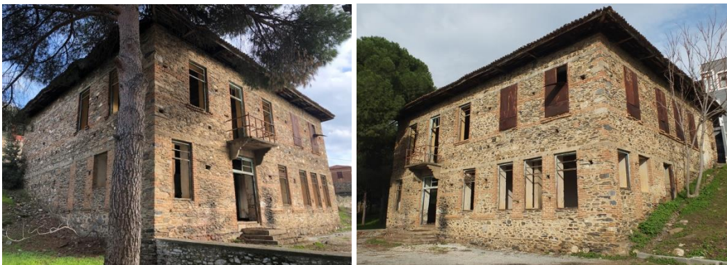
Şekil 5.32 Beton hatıldan kuşak, iskele boşlukları ve köşe birleşimleri (İdeli Kişisel Arşivi, 2024)
