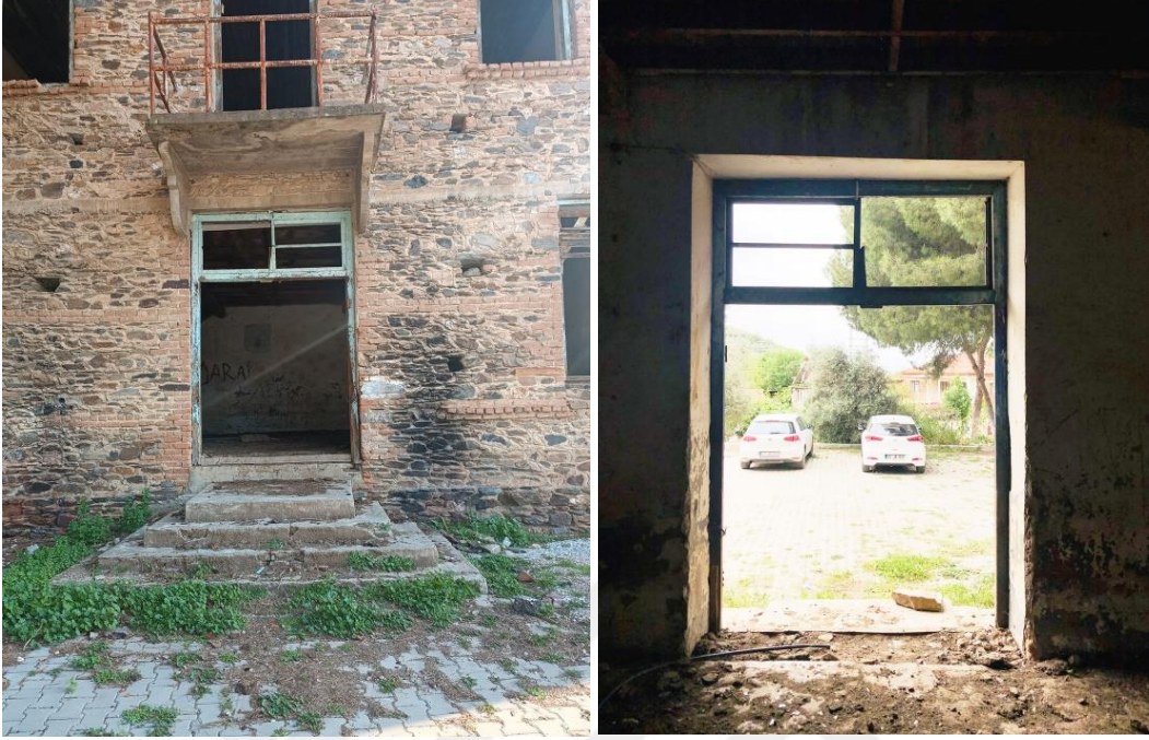
Şekil 5.15 Yapının ZK01’e açılan giriş kapısı ve merdiveni (İdeli Kişisel Arşivi, 2024)
