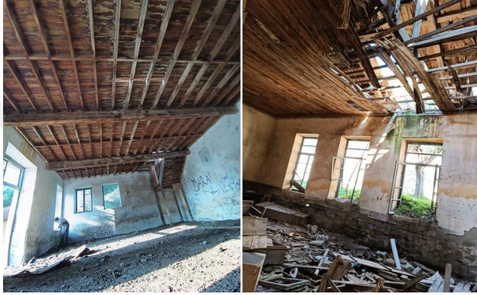
Şekil 6.6 ZK01 tavan döşemesi ve ZK05'in tavan ve zemin döşemesi (İdeli Kişisel Arşivi, 2024)
