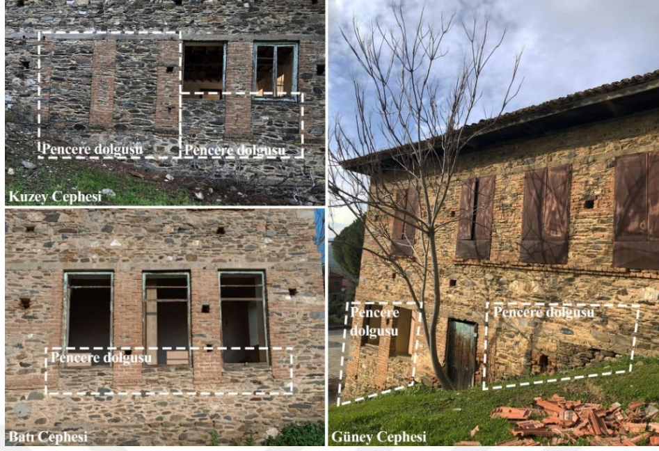
Şekil 5.63 Cephelerdeki pencere dolgu detayları (İdeli Kişisel Arşivi, 2024)
