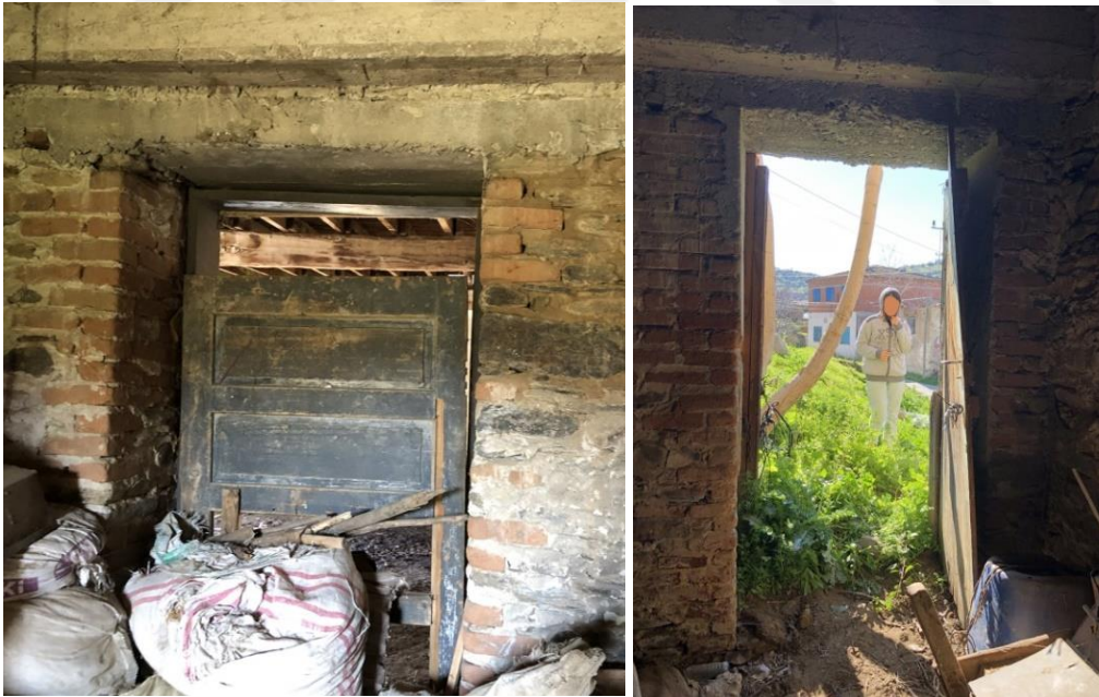
Şekil 5.22 ZK03 odasının kapı boşlukları (Sol görsel: Odanın iç mekân kapı boşluğu, Sağ görsel: dış mekâna açılan kapı boşluğu) (İdeli Kişisel Arşivi, 2024)
