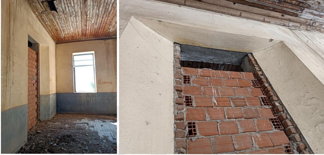
Şekil 5.27 Kapatılmış kapı boşlukları (İdeli Kişisel Arşivi, 2024)
