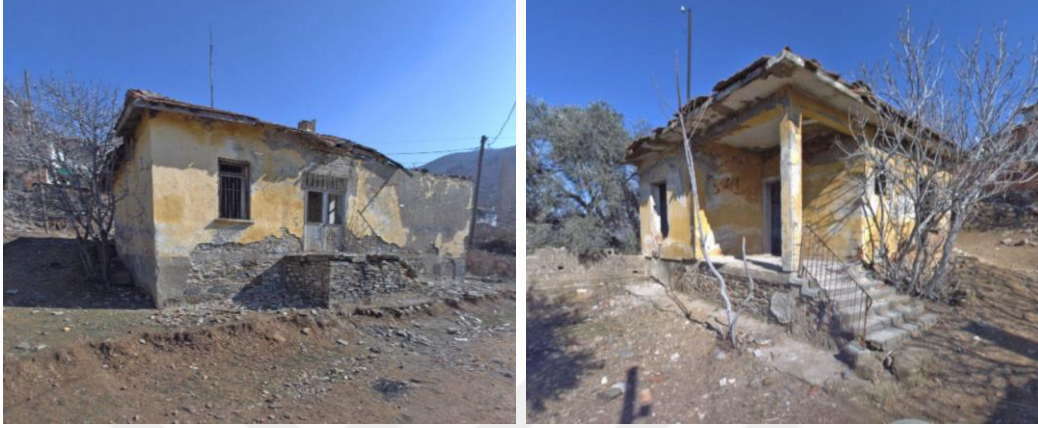
Şekil 4.5 Okul binası ve öğretmenevi (İzmir Kent Rehberi)
