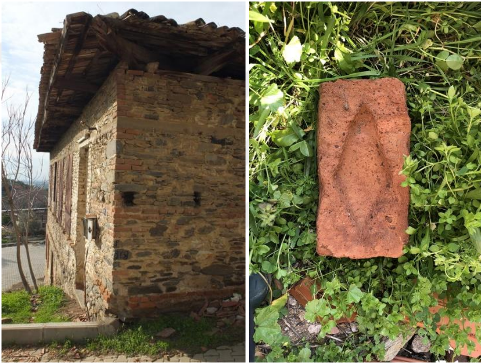
Şekil 5.33 Beton hatıldan kuşak, iskele boşlukları, köşe birleşim detayı ve yapıda kullanılan pişmiş tuğla (İdeli Kişisel Arşivi, 2024)
