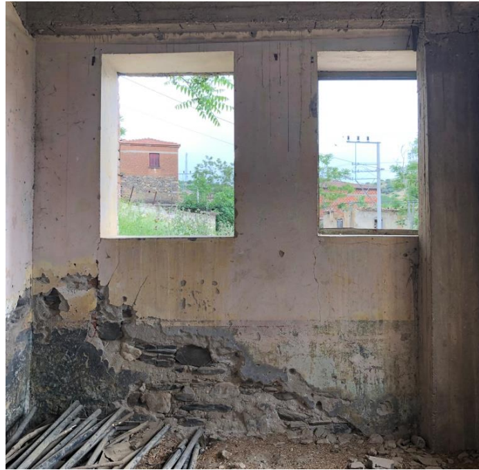
Şekil 6.10 Çatlak onarımı (İdeli Kişisel Arşivi, 2024)
