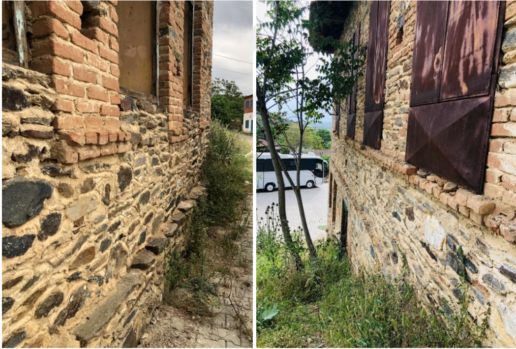
Şekil 5.45 Temel hizası ve birinci kat hizasından yapılan içeri çekmeler (İdeli Kişisel Arşivi, 2024)
