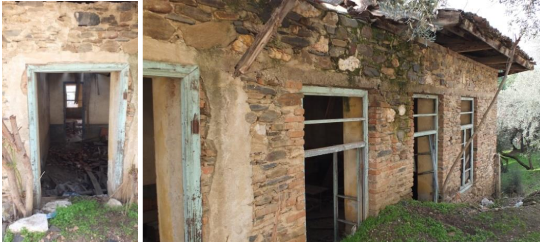
Şekil 5.44 Doğu cephesi (Sol görsel: Kapı kanadı takılan pencere boşluğu; Sağ görsel: yapının diğer pencereleri) (İdeli Kişisel Arşivi, 2024)
