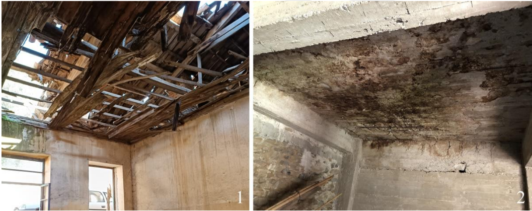
Şekil 6.11 Yapının döşemeleri (İdeli Kişisel Arşivi, 2024)
