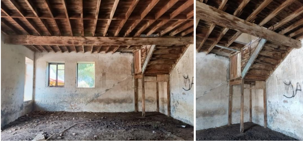
Şekil 5.18 ZK01'in kuzey cephesinde bulunan merdiven (İdeli Kişisel Arşivi, 2024)
