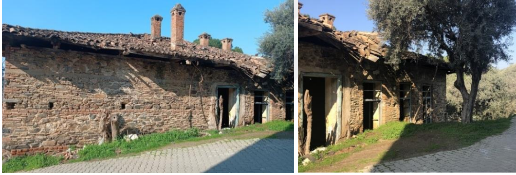
Şekil 5.86 Doğu cephesi (İdeli Kişisel Arşivi, 2024)
