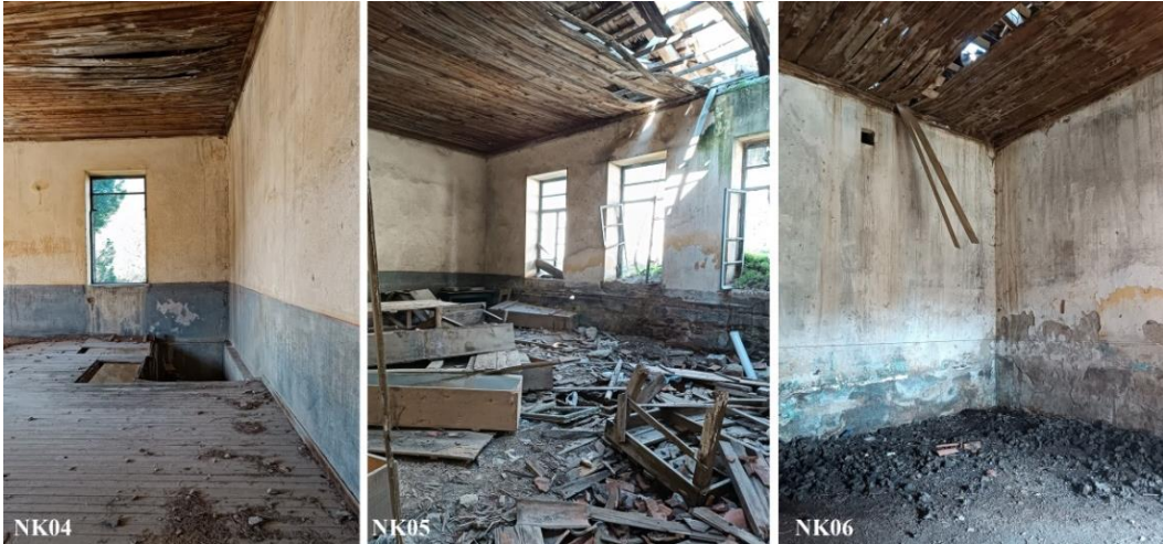
Şekil 5.48 Birinci katta bulunan mekânların zemin döşemeleri (İdeli Kişisel Arşivi, 2024)
