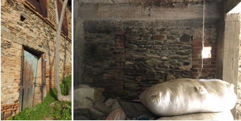
Şekil 5.23 ZK03 odasının güney cephesindeki kapısı ve kapatılan pencerelerinden biri (İdeli Kişisel Arşivi, 2024)
