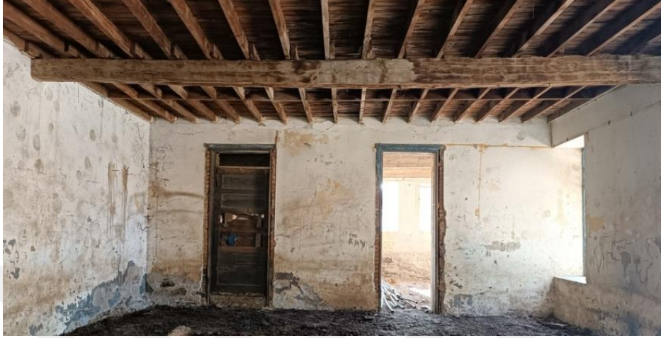
Şekil 5.17 ZK01'in doğu cephesinde olan kapı boşlukları (İdeli Kişisel Arşivi, 2024)
