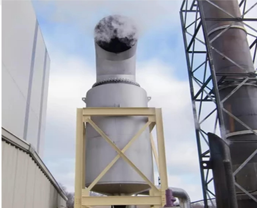
Şekil 2.17. Susturucu Blöf Tankı
