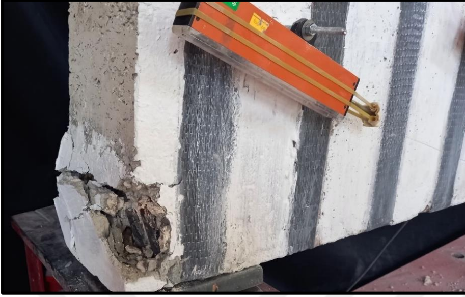
6.21. Sol mesnette oluşan beton ezilmesi
