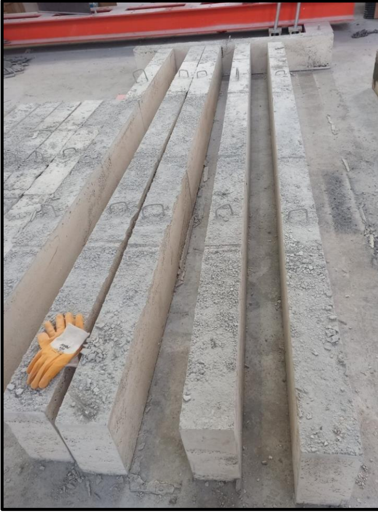
Resim 5.8. Kirişlerin kalıptan çıkarılması
