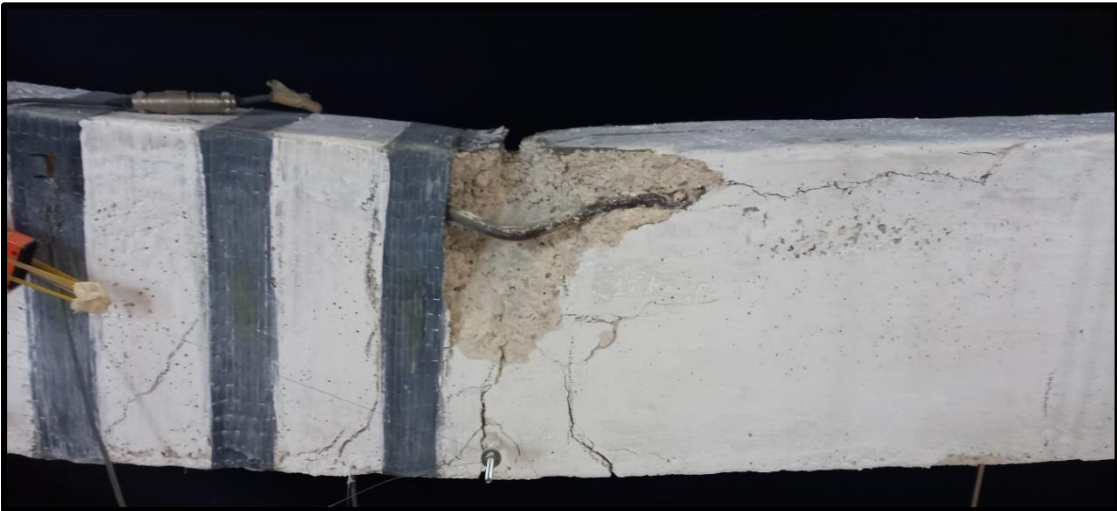
Resim 6.17. Kirişte bulunan boyuna donatının burkulması ve betonun ezilmesi
