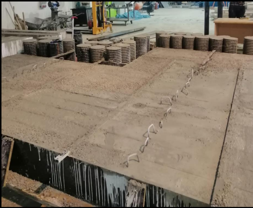
Resim 5.7. Hazır beton dökümünün tamamlanması
