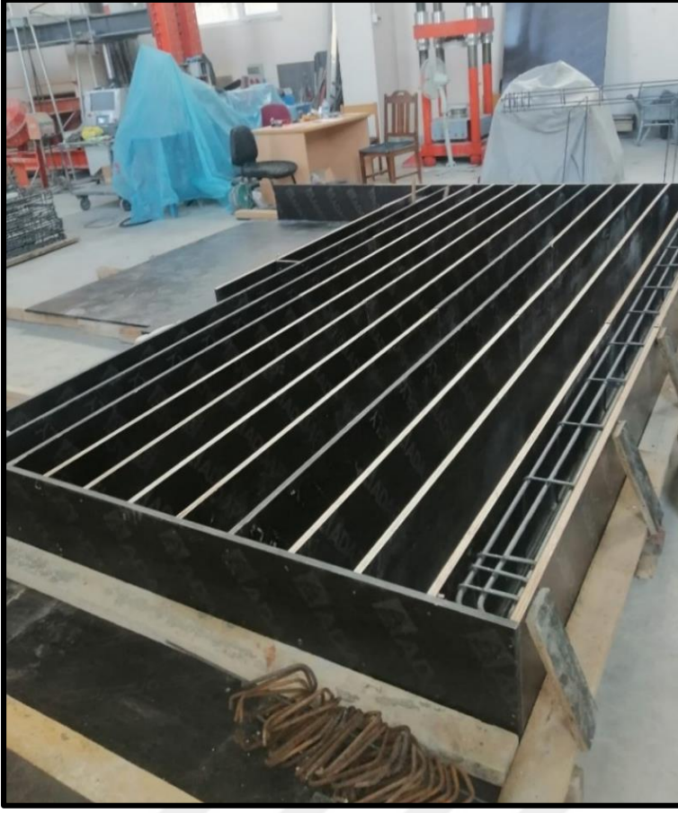
Resim 5.4. Kalıpların hazırlanması
