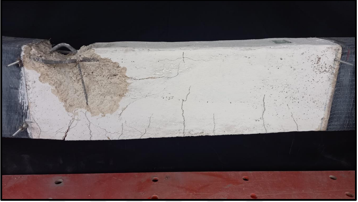
Resim 6.8. Kirişte oluşan eğilme çatlakları, boyuna donatının burkulması ve betonun ezilmesi
