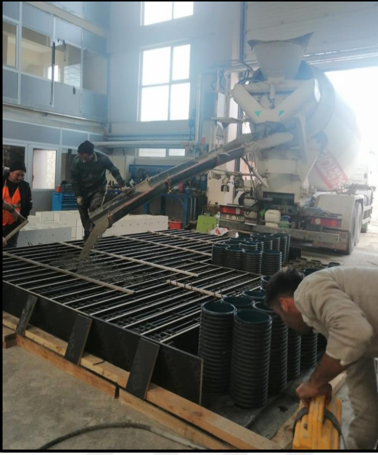
Resim 5.6. Hazır beton dökümünün yapılması
