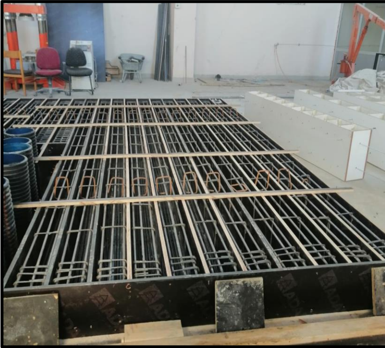
Resim 5.5. Kalıplara donatıların yerleştirilmesi
