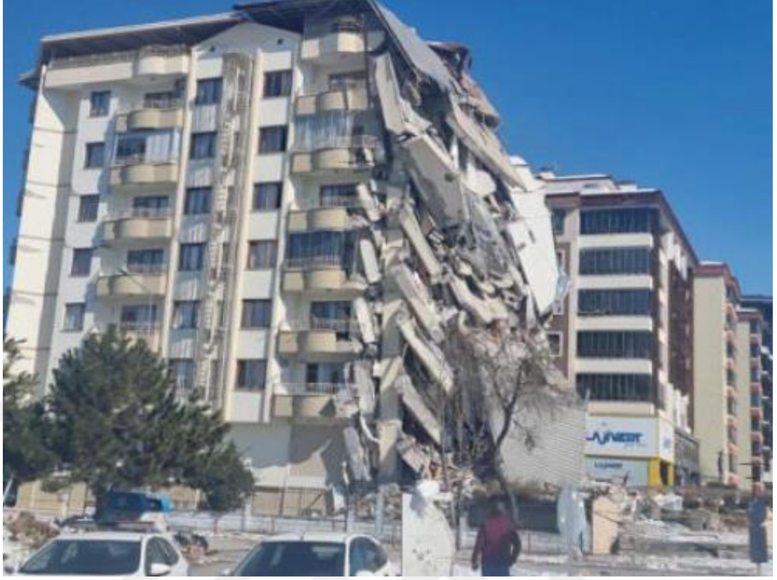
Şekil 4.53. Döşeme süreksizliği nedeniyle hasar alan bir yapı
