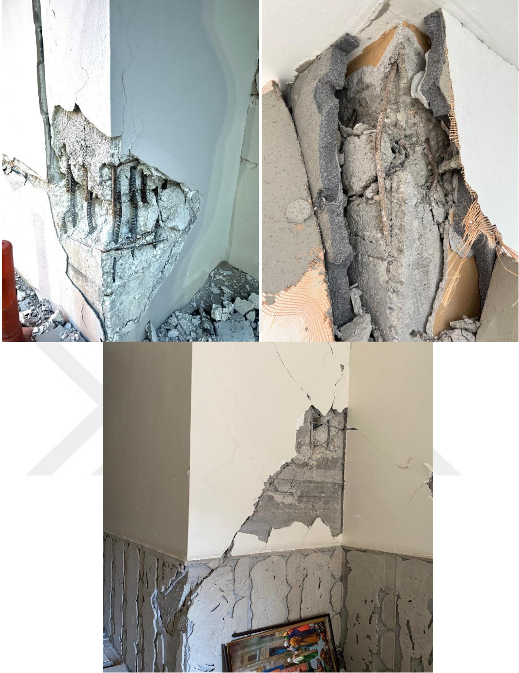
Şekil 4.10. Kolonlarda basınç kırılmalarına ilişkin örnek bir görünüm
