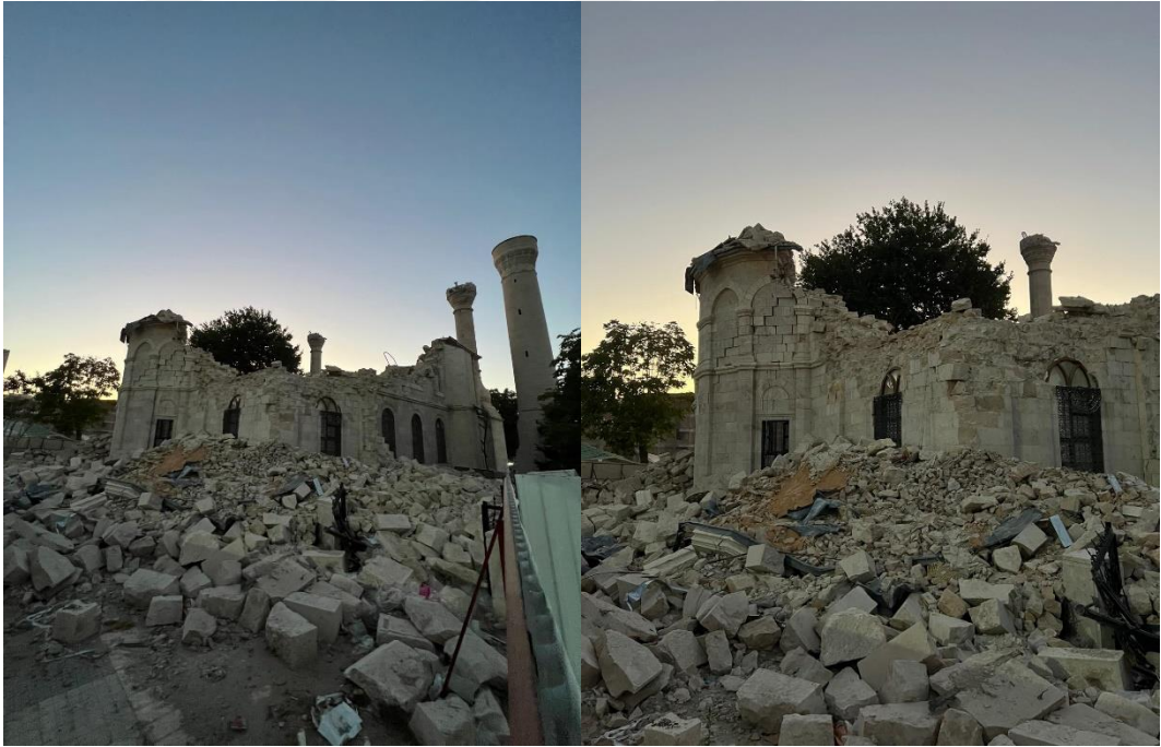
Şekil 4.34. Zemin sıvılaşması nedeniyle ağır hasar alan yapı
