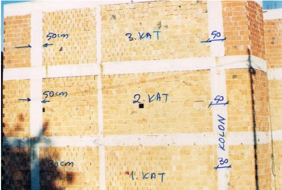
Şekil 4.59. Taşıyıcı sistem düşey elemanlarının süreksizliği
