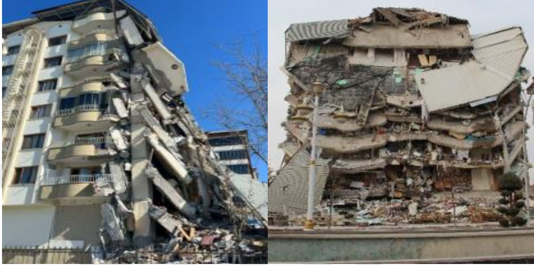
Şekil 4.52. Malatya’da çıkmalar nedeniyle kısmen yıkılan yapılar (Yeşilyurt)
