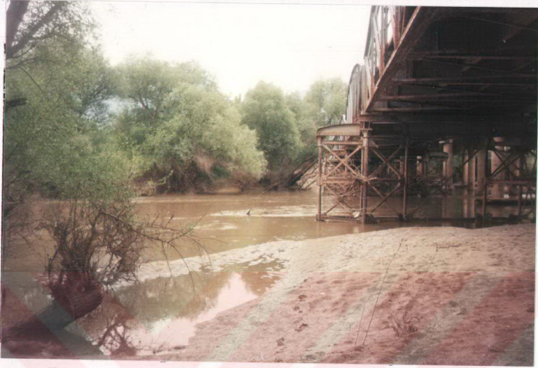
Sekil 3.3: İstanbul Yolu Gediz Köprüsü
