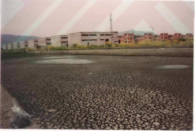
Şekil 3.6: Belediye Arıtım Tesisleri (Çamur Kurutma Havuzları)
