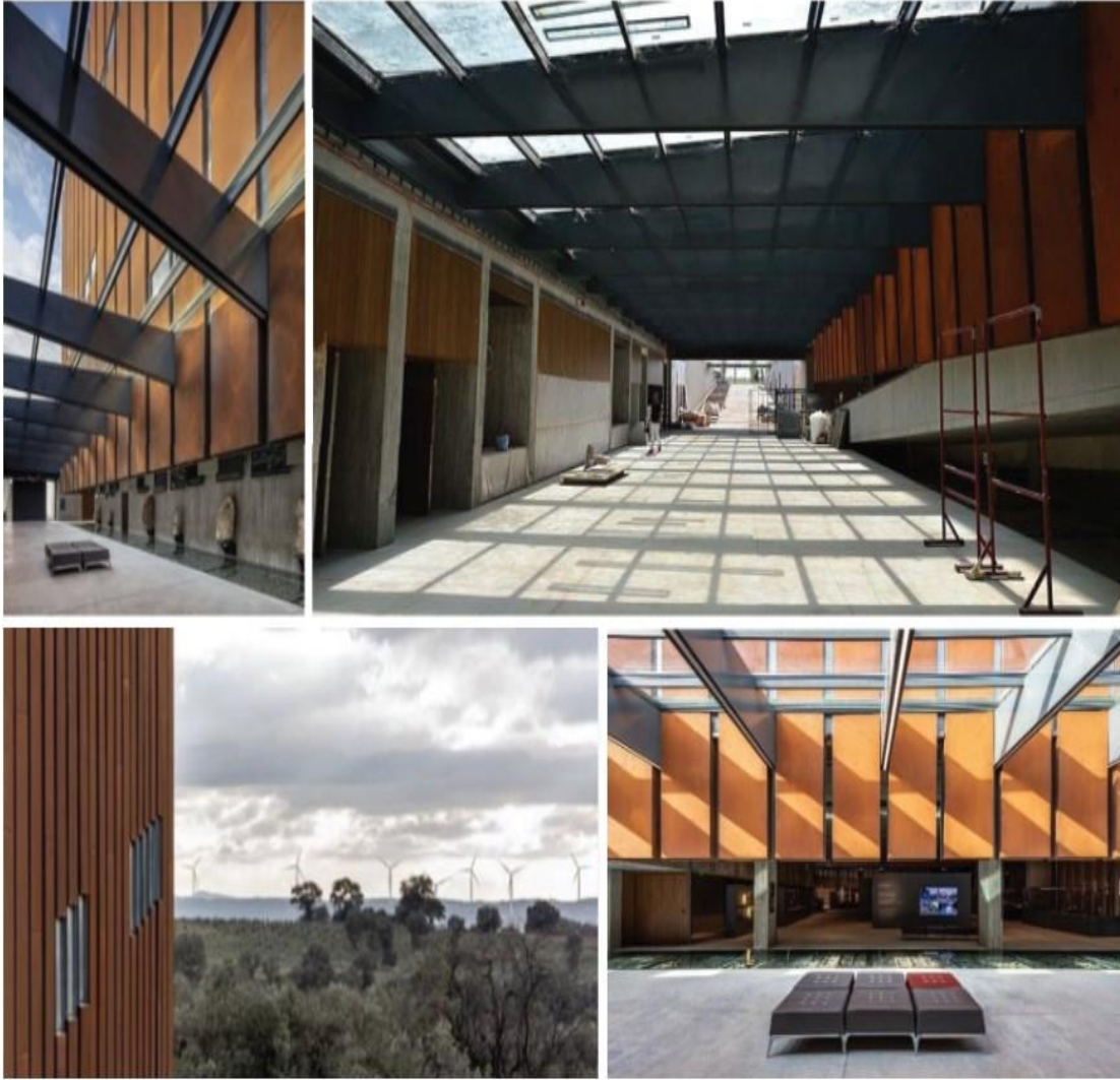
Şekil 4.9: Troya Müzesi Korten Çelik Cephe Panelleri, Kuyrukçu(2021)
