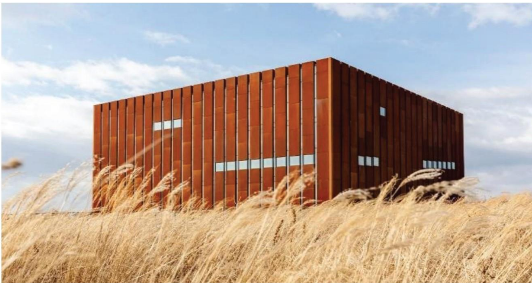
Şekil 4.10: Troya Müzesi Korten Çelik Cephe Panelleri, Kuyrukçu(2021)
