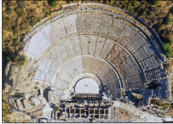
Şekil 5.6 2018-2021 yılları arası yapılan koruma ve onarım çalışmalarından sonra tiyatro genel görünüm (KVMGM Arşivi, 2021)
