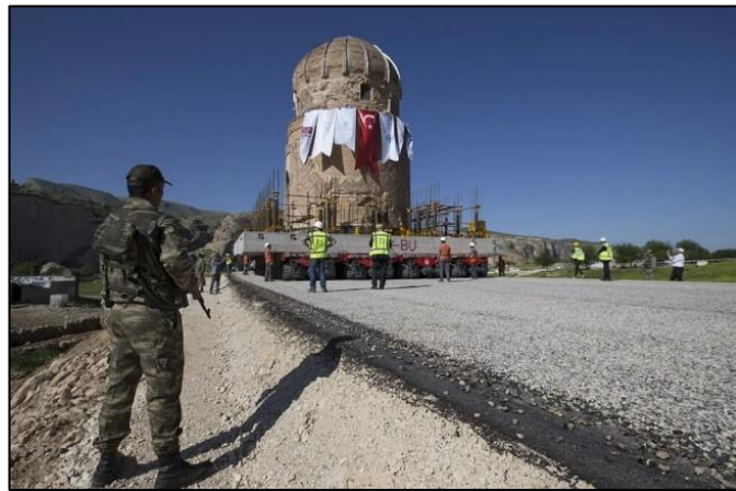
Şekil 4.15 Zeynel Bey Türbesi'nin SPMT sistemiyle arkeopark alanına taşınması (NTV Haber, 2017)
