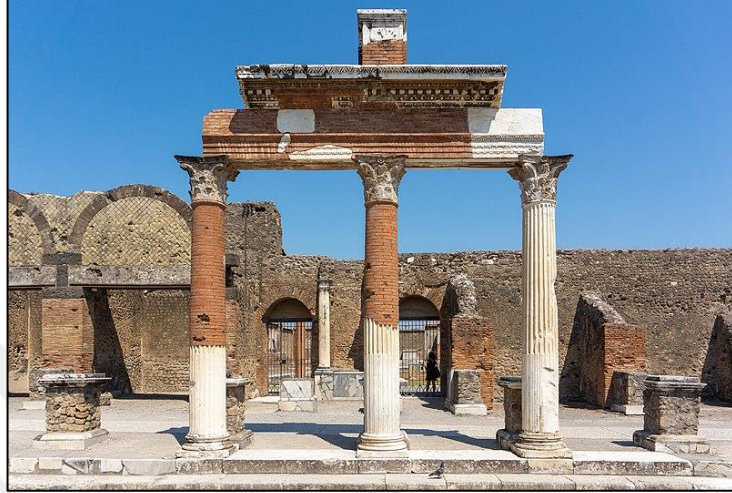
Şekil 5.3 1930’larda Pompeii Forumu’nda harman tuėla ile bütönlöme yapılmış taş sütunlar (Wikipedia, 2024)
