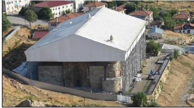
Şekil 4.5 Divriği Ulu Cami restorasyonu sırasında kurulan geçici koruma çatısı (Yapı Haber Portalı, 2019)
