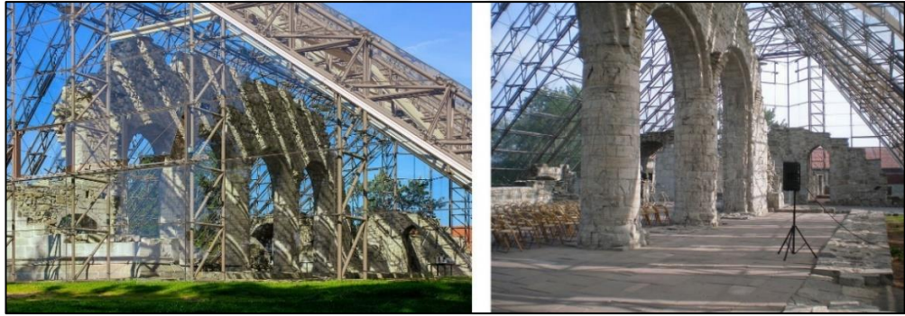
Şekil 4.7 Cam ve çelik malzeme kullanılarak yapılan Hamar Katedrali kalıcı çatı örtüsü (Wikipedia, 2024)
