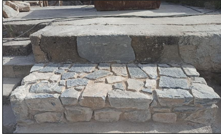
řekil 5.17 Numune-4: Hidrolik kire esaslı har ile moloz tař tamamlama (KVMGM Arřivi, 2021)
