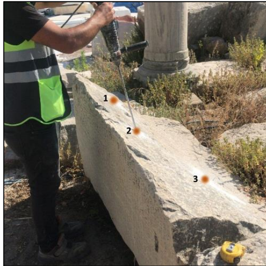
Şekil 4.19 Güçlendirme için donatı yerinin hazırlanması (KVMGM arşivi, 2021)
