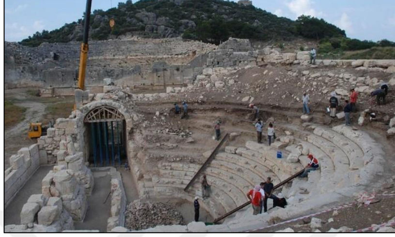
Şekil 5.69 Patara Meclis Binası theatron bütünleme öncesi genel durum (Arkitera, 2010)
