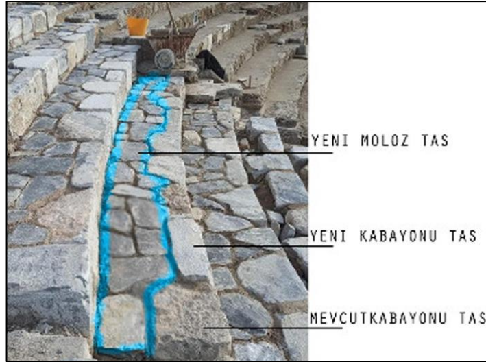
Şekil 5.21 2018-2021 yılları arasında yapılan cavea tamamlamalarına örnekler (KVMGM Arşivi, 2021. Uyarlama: Birce Yılmaz)
