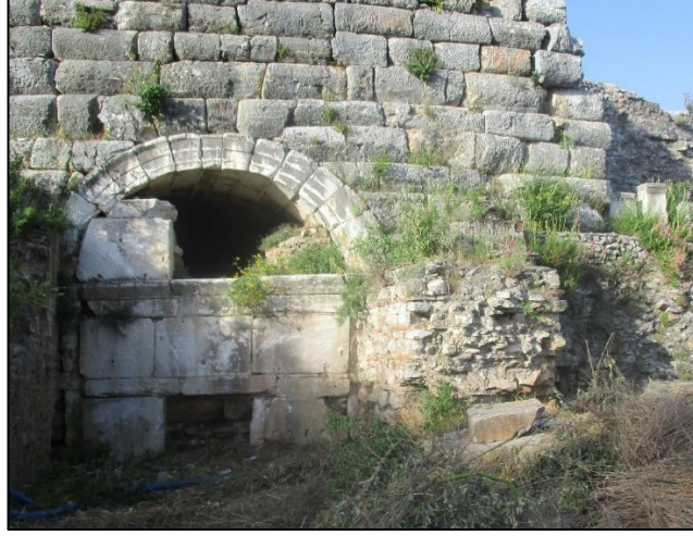
Şekil 3.10 Efes antik tiyatrosu geç Bizans döneminde kapatılmış kuzey analemma duvarı vomitoryum tonozlu giriş (KVMGM arşivi, 2019)
