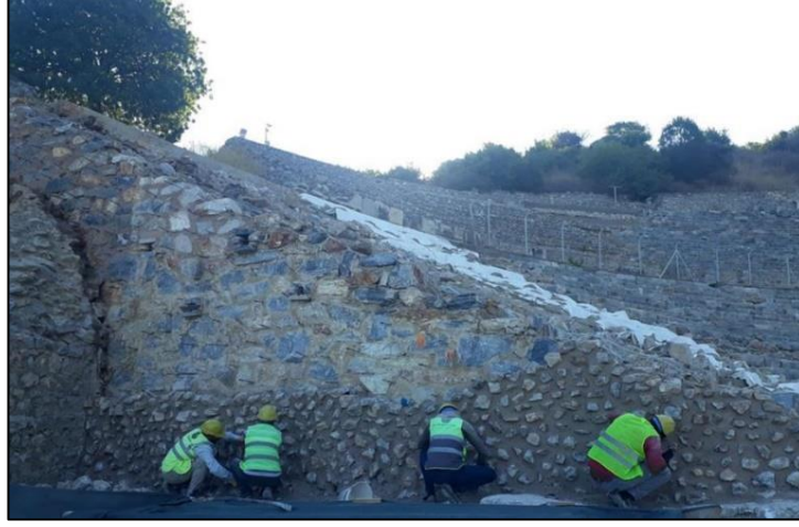
Şekil 4.21 M4 Cavea taşıyıcı alt strüktür sonrası cavea altyapı moloz taş dolgu örgüsü (KVMGM arşivi, 2021)
