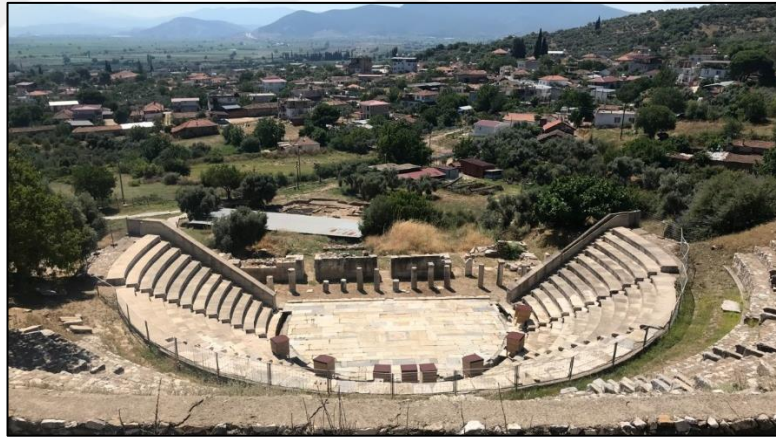
Şekil 3.21 Metropolis tiyatrosu ahşap strüktürle korumaya alınmış prohedrialar (Birce Yılmaz, 2019)
