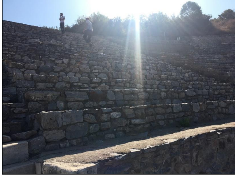
Şekil 5.13 Summa cavea 70'li yıllarıda yapılan çimento ve moloz taş malzemeli tamamlamalar (KVMGM Arşivi, 2021)
