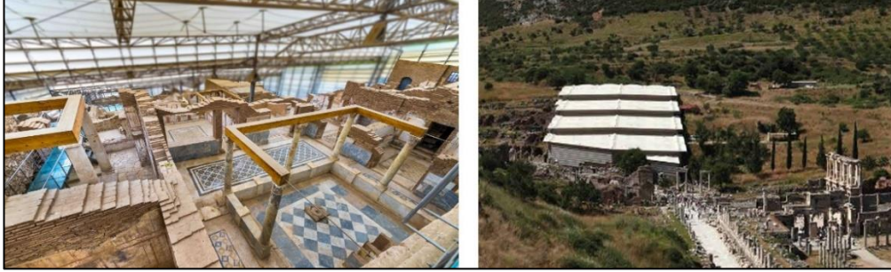
Şekil 4.6 Efes Yamaç evler kalıcı koruma çatı örtüsü, solda iç görünüş sağda dış görünüş (Kültürportali, 2024)
