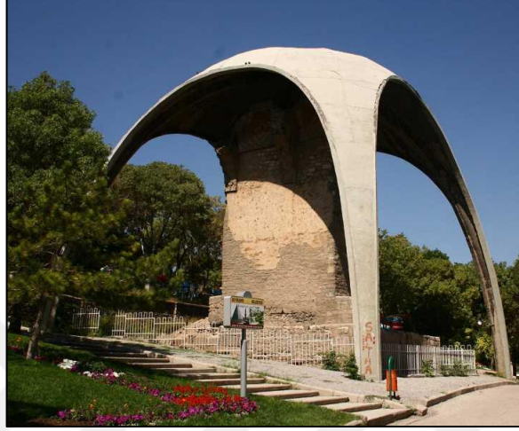
řekil 4.9 60'lı yıllarda betonarme kabuktan oluřan koruma atısı (Kltrportalı, 2024)
