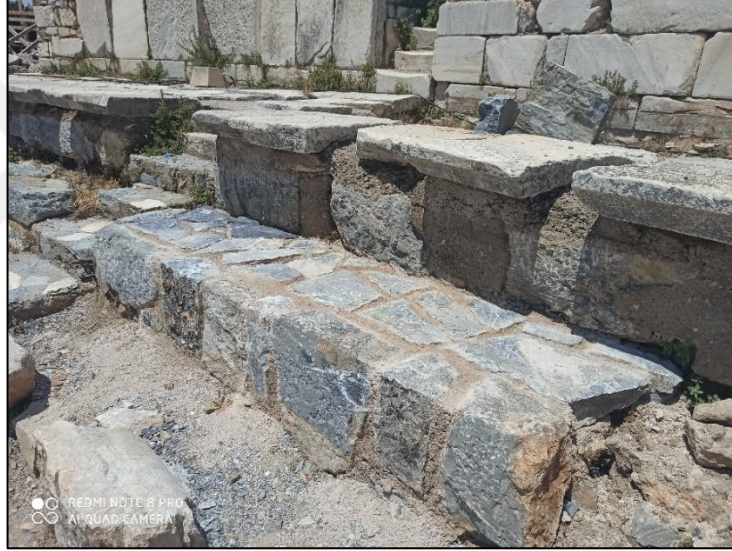
Şekil 5.19 Numune-6: Hidrolik kireç esaslı harç ile kabayonu taş tamamlama (KVMGM Arşivi, 2021)
