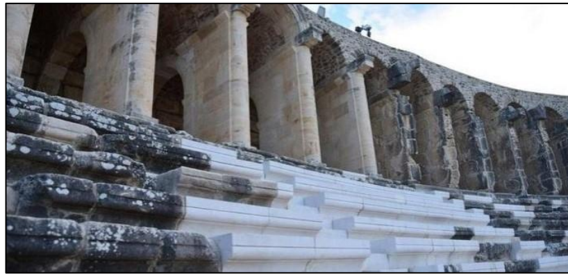
Şekil 5.38 Aspendos Antik Tiyatrosu cavea bütünleme çalışmaları sonrası özgün ve yeni taş görünümü (Agos Gazetesi, 2015)
