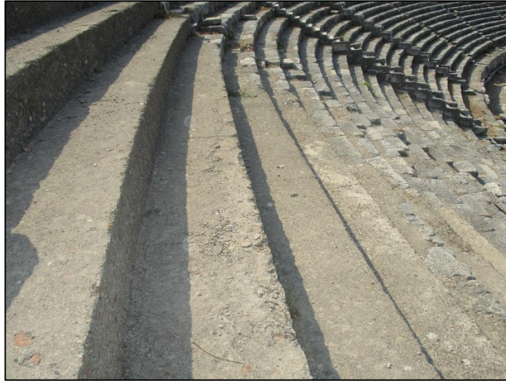
Şekil 5.4 Efes Antik Tiyatrosunda 70’li yıllarda beton malzeme ile cavea bütönlöme alışmaları (KVMGM, 2018)
