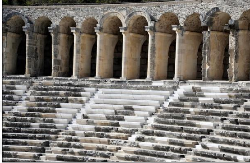
Şekil 5.5 2013 yılında başlayan çalışmalarda aynı malzeme ile tamamlama yapılan Aspendos Tiyatrosu (Arkeofili, 2015)
