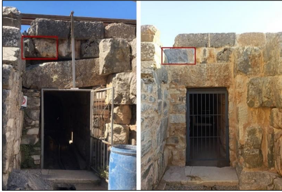
Şekil 4.23 Efes Antik Tiyatro sahne yapısı kuzey giriş kısım birim elemanda yenileme (KVMGM arşivi, 2021)
