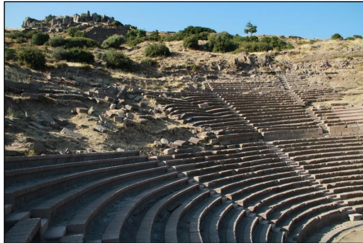
Şekil 5.59 Assos Tiyatrosu 2010 yılı theatron kısmı deprem sonucunda zarar gören kısım (Erkmen Senan Kişisel Arşivi, 2010)
