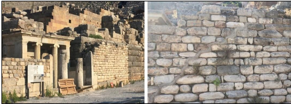
Şekil 4.24 Yenileme çalışmasının belirtme derziyle ayrılması (Birce Yılmaz, 2020)
