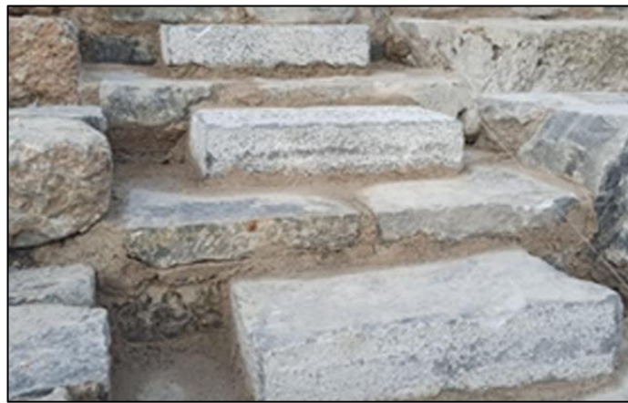
Şekil 5.22 2018-2021 yılları arasındaki çalışmalarda yonutaşı ile oluşturulmuş basamaklar (KVMGM Arşivi, 2021)
