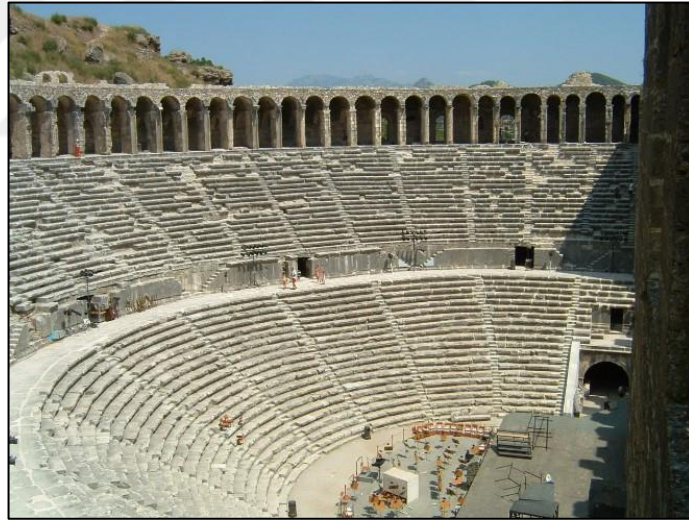
Şekil 5.36 Aspendos Antik Tiyatrosu cavea bütünlendirme çalışmaları öncesi genel görünüm (DÖK Mimarlık Arşivi, 2020)
