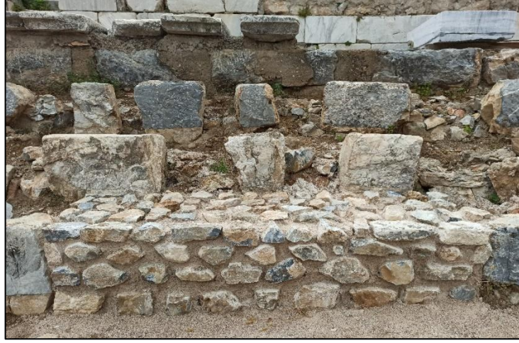
Şekil 5.18 Numune-5: Hidrolik kireç esaslı harç ile moloş taş tamamlama (KVMGM Arşivi, 2021)
