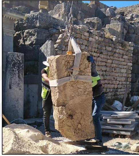
Şekil 4.13 Efes Antik Tiyatrosu sahne yapısı mimari elemanın konservasyon uygulaması için kum havuzuna taşınması (KVMGM Arşiv, 2021)
