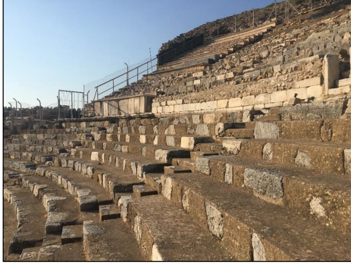
Şekil 5.11 İma cavea 70'li yıllarıda yapılan çimento malzemeli tamamlamalar (KVMGM Arşivi, 2021)
