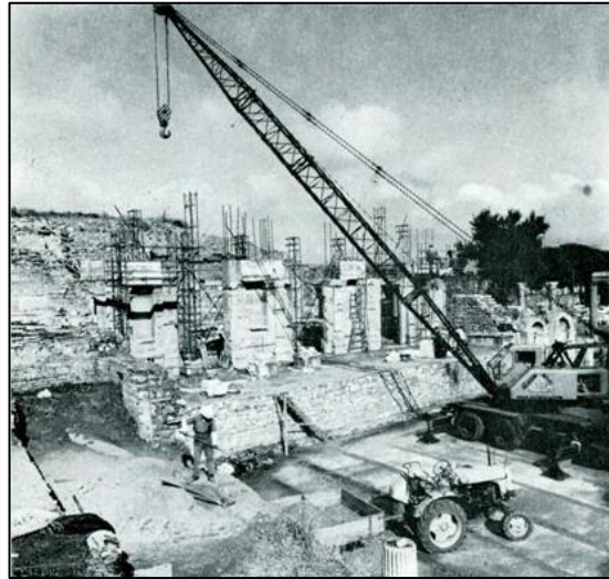
Şekil 4.29 Efes Celsus Kütüphane binasının ön cephesinde 1970’lerde yapılan rekonstrüksiyon çalışmaları (Strocka, 1979)
