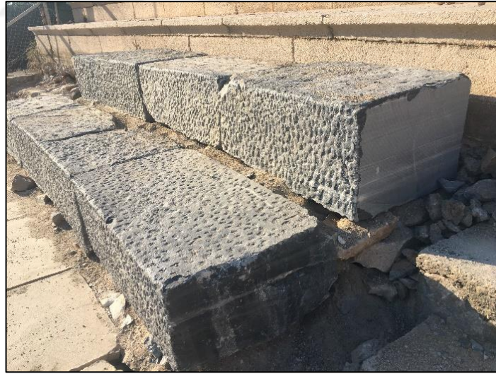
Şekil 5.15 Numune-1: Özgün taş malzeme ile monoblok taş tamamlama (KVMGM Arşivi, 2021)
