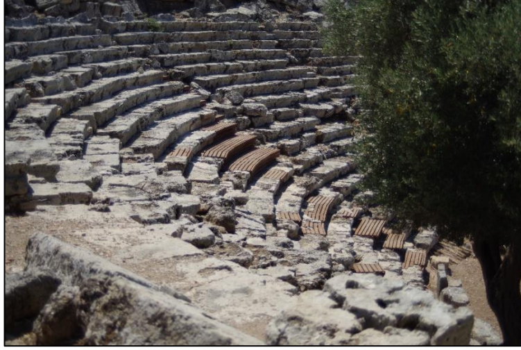
Şekil 5.30 Kaunos antik tiyatrosu ahşap malzeme ile bütünleme çalışması (Birce YILMAZ, 2022)
