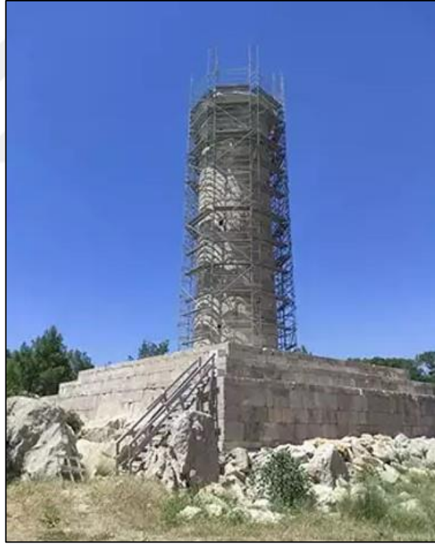
Şekil 4.28 Patara Deniz Feneri günümüzde devam eden anastylosis çalışmaları (Milliyet Gazetesi, 2024)
