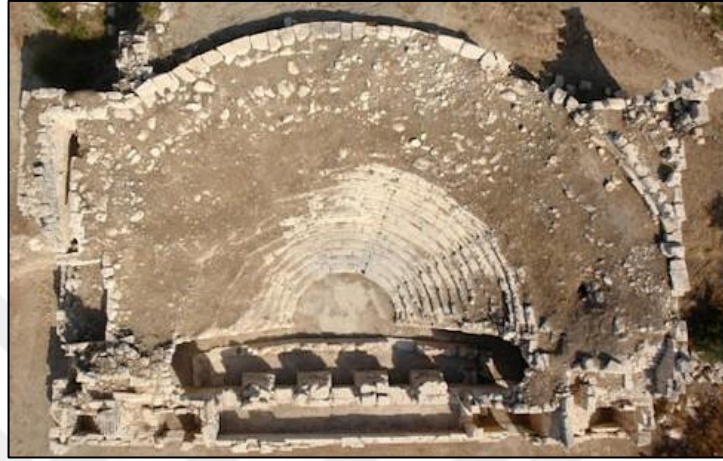
Şekil 5.68 Patara Meclis Binası koruma ve onarım çalışmaları öncesi (Arkitera, 2009)
