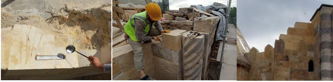
Fotoğraf 4.62. Duvar örme uygulaması (VGM Rapor)
