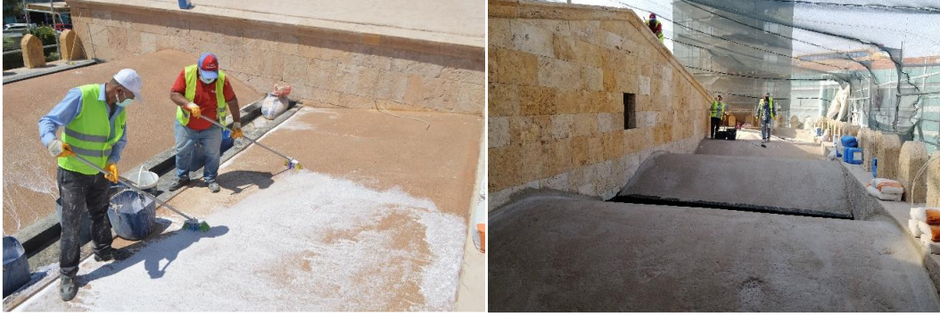
Fotoğraf 4.37. Sürme su yalıtımı uygulaması (VGM Rapor)
