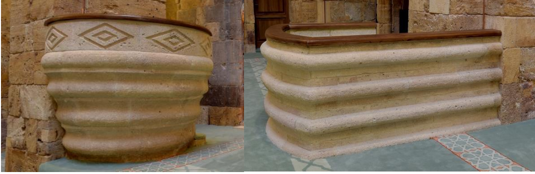
Fotoğraf 4.92. Vaaz kürsüsü ahşap ekleme uygulaması (VGM Rapor)
