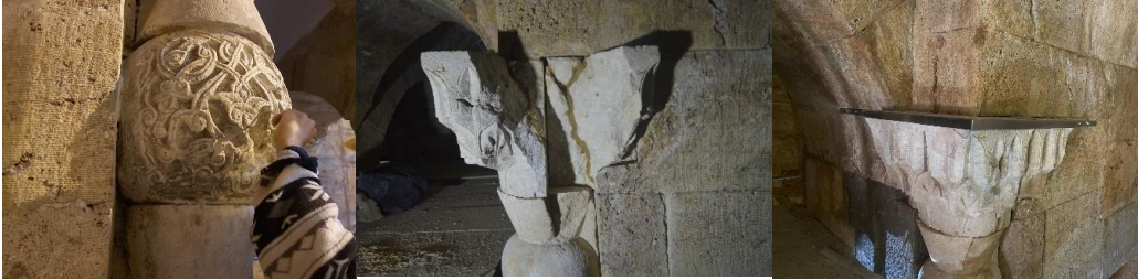
Fotoğraf 4.67. Kenet elemanlarının onarımı (VGM Rapor)
