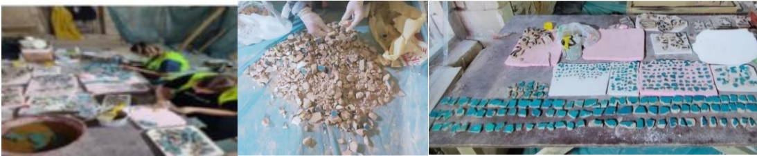
Fotoğraf 4.72. Çini yapıştırma uygulaması (VGM Rapor)
