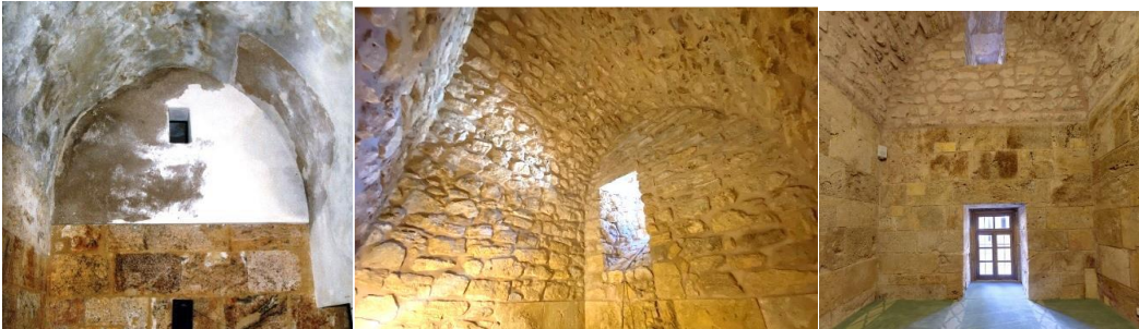
Fotoğraf 4.26. Kesme ve moloz taş yüzeylerine derz uygulaması (VGM Rapor)
