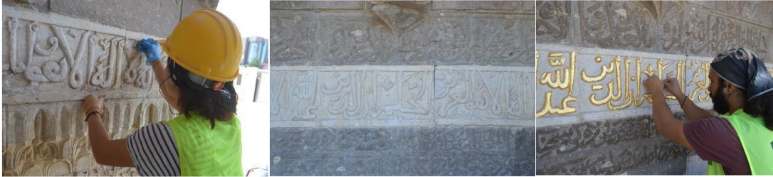
Fotoğraf 4.60. Altın varak kaplama uygulaması (VGM Rapor)
