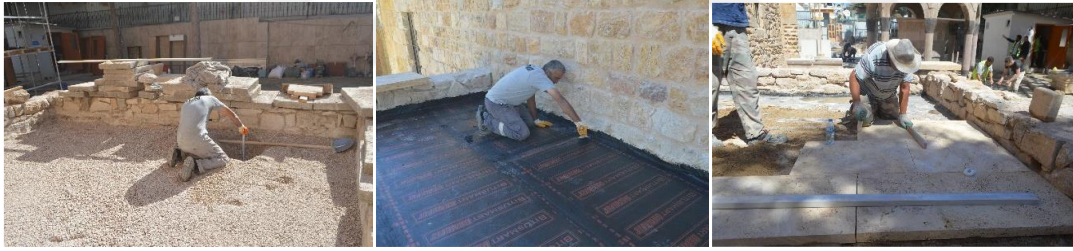
Fotoğraf 4.21. Traverten yonu taş uygulaması (VGM Rapor)
