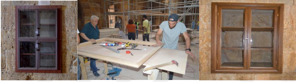
Fotoğraf 4.90. Kitaplık ahşap kısımlar restorasyon uygulaması (VGM Rapor)
