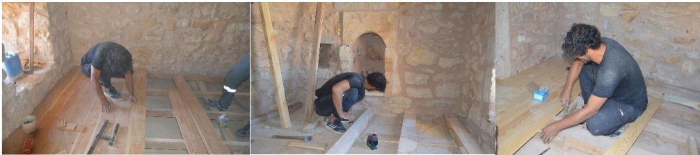
Fotoğraf 4.29. Kadronlu ahşap döşeme uygulaması (VGM Rapor)
