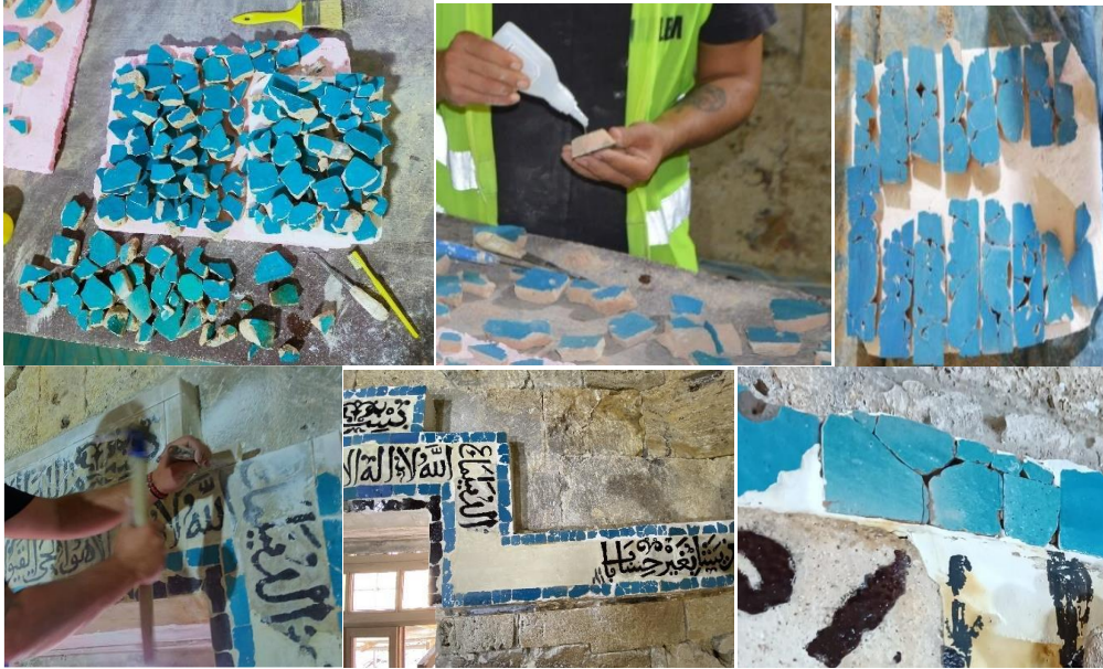
Fotoğraf 4.74. Çini yapıştırma uygulaması (VGM Rapor)
