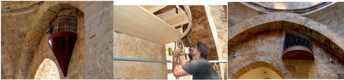
Fotoğraf 4.91. Mahfil balkonu ahşap kısımlar restorasyon uygulaması (VGM Rapor)
