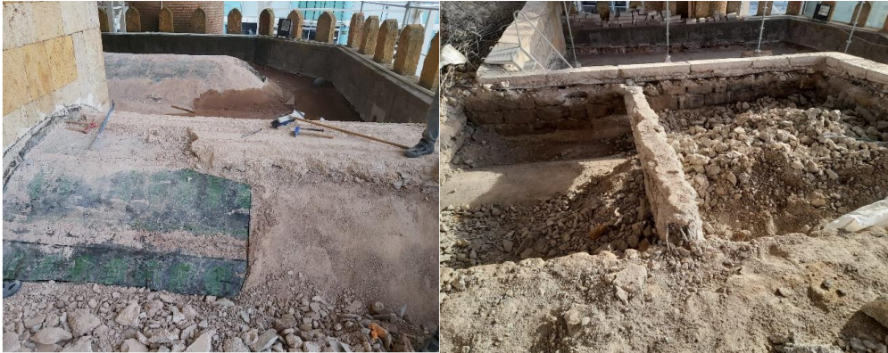
Fotoğraf 4.31. Çimento kaplamanın kaldırılması (VGM Rapor)
