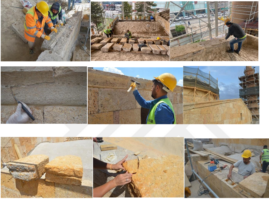
Fotoğraf 4.43. Çatı duvarındaki profil silme taşların restore uygulaması (VGM Rapor)
