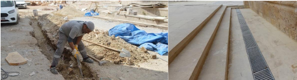
Fotoğraf 4.3. Yağmur kanalları için galvaniz kaplı ızgaraların döşenmesi (VGM Rapor)
