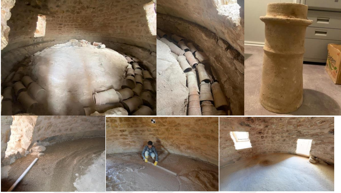
Fotoğraf 4.44. Künklerin bakımı ve onarımı uygulaması (VGM Rapor)
