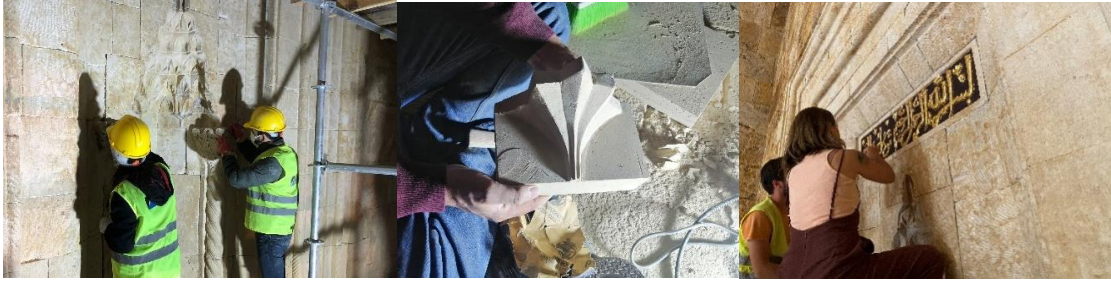
Fotoğraf 4.68. Kitabe onarım/boyama uygulamaları (VGM Rapor)
