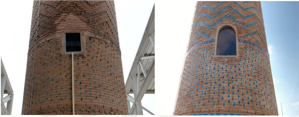
Fotoğraf 4.13. Lamine temperli cam uygulaması (VGM Rapor)
