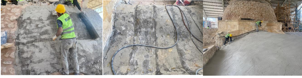
Fotoğraf 4.34. Kubbe ve tonozların özel harç ile kaplanması (VGM Rapor)
