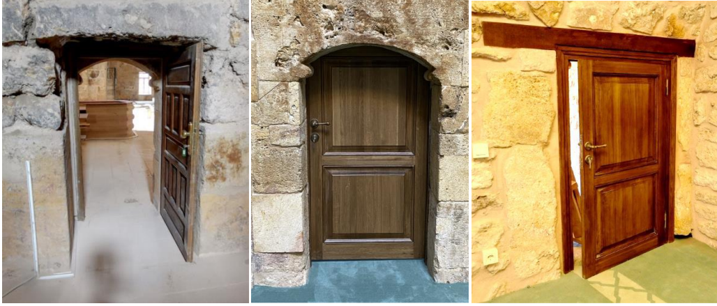
Fotoğraf 4.87. İç kapı restorasyon uygulaması (VGM Rapor)
