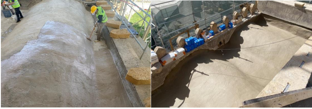
Fotoğraf 4.35. Su yalıtımı uygulaması (VGM Rapor)
