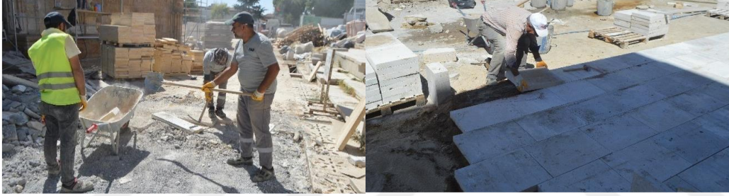
Fotoğraf 4.2. Medrese girişindeki taşların sökülerek yenilenmesi (VGM Rapor)
