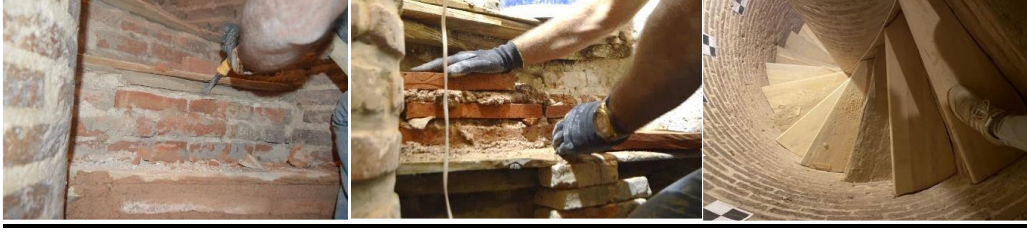
Fotoğraf 4.12. El yapımı tuğla ve harçlama işlemi (VGM Rapor)
