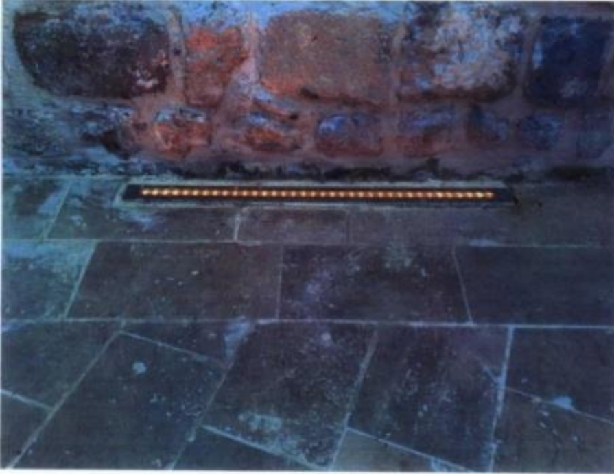
Fotoğraf 3.24. Led Armatür (36'li) (VGM Rapor)
