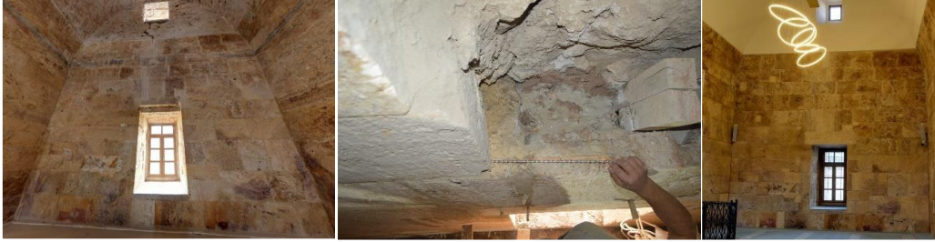
Fotoğraf 4.28. Duvar örgüsü ve enjeksiyon uygulaması (VGM Rapor)
