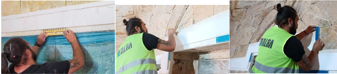
Fotoğraf 4.77. Çini montaj uygulaması (VGM Rapor)
