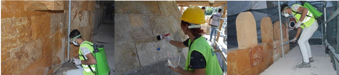
Fotoğraf 4.58. Taş sağlamlaştırıcısı ve su itici uygulamaları (VGM Rapor)
