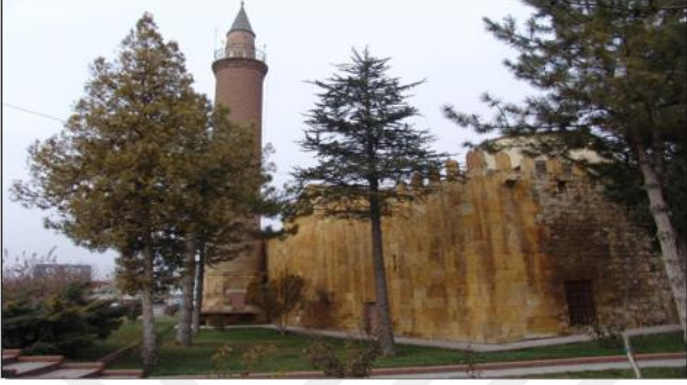
Fotoğraf 2.19. Cacabey Medresesi güney cephesi (VGM Rapor)
