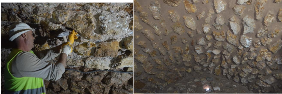
Fotoğraf 4.19. Menfez kapağı uygulaması (VGM Rapor)
