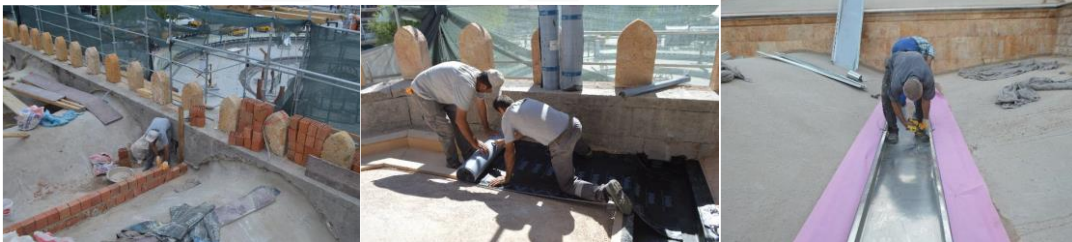
Fotoğraf 4.38. Dere ve çinko kaplama uygulaması (VGM Rapor)
