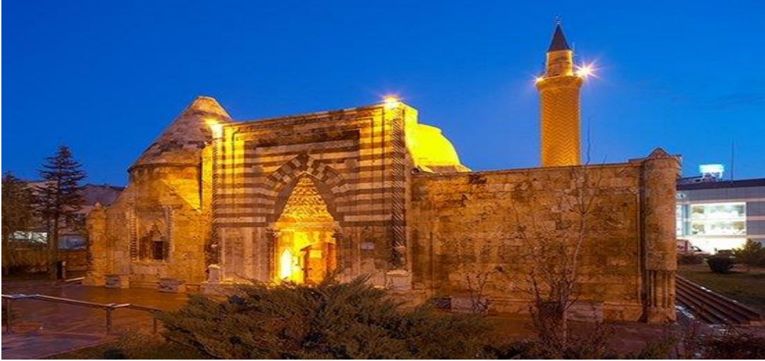
Fotoğraf 2.1. Cacabey Medresesi Kuzey cephe (VGM Rapor)
