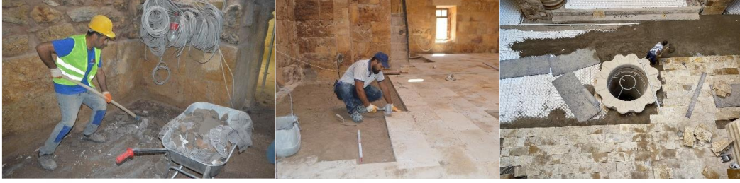
Fotoğraf 4.27. Traverten yonu taş kaplaması (VGM Rapor)
