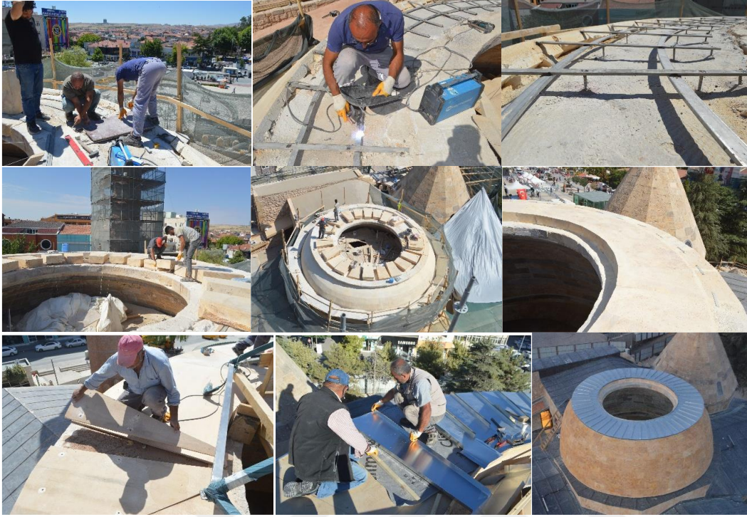
Fotoğraf 4.41. Kubbe üstü titanyum çinko kaplama (VGM Rapor)
