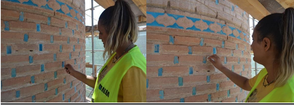
Fotoğraf 4.10. Çini kuşak temizleme uygulaması (VGM Rapor)
