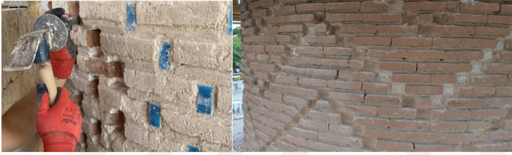
Fotoğraf 4.82. Dolgu temizleme işlemi (VGM Rapor)
