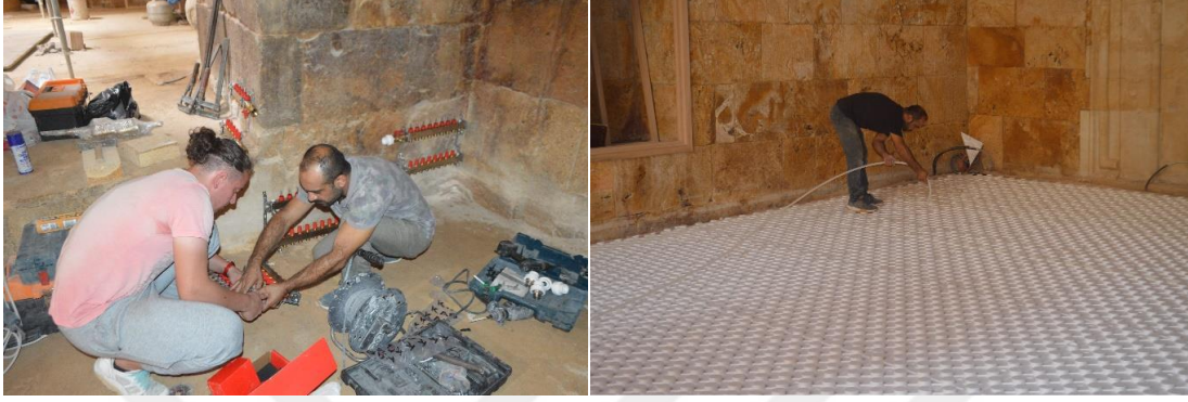
Fotoğraf 4.103. Yerden ısıtma sistemi uygulaması (VGM Rapor)
