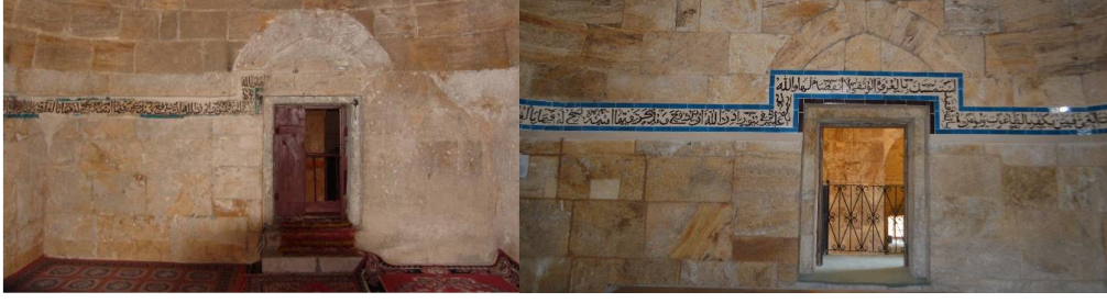
Fotoğraf 4.81. Etil slikat uygulaması (VGM Rapor)
