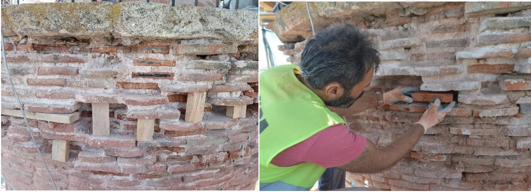
Fotoğraf 4.11. Mevcut tuğlaların eskitme ve onarılma çalışması (VGM Rapor)
