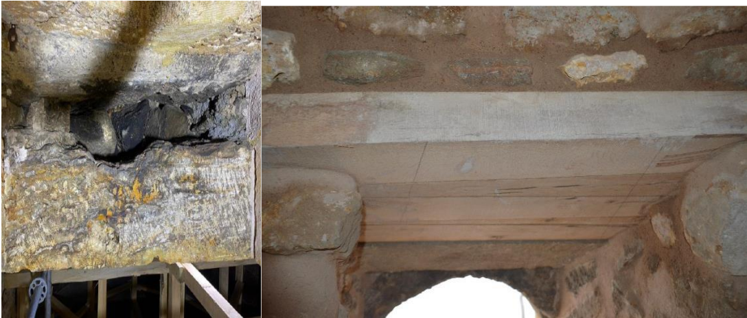
Fotoğraf 4.94. Lento yuvaları ahşap ekleme uygulaması (VGM Rapor)
