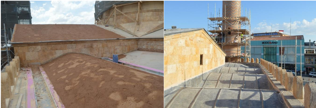
Fotoğraf 4.39. Kurşun kaplama uygulaması (VGM Rapor)
