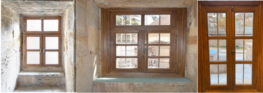
Fotoğraf 4.88. Pencere restorasyon uygulaması (VGM Rapor)
