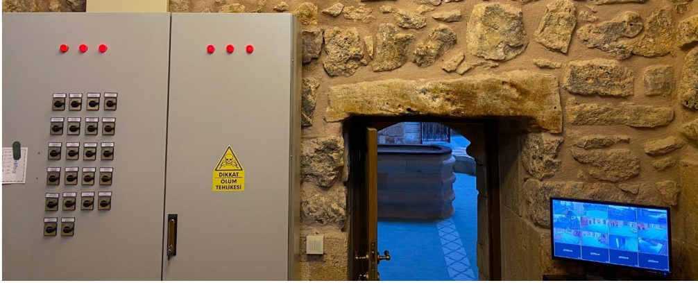
Fotoğraf 4.98. Elektrik tesisatı uygulaması (VGM Rapor)
