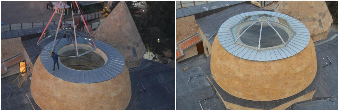
Fotoğraf 4.42. Kubbe delikli cam uygulaması (VGM Rapor)
