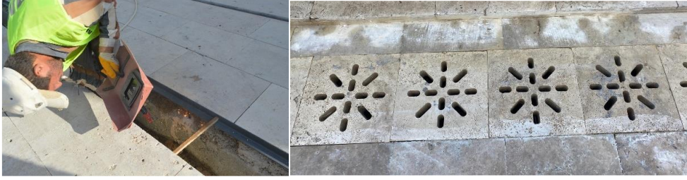
Fotoğraf 4.4. Yağmur suyunun Medreseye ulaşmasını engellemek için döşenen taş ızgaralar (VGM Rapor)
