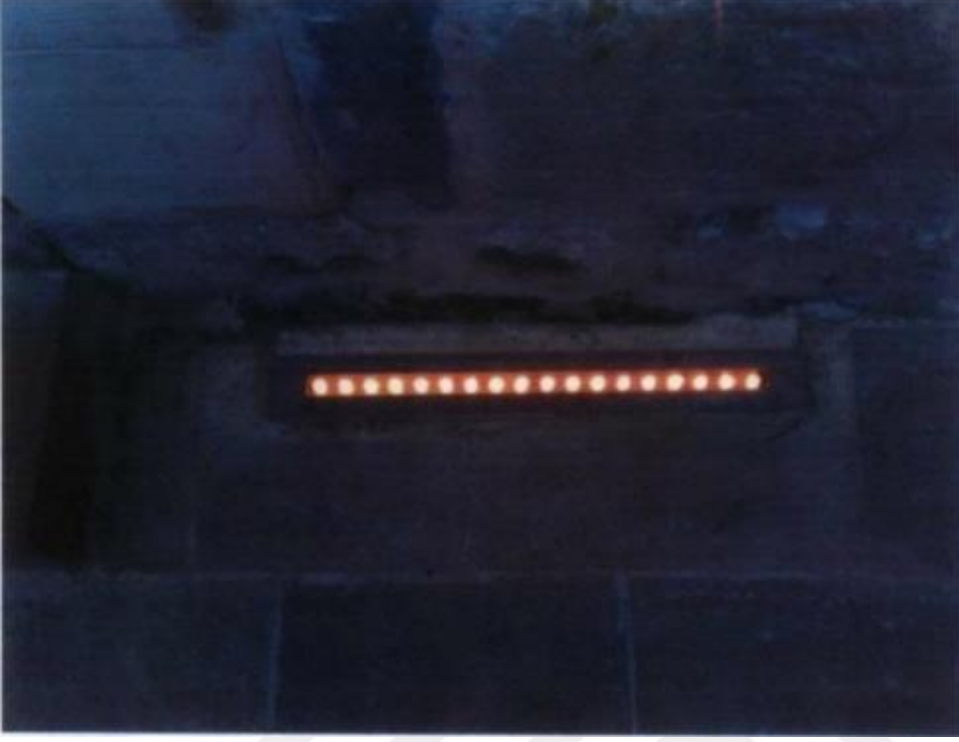
Fotoğraf 3.23. Led Armatür (18'li) (VGM Rapor)
