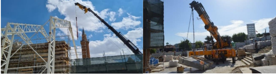
Fotoğraf 4.1. Temel ayaklarının vinç yardımıyla kaldırılması (VGM Rapor)
