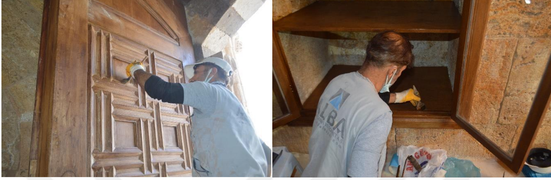
Fotoğraf 4.95. Ahşap cilalama uygulaması (VGM Rapor)
