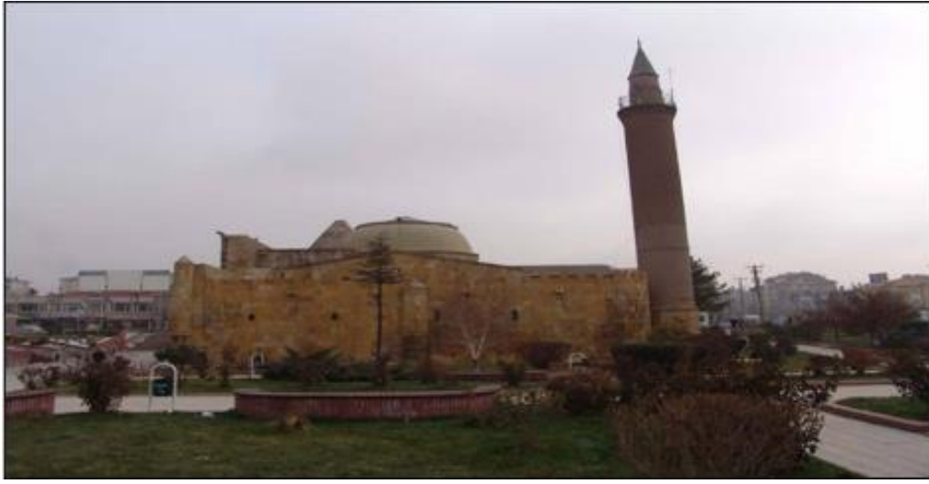
Fotoğraf 2.18. Cacabey Medresesi Batı cephesi (VGM Rapor)
