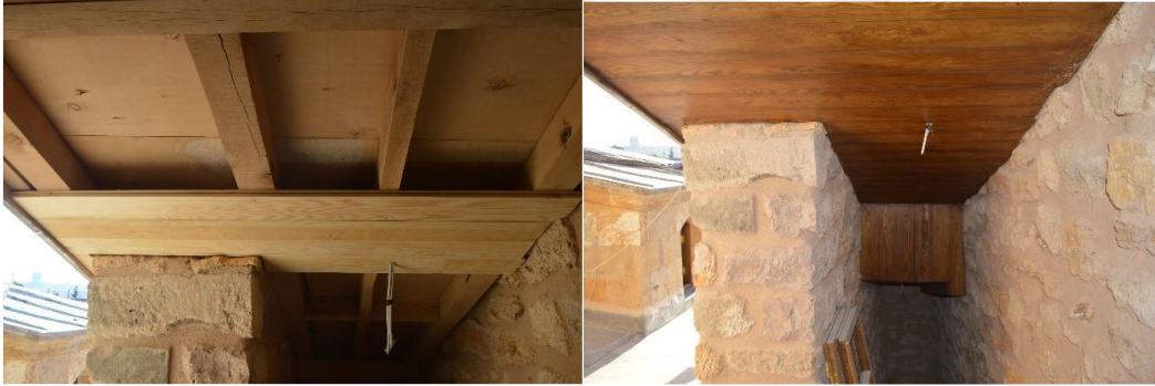
Fotoğraf 4.93. Çatı koridoru tavanı ahşap ekleme uygulaması (VGM Rapor)
