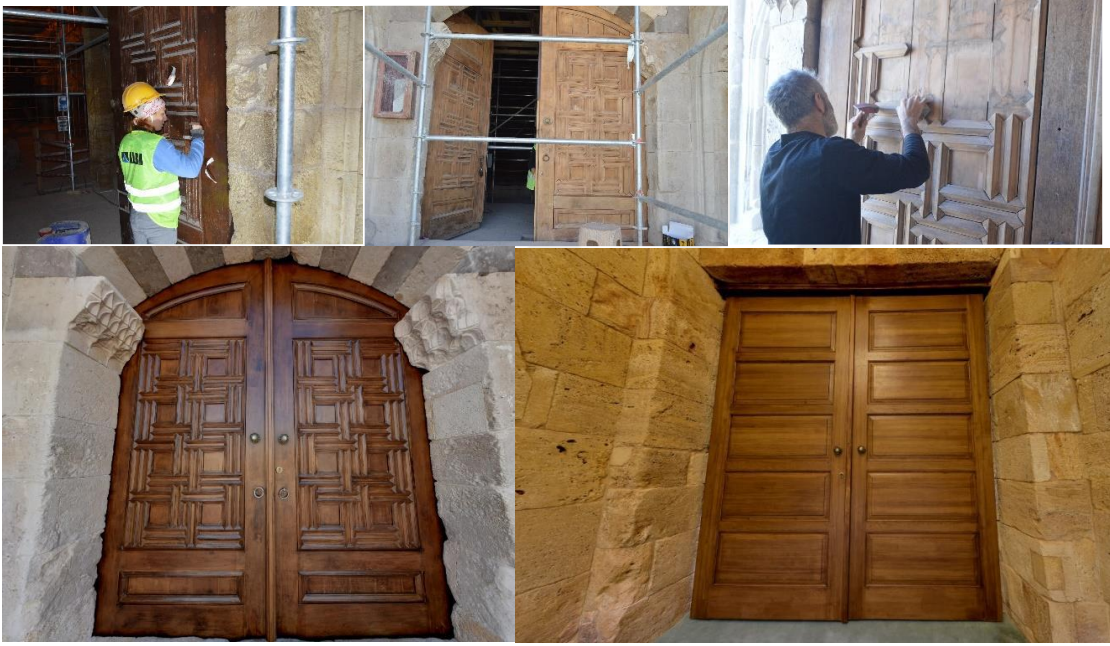
Fotoğraf 4.86. Ana giriş kapısı restorasyon uygulamaları (VGM Rapor)
