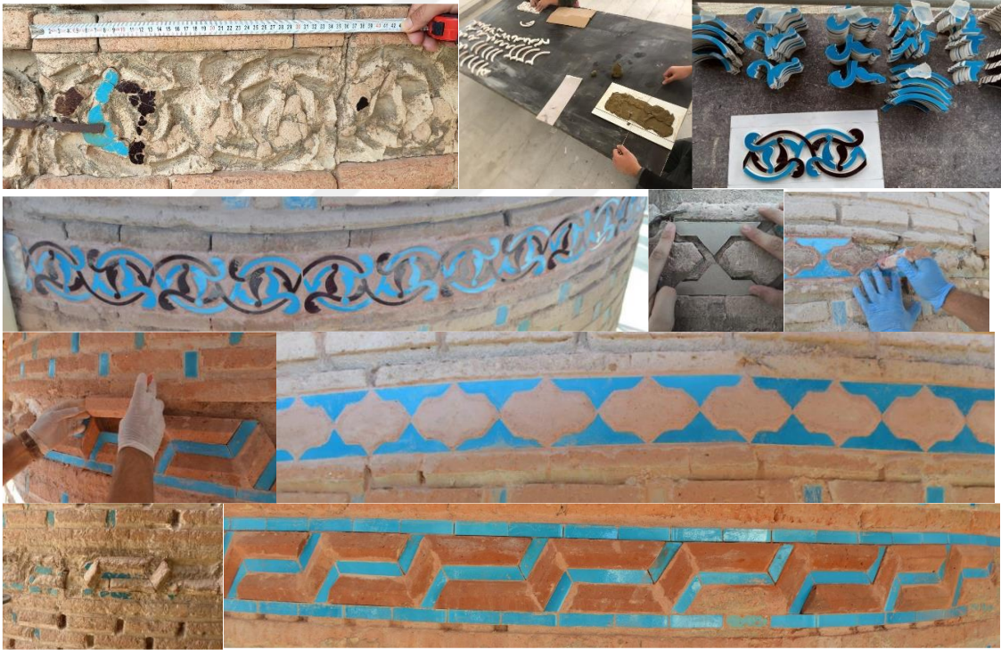
Fotoğraf 4.85. Çini modül üretimi ve uygulaması (VGM Rapor)
