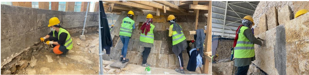
Fotoğraf 4.50. Beşik çatı duvarı temizleme/raspalama uygulaması (VGM Rapor)
