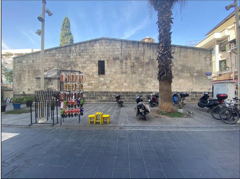
Şekil 4.1.2.1.8: Ömeriye Cami güney cephesi görünümü (2023)
