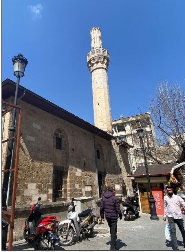
Şekil 4.1.2.10.7: Alaybey Cami minaresi (2023)
