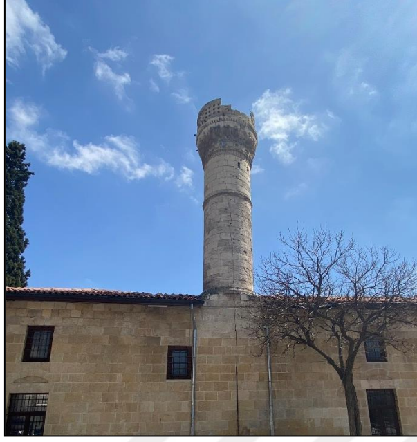
Şekil 4.1.2.20.10: Kozanlı Cami minaresi (2023)
