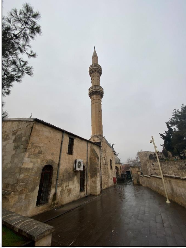
Şekil 4.1.2.11.7: Şirvani Cami doğu cephesi görünümü (Ocak, 2023)
