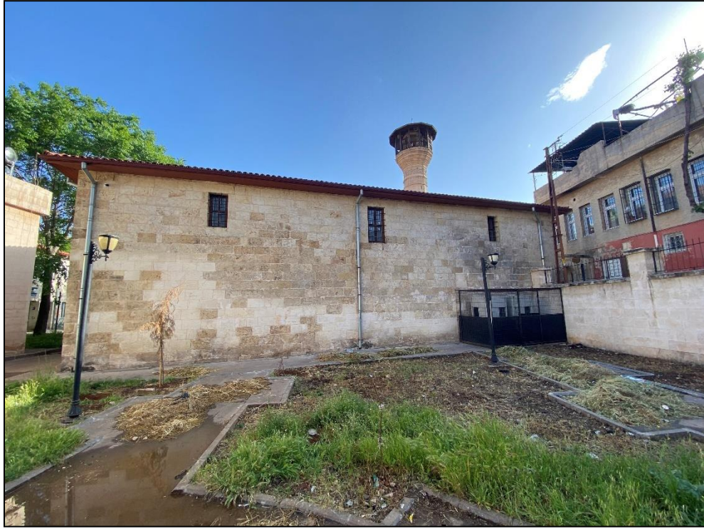
Şekil 4.1.2.7.7: Şeyh Ömer Cami güney cephesi (2023)
