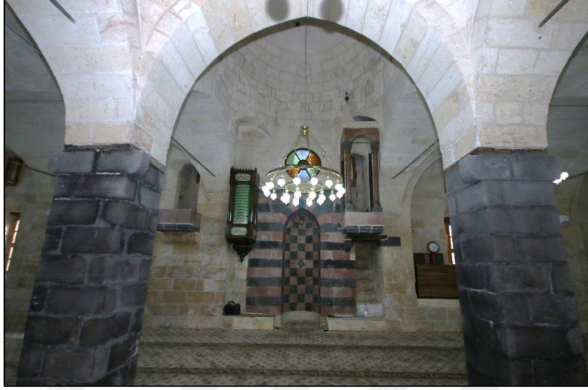
Şekil 4.1.2.15.5: Karatarla Cami mihrap cephesi görünümü (Altın, 2015)
