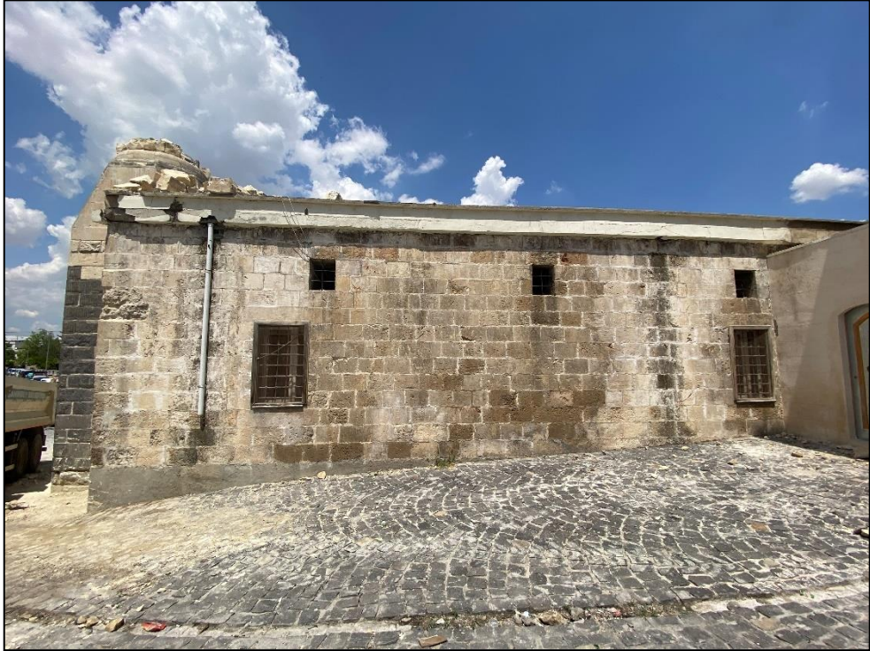
Şekil 4.1.2.13. 6: Tabak Halil Cami güney cephesi (2023)
