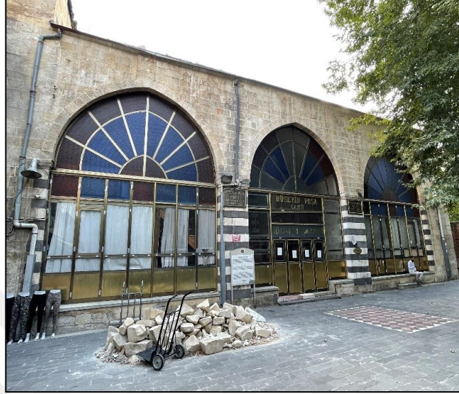
Şekil 4.1.2.25. 3: Hüseyin Paşa Cami minaresi ve kuzey cephesi görünüşü (2023)
