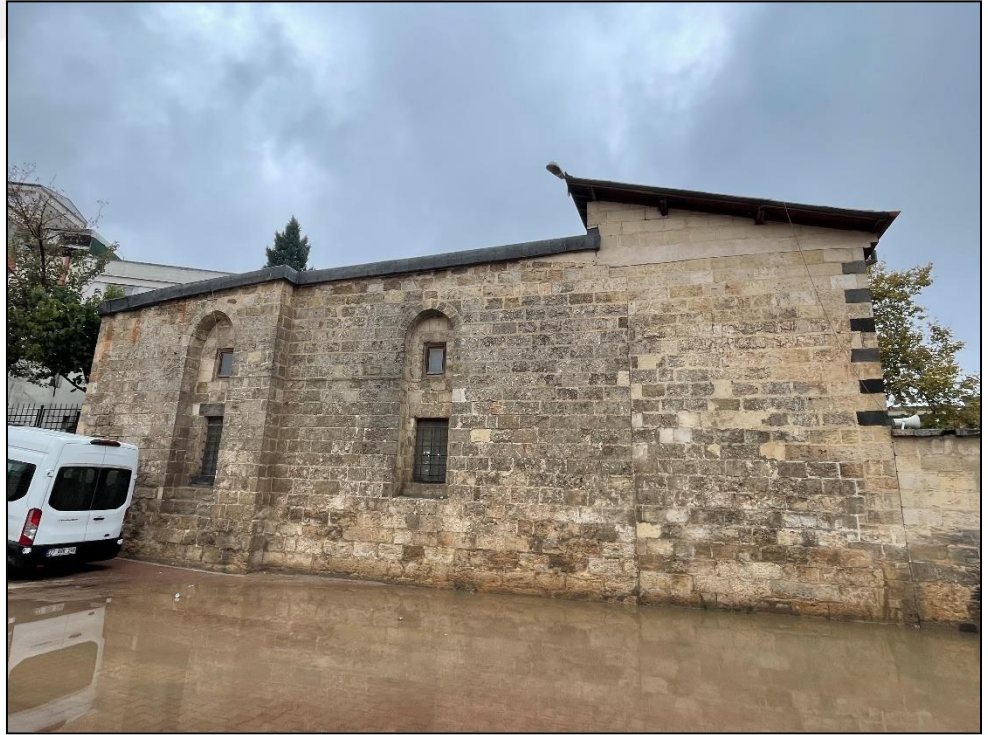
Şekil 4.1.2.6.8: Ağa Cami doğu cephesi (2023)
