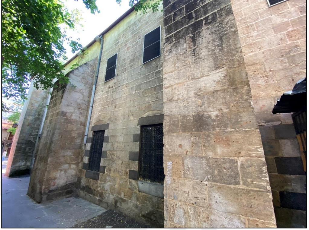
Şekil 4.1.2.25.7: Hüseyin Paşa Cami batı cephesi (2023)
