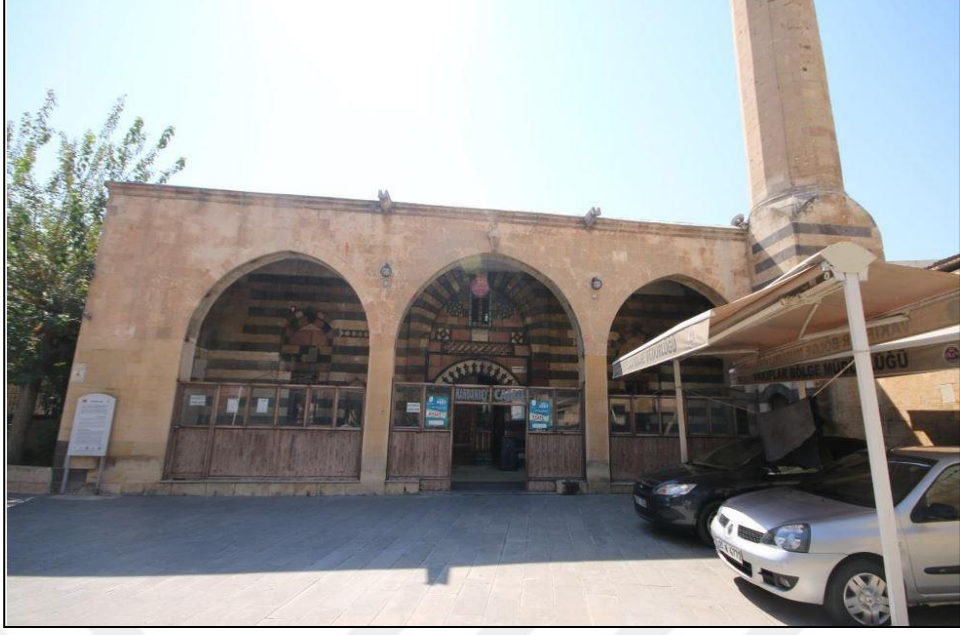
Şekil 4.1.2.16.5: Handan Bey Cami kuzey cephesinin görünümü (Altın, 2015)
