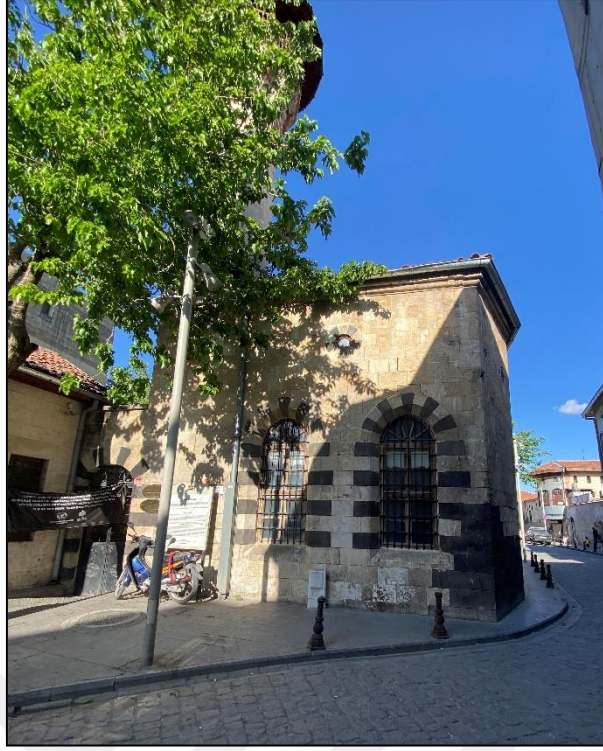
Şekil 4.1.2.12.6: Kozluca Cami batı cephesi (2023)
