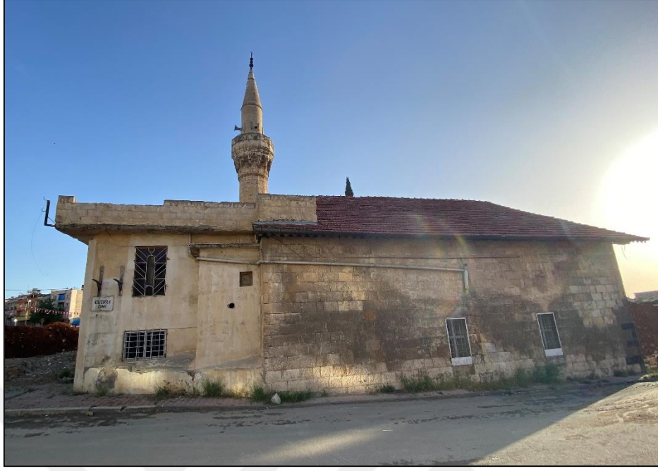
Şekil 4.1.2.22.9: Kılınçoğlu Cami güney cephesi (2023)
