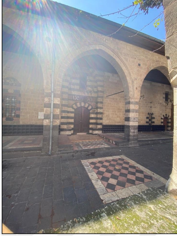
Şekil 4.1.2.10.2: Alaybey Cami avlu zemin döşemesi (2023)
