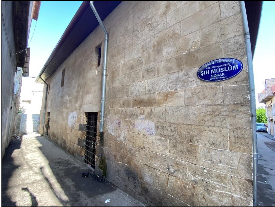
Şekil 4.1.2.14.8: Bostancı Cami güney cephesi görünüşü (2023)
