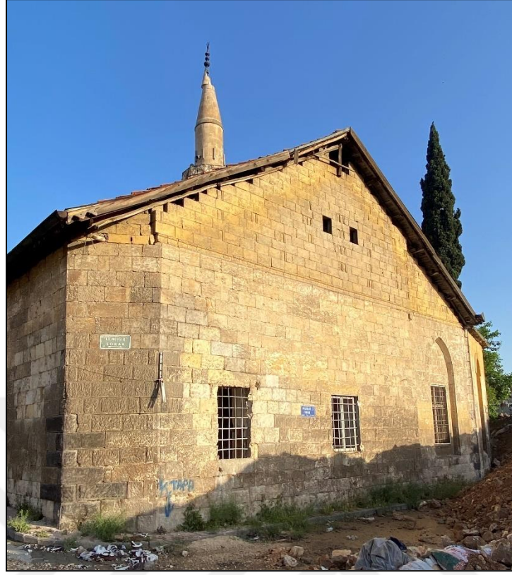
Şekil 4.1.2.22.7: Kılınçoğlu Cami doğu cephesi (2023)
