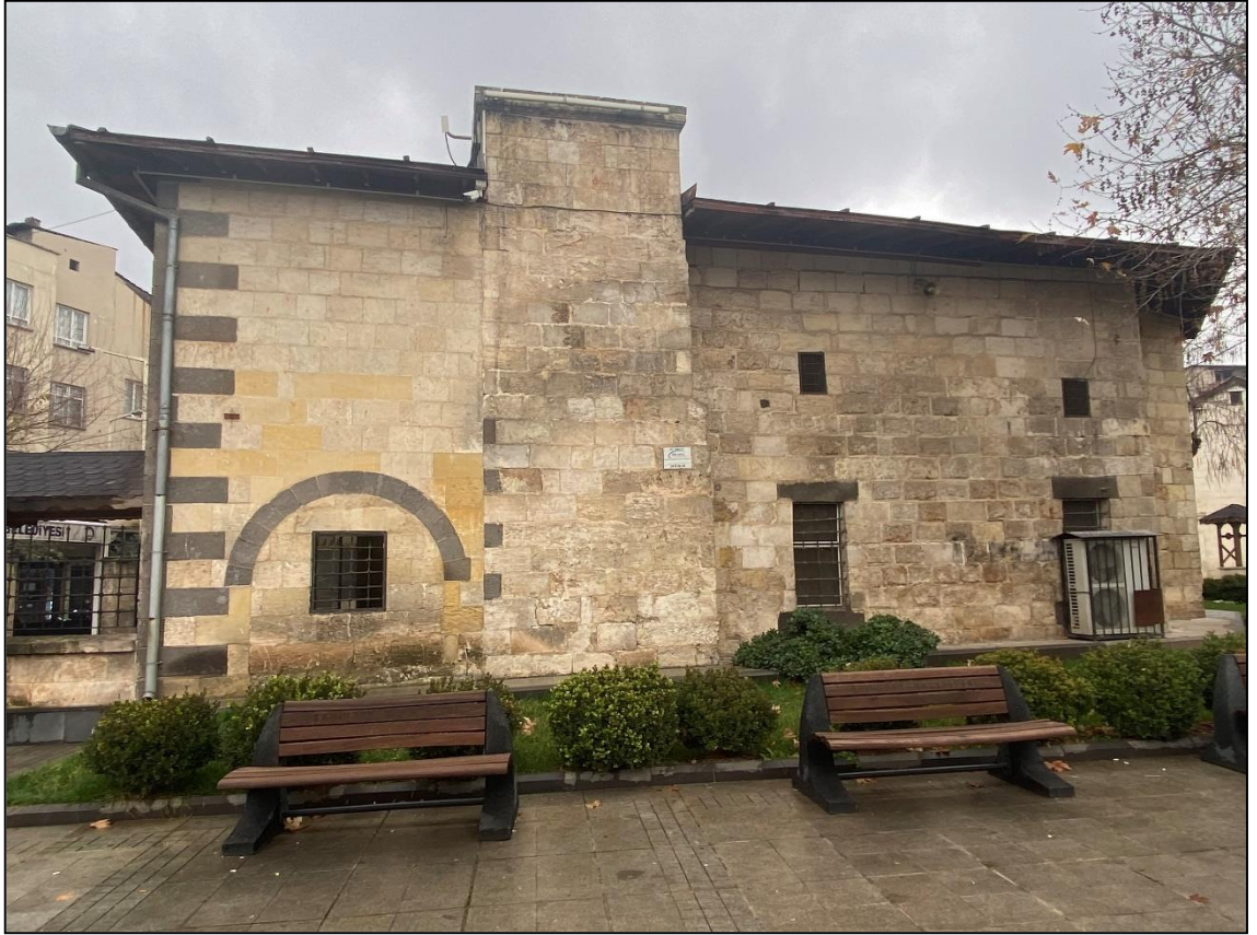
Şekil 4.1.2.24.7: İhsan Bey Cami batı cephe (2023)
