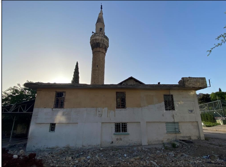
Şekil 4.1.2.22.8: Kılınçoğlu Cami batı cephesi (2023)
