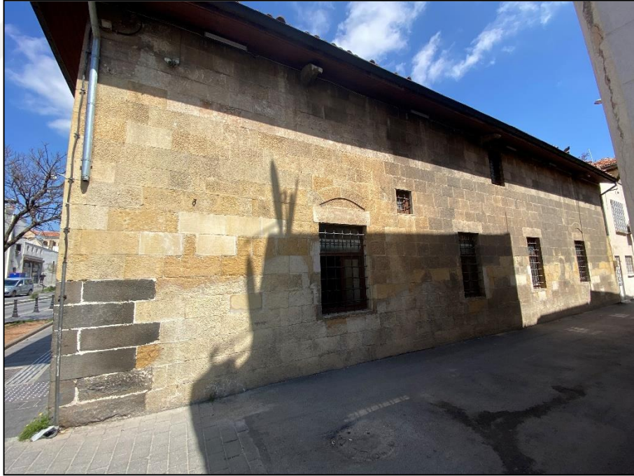
Şekil 4.1.2.20.9: Kozanlı Cami güney cephesi (2023)
