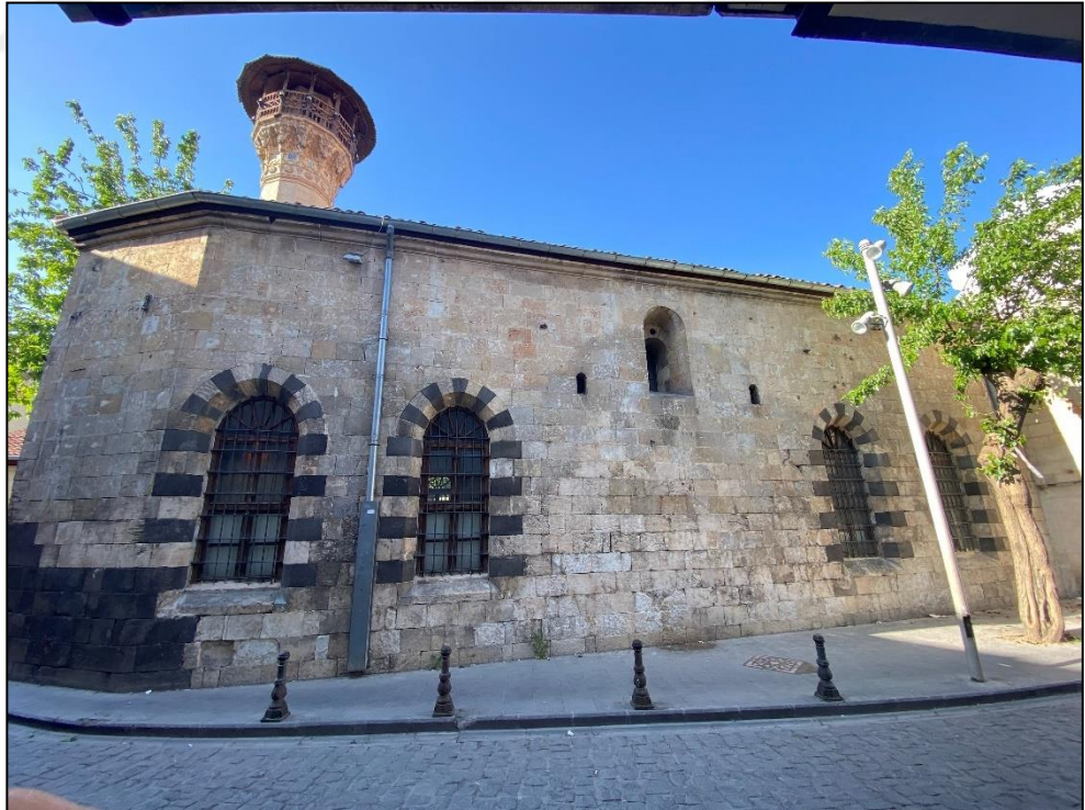
Şekil 4.1.2.12.7: Kozluca Cami güney cephesi (2023)
