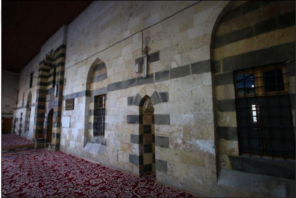
Şekil 4.1.2.21.6: Hacı Nasır Cami kuzey cephesi (Altın, 2015)
