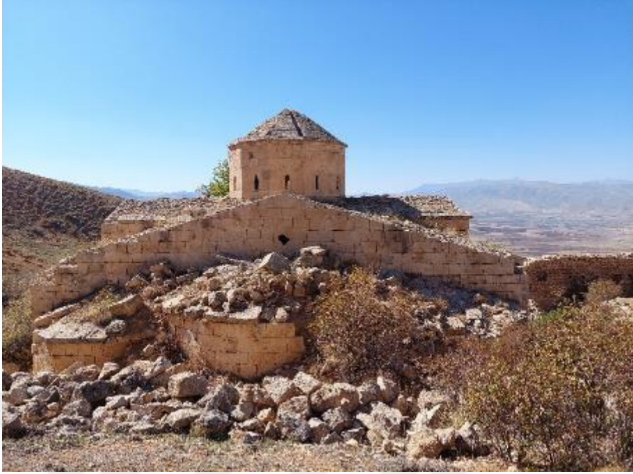
Şekil C. 37:Kilise doğu cephesi
