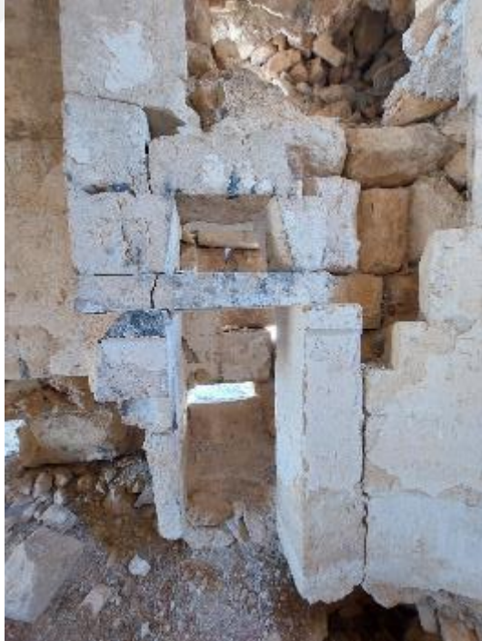
Şekil C.58:Apsisten kuzeydoğu odaya girişi sağlayan kapı açıklığı
