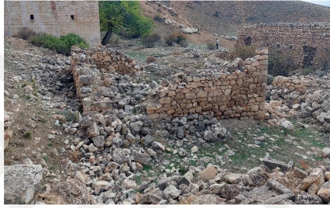
Şekil 4.9: Şapkalama (capping) önerisi verilen manastır ek yapı duvarlarından örnek
