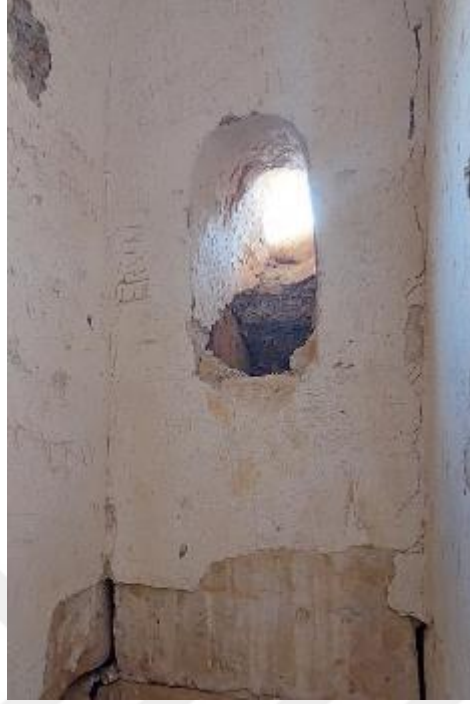
Şekil C. 59:Kuzeydoğu oda kemerli pencere açıklığı
