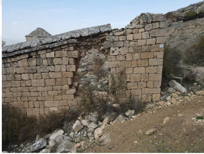
Şekil 4.3: Manastır güney avlu duvarında bütünleme önerisi verilen yer
