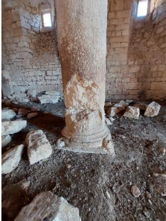
Şekil C. 90:Sütunda gözlemlenen kesit kaybı
