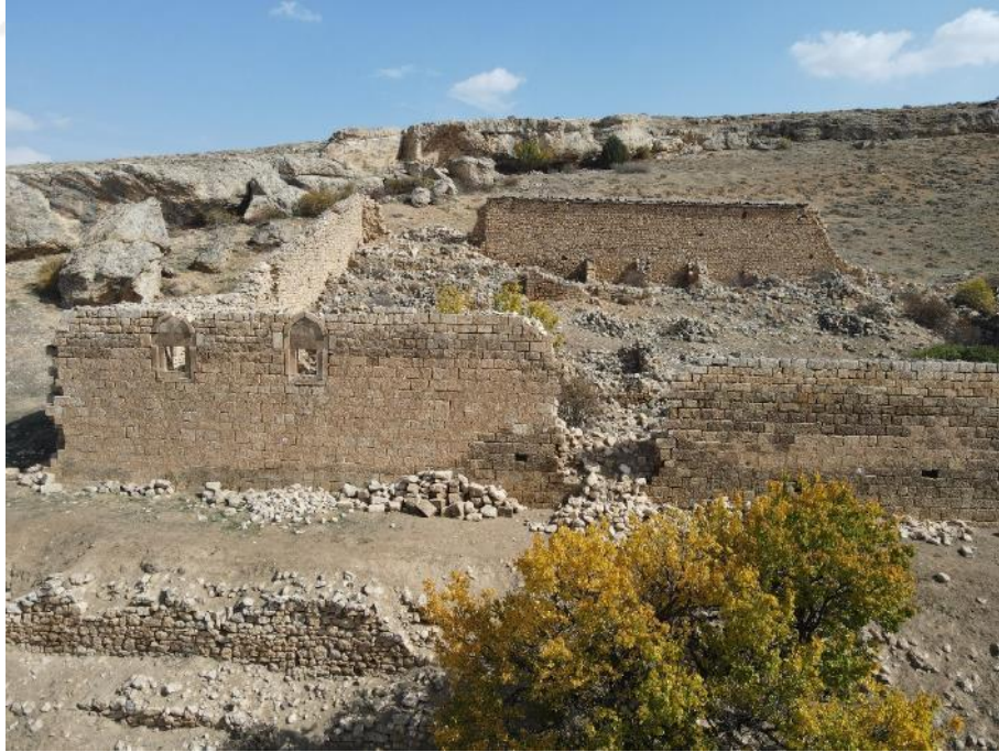
Şekil C. 4:Manastır avlu duvarları arasında kot farkı
