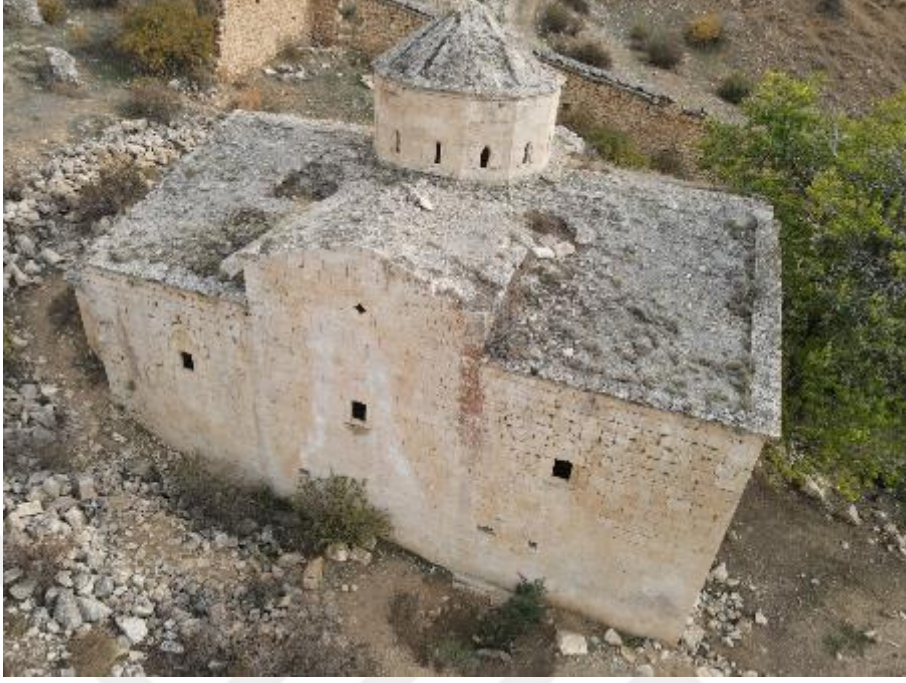
Şekil C. 89:Kilise çatısı mevcut durum
