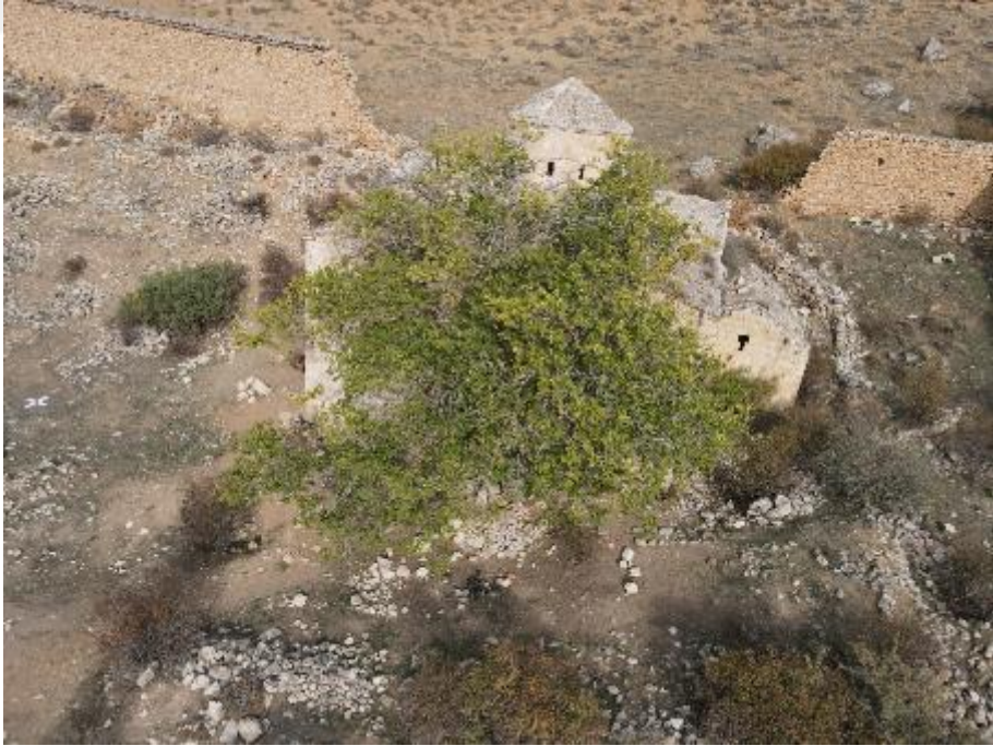
Şekil C. 36:Kilise batı cephesini kaplayan ağaç
