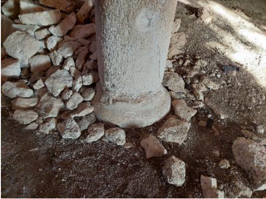
Şekil C. 46:Sütun kaide detayı-1
