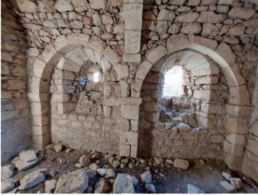
Şekil C. 25:Martyrion güney duvarında yer alan pencere açıklıkları
