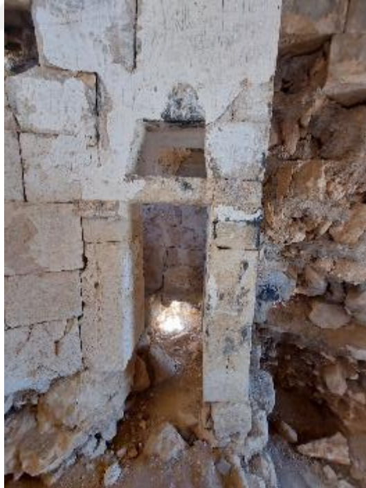
Şekil C. 60:Apsisten güneydoğu odaya girişi sağlayan kapı açıklığı
