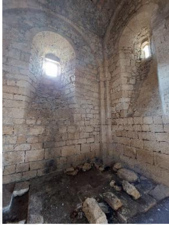
Şekil C. 39:Kilise naousun güneybatı köşesinde yer alan plaster
