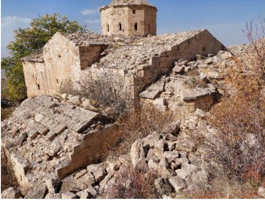
Şekil C. 101:Kilise ve martyron çatılarında gözlemlenen bitki oluşumları
