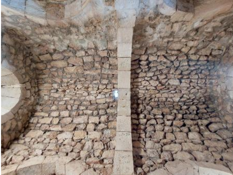
Şekil C. 24:Martyrion tonozu ve destek kemeri
