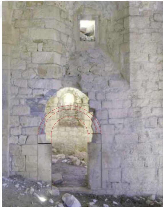
Şekil 3. 3: Kiliseden martyriona geçiş sağlayan kapı için restitüsyon önerisi
