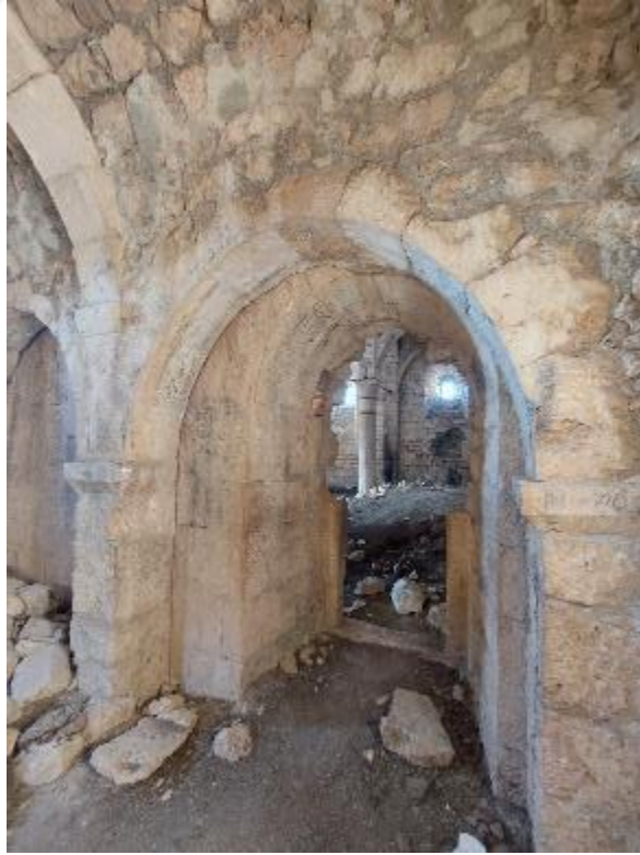
Şekil C. 28:Martyriona giriş kapısı ile kilise beden duvarı birleşimi
