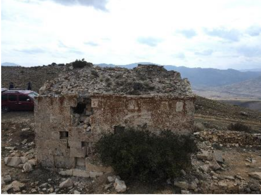
Şekil C. 63:Şapel kuzey cephesi
