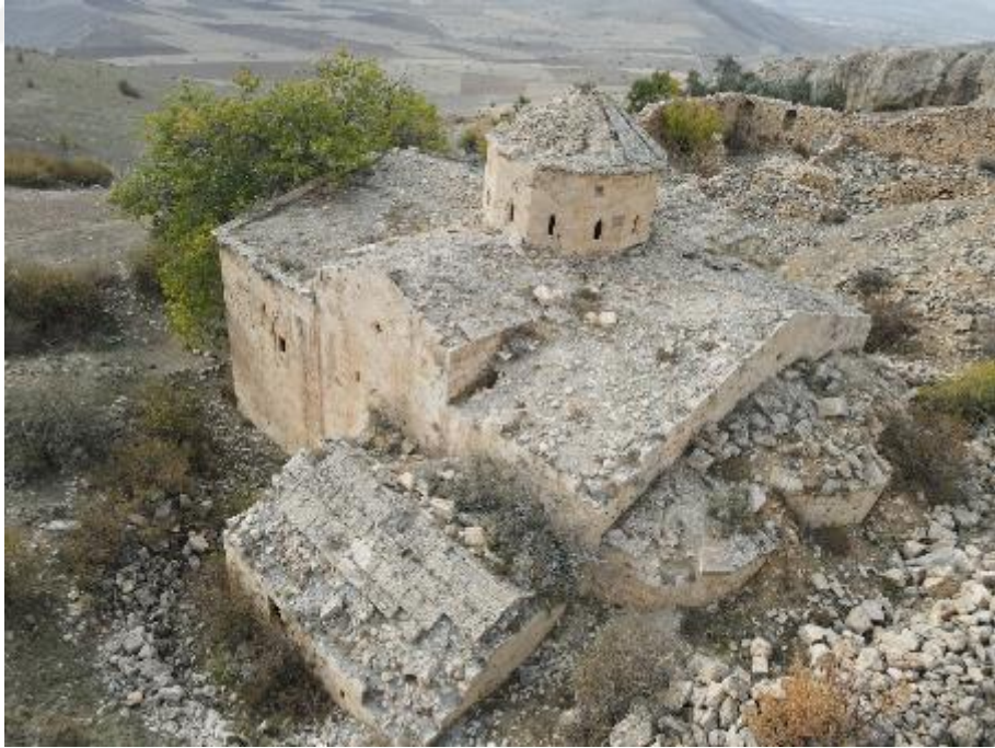
Şekil C. 30:Kubbe kasnağı ve üst örtü güneydoğudan görünüm
