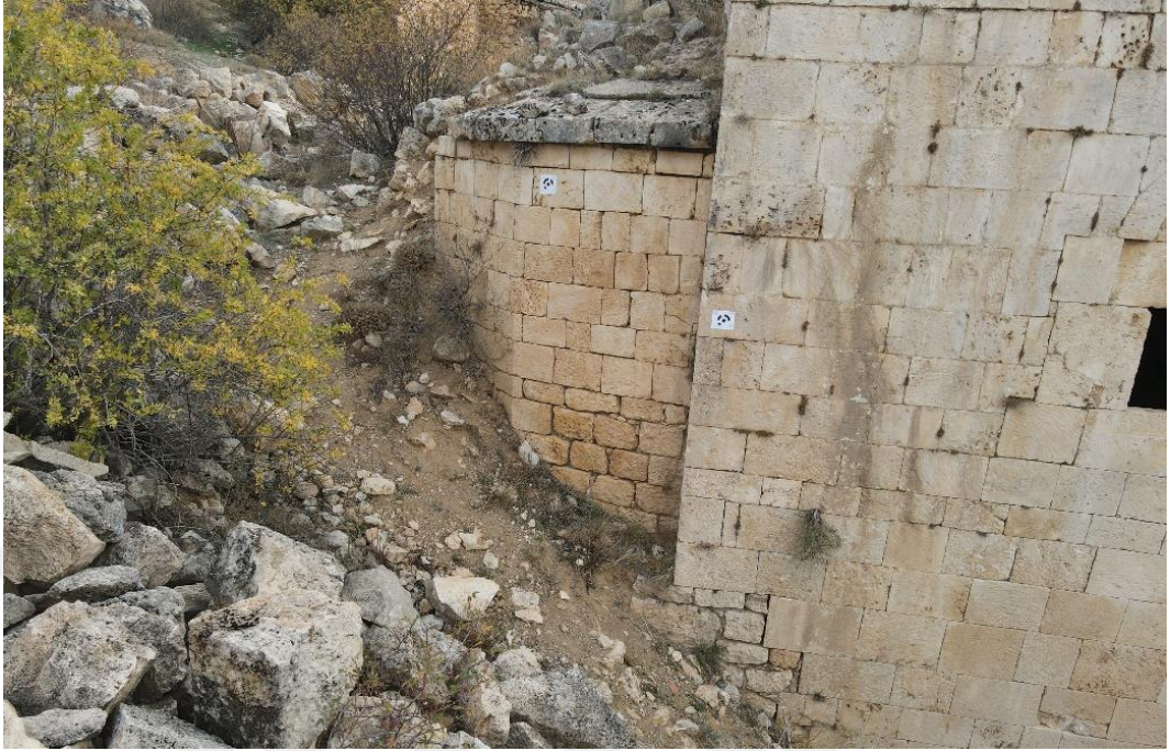
Şekil 2. 8:Manastır kilisesi kuzey cephesine yerleştirilen kontrol noktaları
