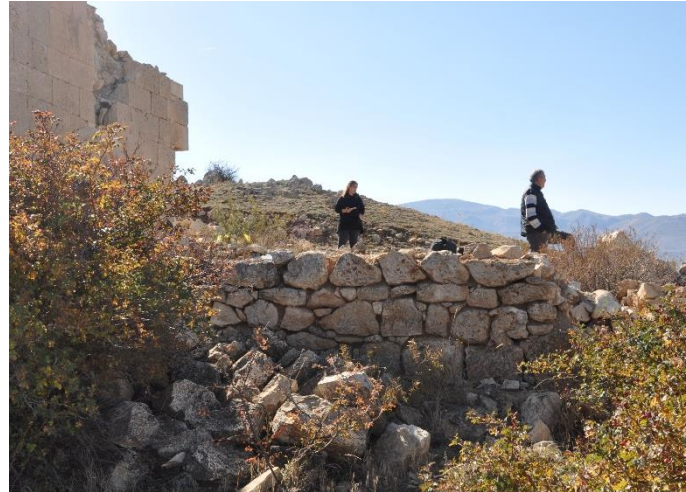
Şekil 4. 10: Şapkalama uygulaması önerilen şapel avlusunun kuzey duvarı
