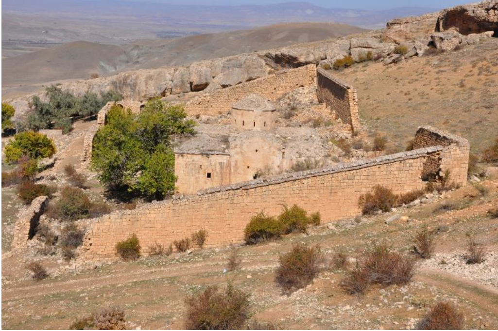
Şekil C. 2:Manastır alt yerleşke avlu duvarları
