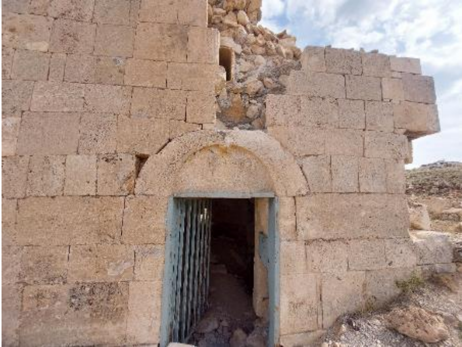
Şekil C. 72:Şapel batı cephesi örgü motif detayları
