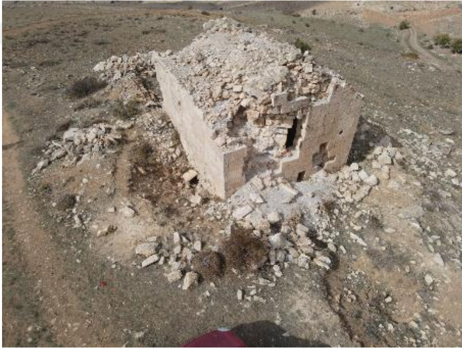
Şekil C. 94:Şapel üst örtüde meydana gelen kesit kayıpları
