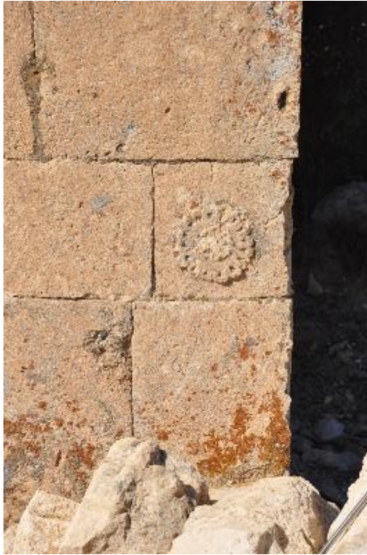
Şekil C. 70:Şapel doğu cephesinde yer alan rozet
