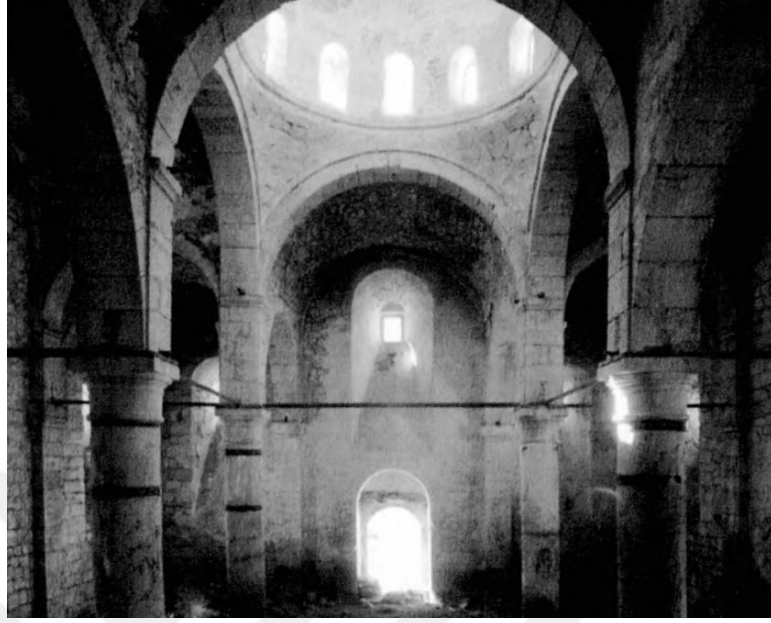
Şekil 3. 1:Kilise giriş kapısının bütün hâli, içten görünüm (Bruchhaus, 2010, s. 241)
