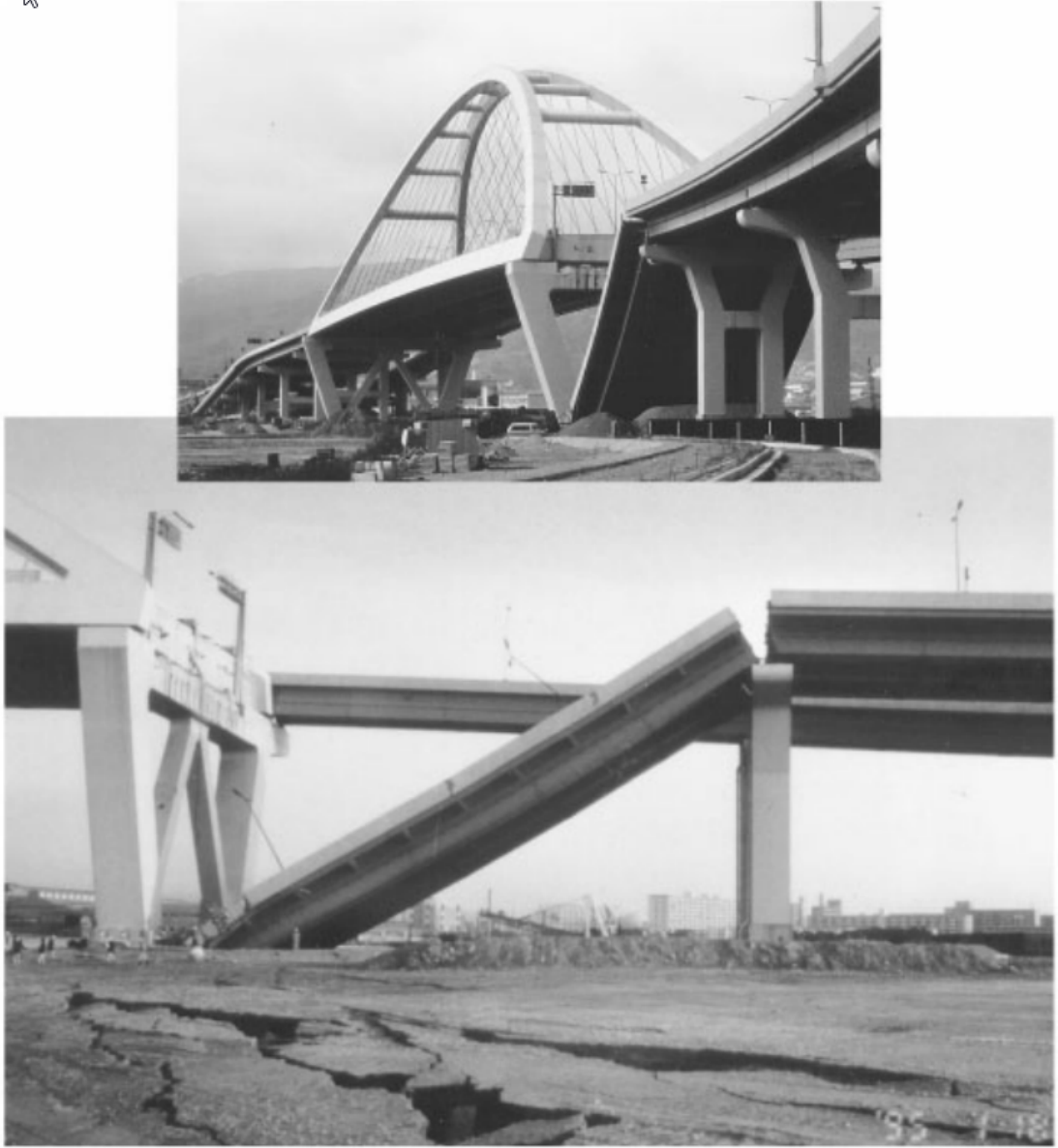
Şekil 1.5 1995 Hyogo-Ken Nanbu Depreminde Nishinomiya-ko Köprüsünün Yaklaşım Açıklığının Yanal Yayılma ve Sıvılaşma Nedeniyle Düşmesi (Faizan vd., 2021)
