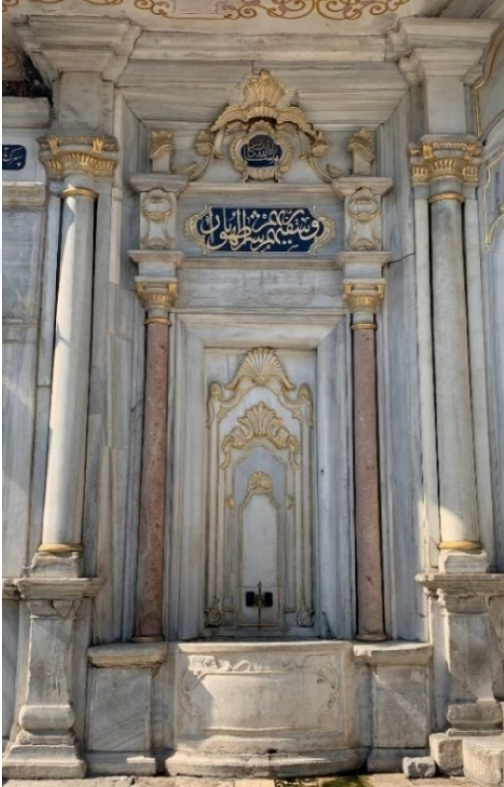
Resim 74: Mihrişah Valide Sultan Sebili'nin Sol Tarafındaki Çeşme
