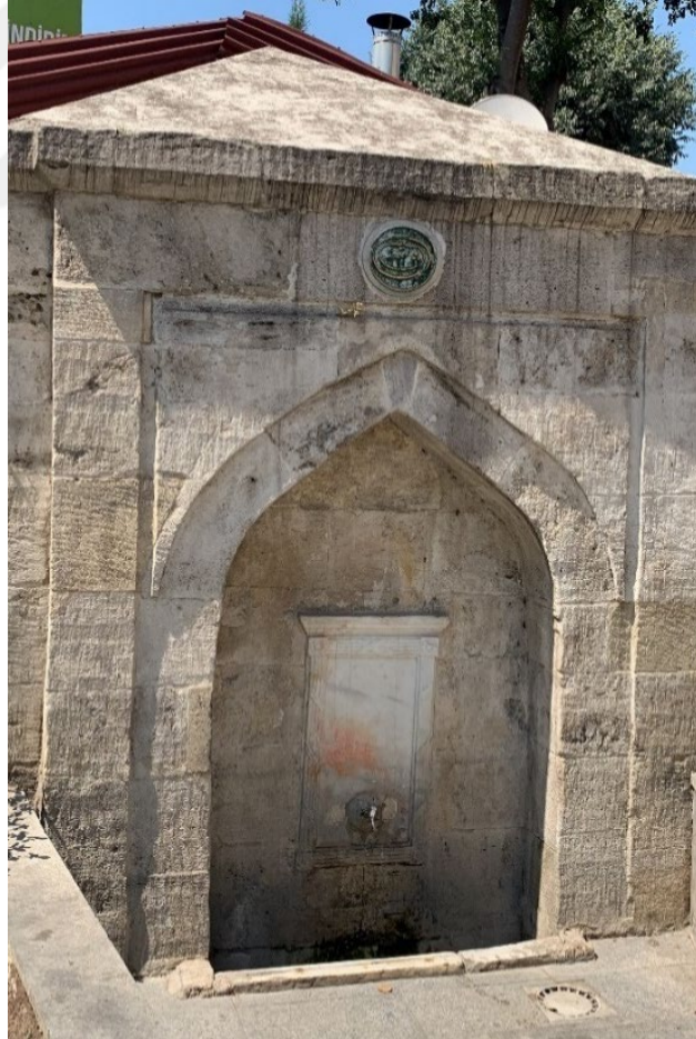
Resim 87: Kasım Çavuş Çeşmesi Uzaktan Görünümü
