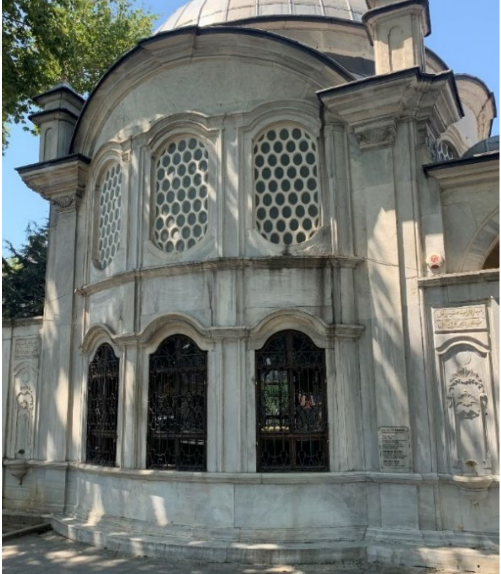
Resim 81: Şah Sultan Türbesi Çeşmeleri Genel Görüntüsü
