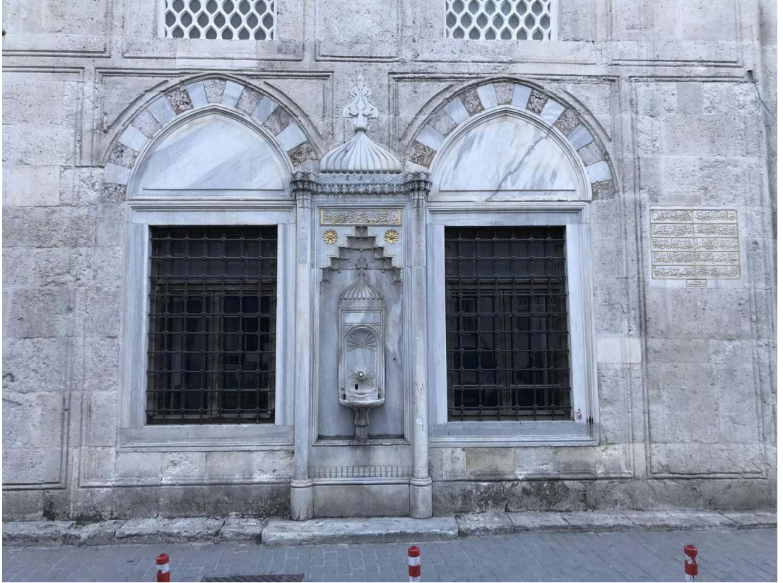
Resim 27: Nakkaş Hasan Paşa Çeşmesi ve Yanında Yer Alan Kitâbe
