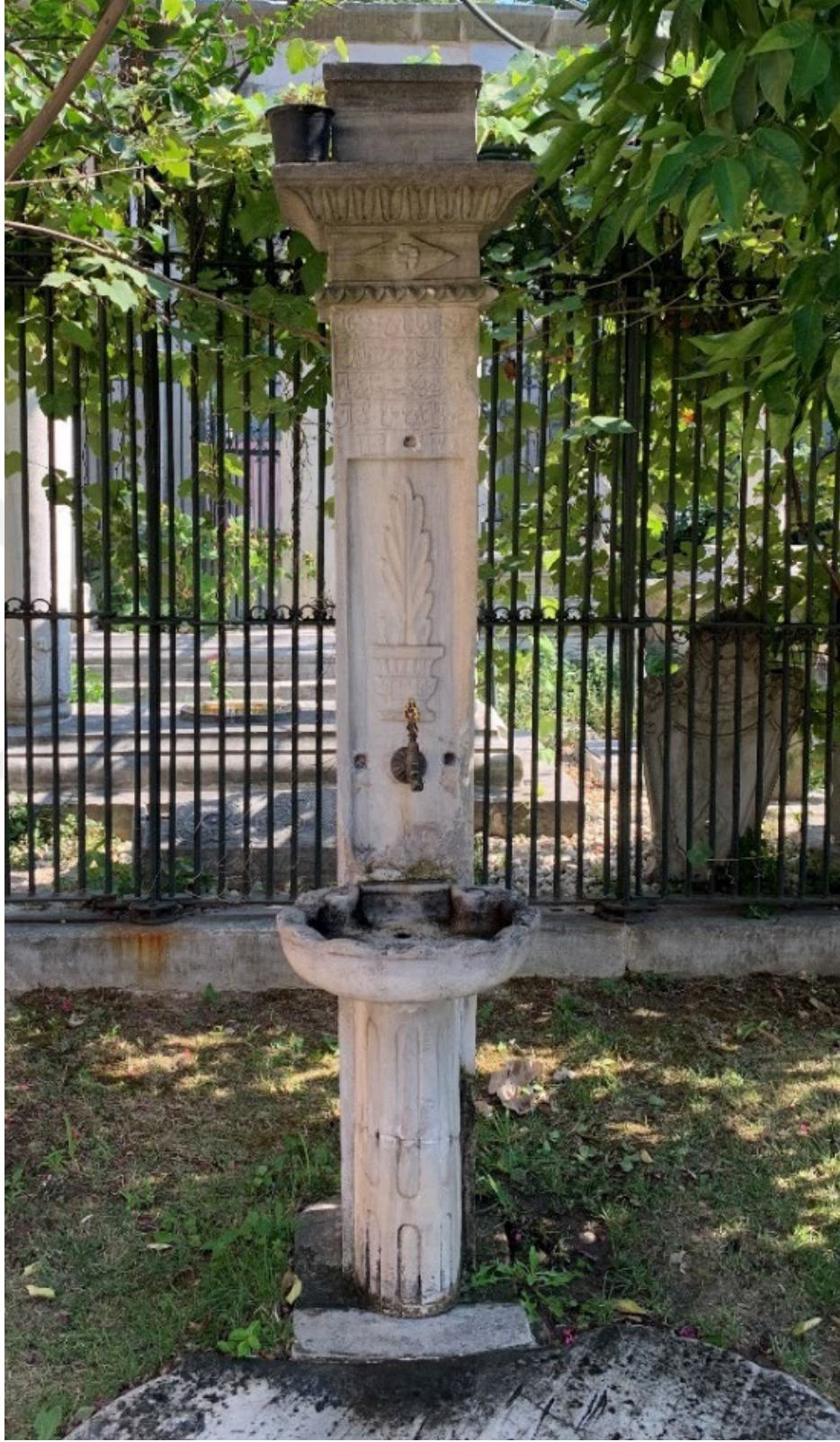
Resim 105: Hüsrev Paşa Çeşmesi Ön Cepheden Görünümü
