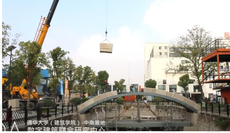
Şekil 3. 17 Baoshan Yaya Köprüsü'nün montajı (Yuan,2019)
