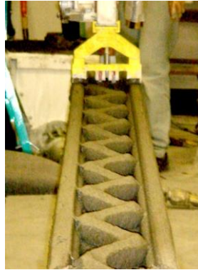
Şekil 2. 2 3B baskı teknolojisi ile üretilmiş ilk duvar (Mankin, 2008)
