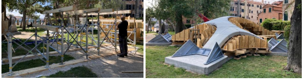
Şekil 4. 20 Çelik ve ahşap iskele (Dell’Endice vd., 2023)
