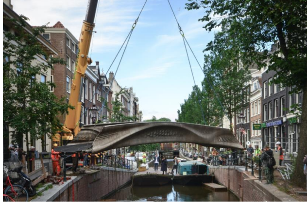
Şekil 3. 7 Paslanmaz çelikten üretilen MX3D köprüsü (MX3D, b.t.)
