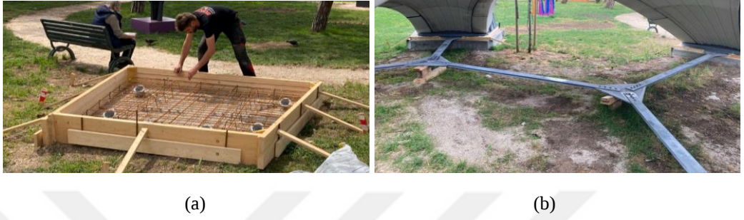
Şekil 4. 19 Betonarme kaide için hazırlanan kalıp (a) (Dell’Endice vd., 2023) germe elemanları (b) (Dell’Endice vd., 2023)
