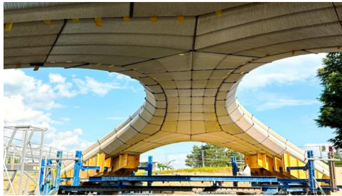
Şekil 4. 37 İskele yardımıyla donatısız ve harçsız bir araya getirilen 3BB beton bloklar (Holcim, b.t.a)
