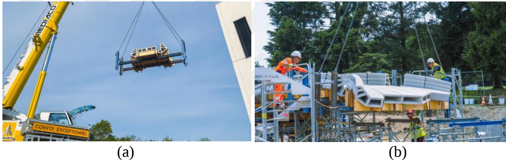
Şekil 4. 36 Phoenix Köprüsü bileşenlerinin şantiye alanına nakledilmesi (a) (Holcim, b.t.a) bileşenlerin yerinde montajı (b) (Holcim, b.t.a)
