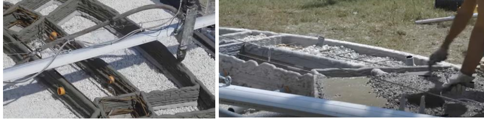
Şekil 4. 11 Gaia evi temel yapımı (3D WASP, 2018)
