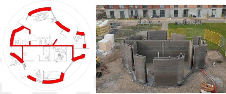
Şekil 4. 38 AKF Pavyonu 3BB duvarları (SAGA Space Architects, 2023)
