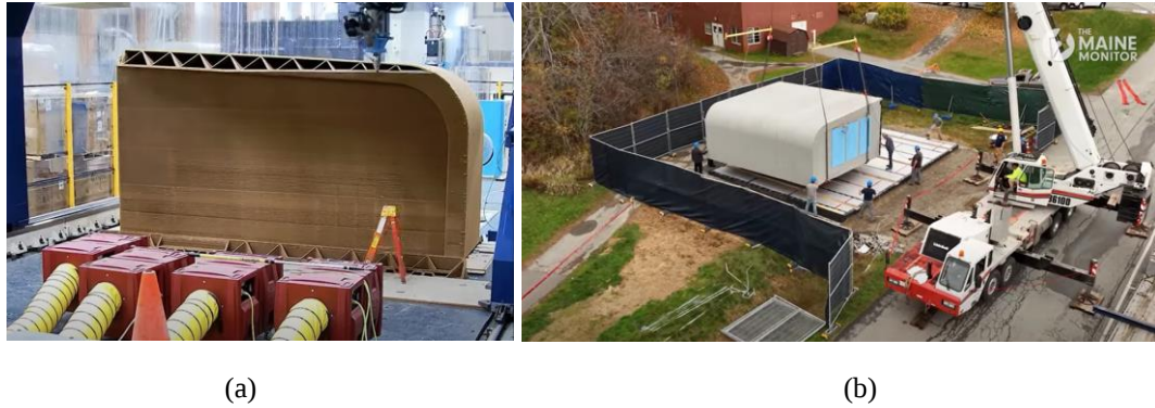
Şekil 4. 30 Fabrikada gerçekleştirilen baskı süreci (a) (Maine Monitor, 2023) basılan modüllerin yerinde monte edilmesi (b) (Maine Monitor, 2023)
