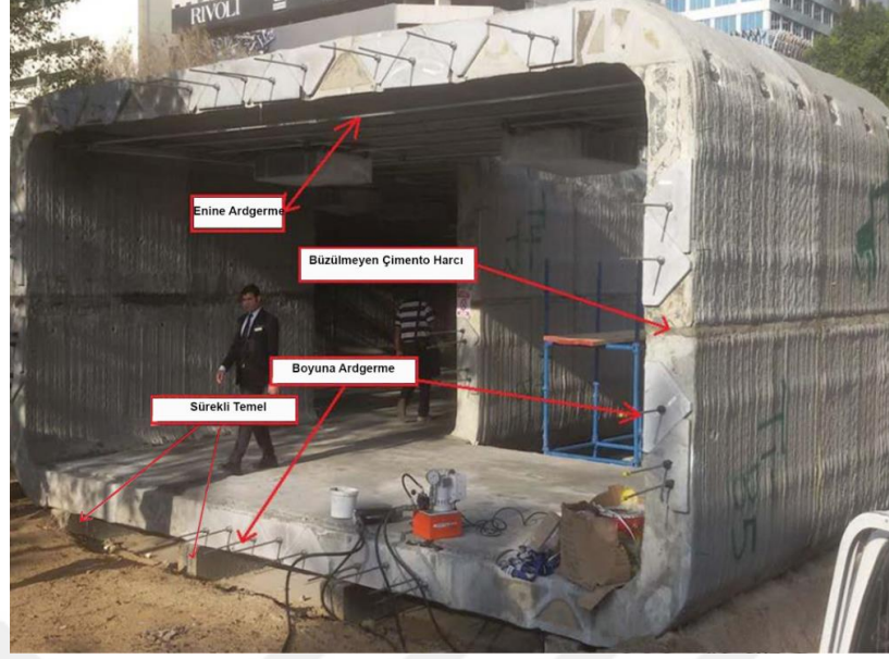
Şekil 4. 10 Dubai Ofis Binası'nın kaba inşaatı (Alawneh vd., 2018)
