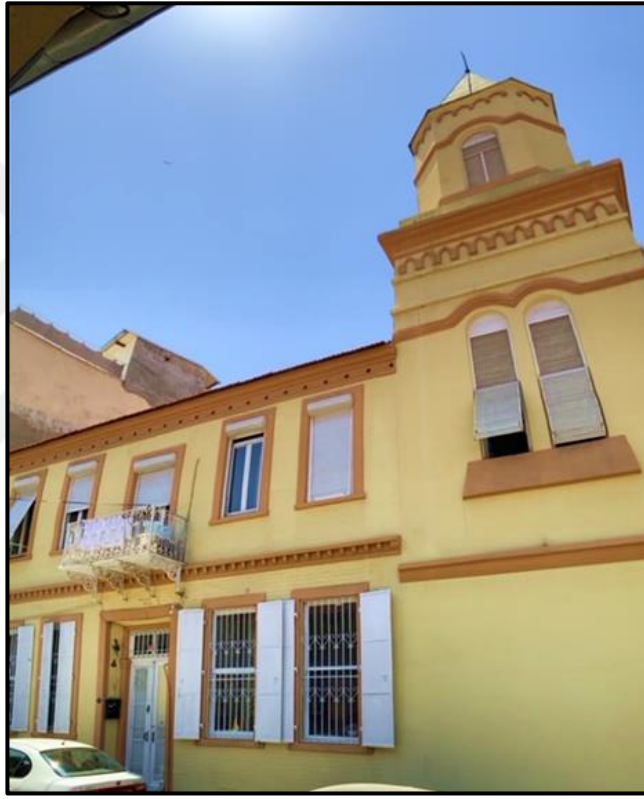
Fotoğraf 13 , Melis ÖRS Arşiv Fotoğrafı, Notre Dame Lourdes Katolik Kilisesi Ön Cephe Fotoğraf Çekimi, 2022, Konak
