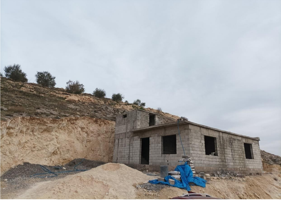
Şekil 3.47. Kavaklıca Mahallesiinde Çatısı Düz Dam Şeklindeki Mesken Örneği
