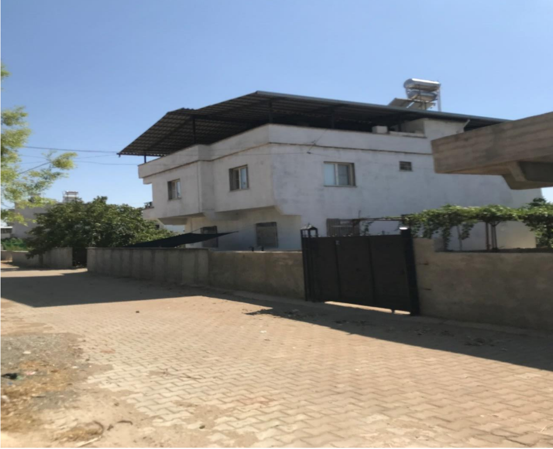
Şekil 3.49. Beyburcu Mahallesiinde Çatısı Sac Malzemededen Yapılmış Mesken Örneği
