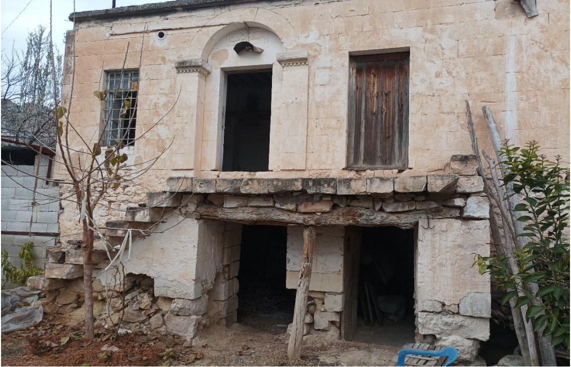
Şekil 3.34. Fıstıközü Mahallesiindeki Geleneksel Halfeti Meskeni
