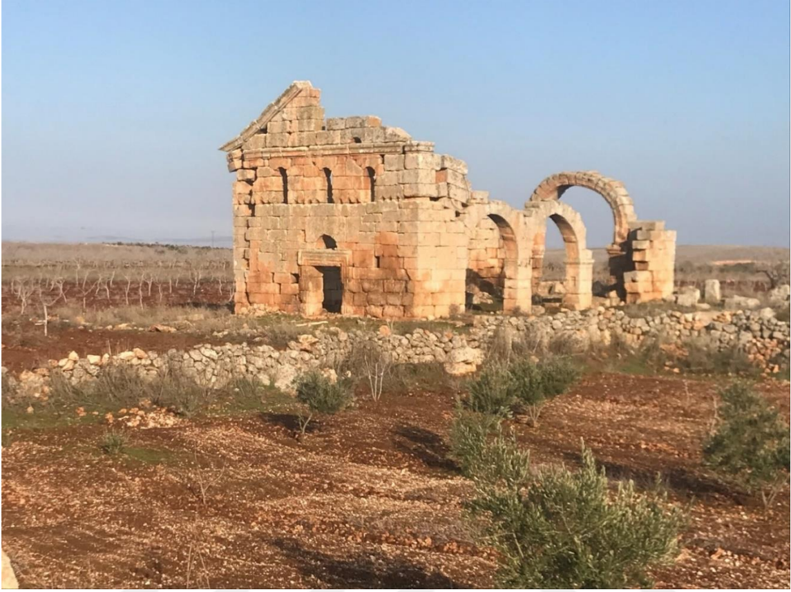
Şekil 4. 6. Gürkuyu Mahallesiinde Yer Alan Kilise
