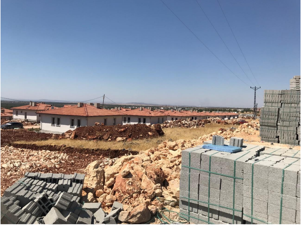
Şekil 3.50. Argıl Mahallesiinde Yapım Aşamasındaki 208 Adet Deprem Konutu
