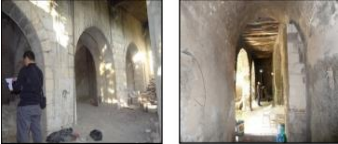
Şekil 3.30. Geleneksel Konak Tarzındaki Halfeti Meskenlerinde Revak Örneği
