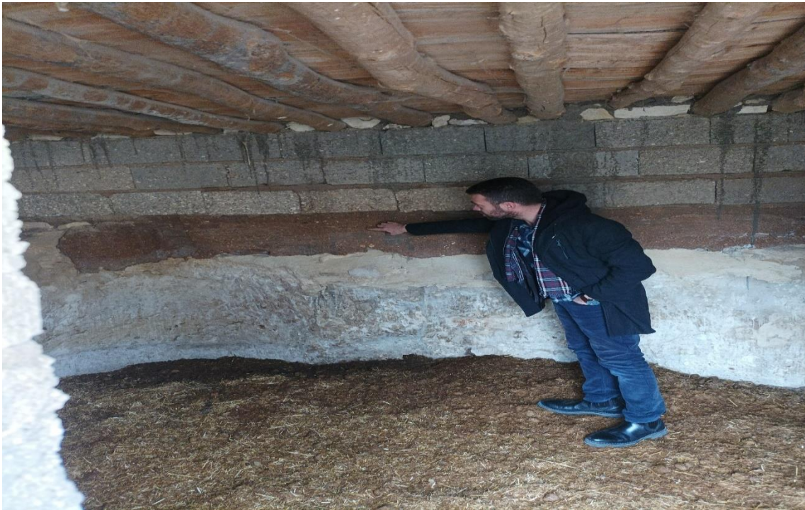
Şekil 3.37. Bulaklı Mahallesiinde Kaya Zemin Üzerine Yapılan Mesken ve Alt Katındaki Ahır
