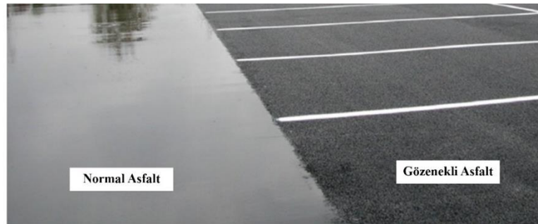
Şekil 2. 19 Bir yağış olayı sırasında normal asfalt ile gözenekli asfalt yüzey arasındaki sızma performanslarının farkı. Kaynak: Mullaney, J. ve Lucke, T. (2014). Practical Review of Pervious Pavement Designs. Clean–Soil, Air, Water , 42 (2), 111–124. https://doi.org/10.1002/clen.201300118 .
