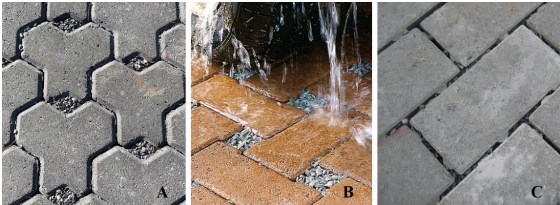
Şekil 2. 21 A) Çevresinde yarıklar olan geçirimli kaldırım taşı. Kaynak: URL10. (2023, 22 Ağustos). Permeable Pavers . Resilient East. https://www.resilienteast.com/permeable-pavers . B) Çevresinde yarıklar olan geçirimli kaldırım taşı. Kaynak: RI Lampus. (2022, 9 Ağustos). Permeable Pavers . R. I. Lampus Company. https://www.lampus.com/Blog-Item-
