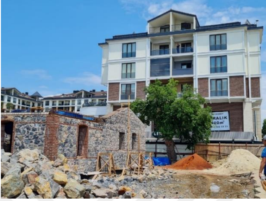
Şekil 5.24 Şehir ve Mübadele Müzesi İnşaatı (2022)
