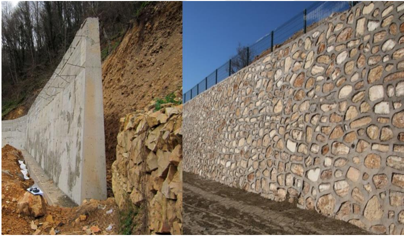
Şekil 2.19. Konsol ve ağırlık istinat duvarı (Polat, 2019)
