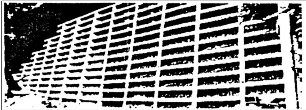
Şekil 2.21. Sandık duvar kesiti (Bromhead, 1986)
