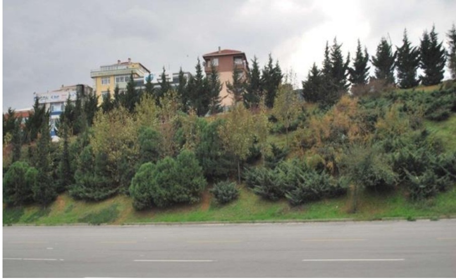
Şekil 2.18. Karayolu kenarında bulunan şevde yapılmış bitkilendirme çalışması (Polat, 2019)
