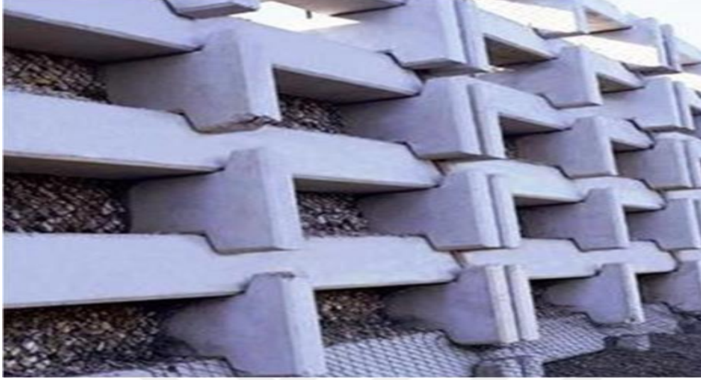
Şekil 2.20. Dalgulu çerçeve duvarı (Polat, 2019)
