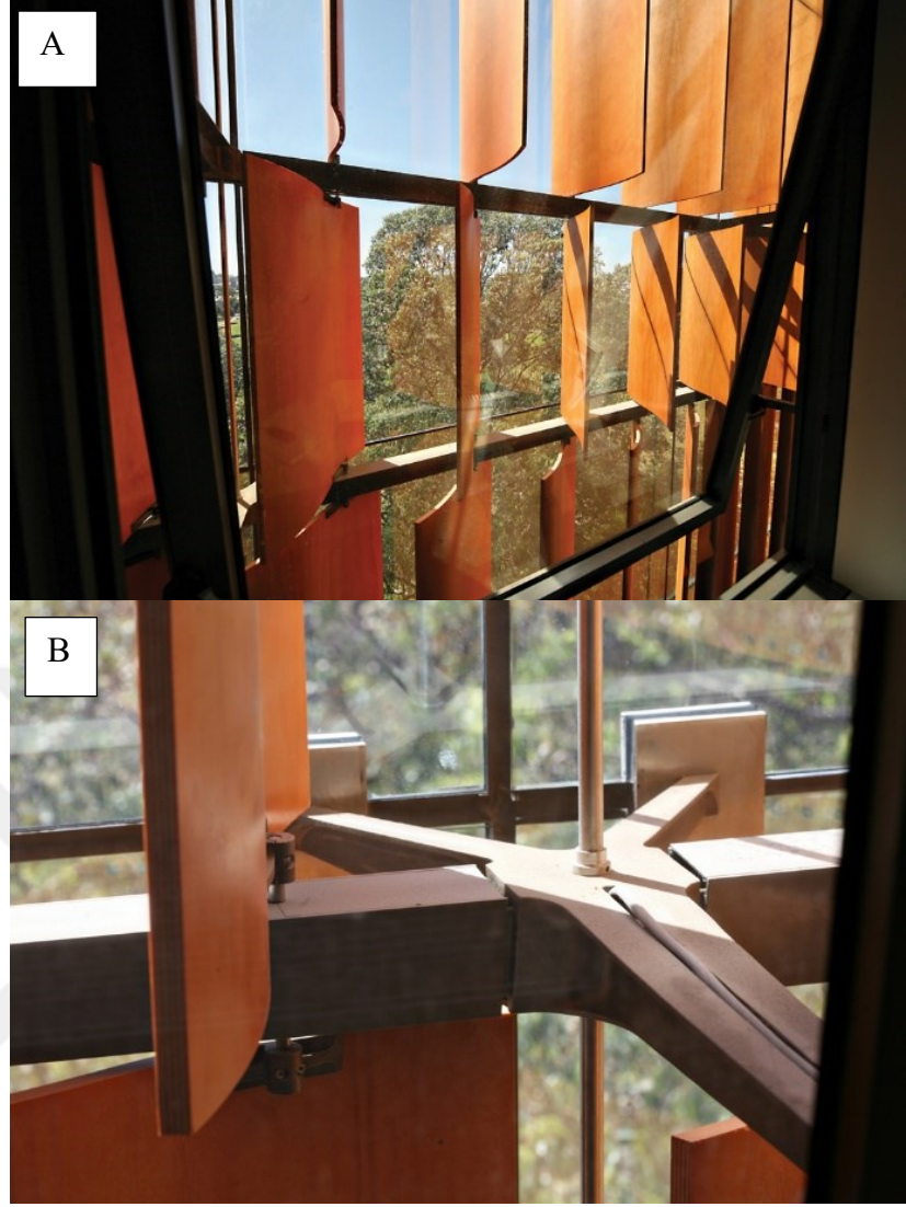
Şekil 3.37: Kinetik elemanın görseli(A) ve birleşim detayı(B) (Url-33, 2024).
