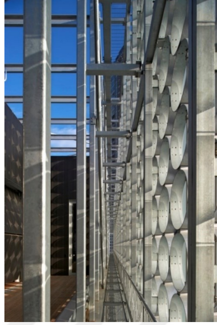
Şekil 3.16: Panellerin bir araya gelişi ve cephe ile birleşim detayı (Url-26, 2022).
