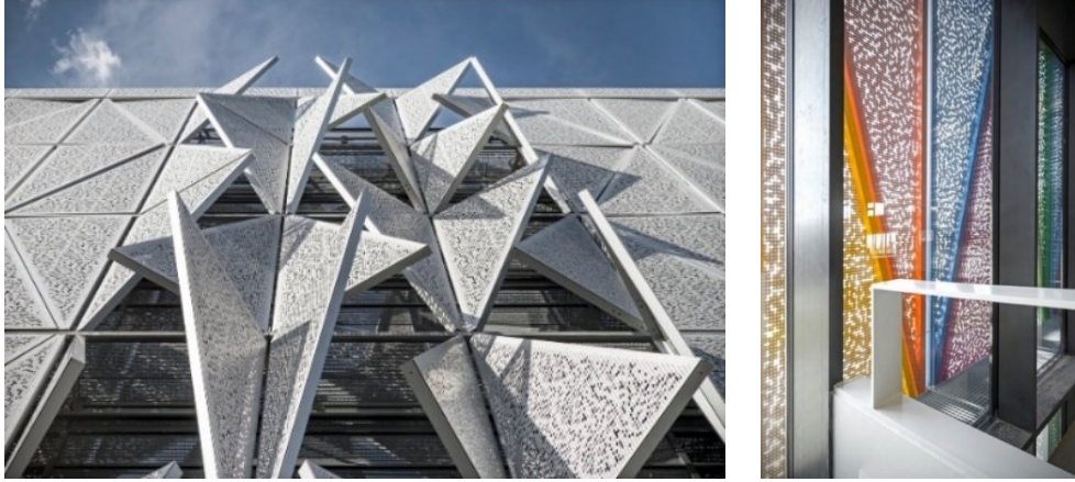
Şekil 3.5: Hareketli Delikli cephe elemanının gösterimi (sol), delikli cephe elemanının iç mekândan görseli (sağ) (Url-19, 2024).
