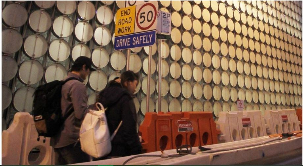
Şekil 3.15: Cephede kullanılan elemanın düşme riskine karşı alınan önlemler (Url-25).
