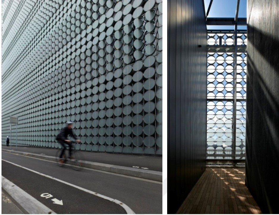
Şekil 3.14: Cam disk içeren galvanizli çelik silindirlerin cephede ve iç mekânda gösterimi (Url-23, 2022).
