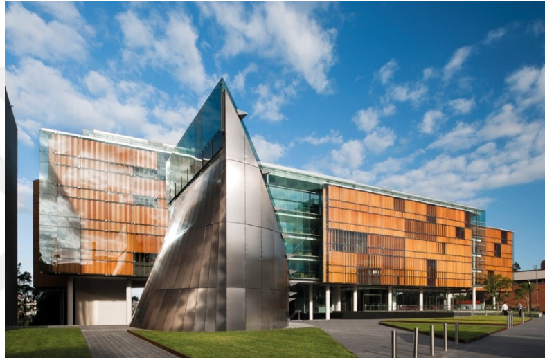
Şekil 3.35: Yapının doğu cephesinin görseli (Url-33, 2024).
