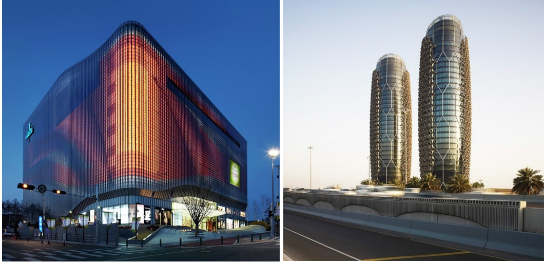
Şekil 2.18: UNStudio' nun Galleria Centercity Binası(sol), Al Bahar Towers(sağ), (Url-13, 2024).
