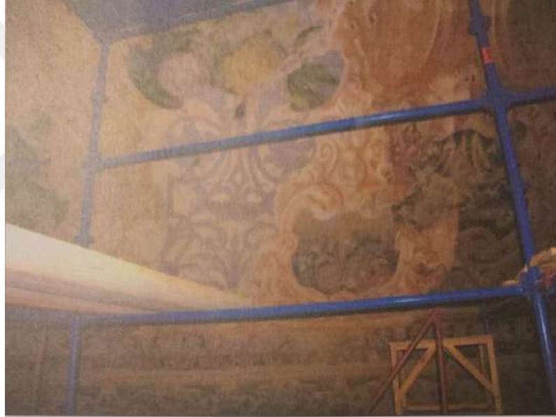
Görsel 4.15. 396 Merkezi kubbe kalemişi araştırma raspası sonrası.
