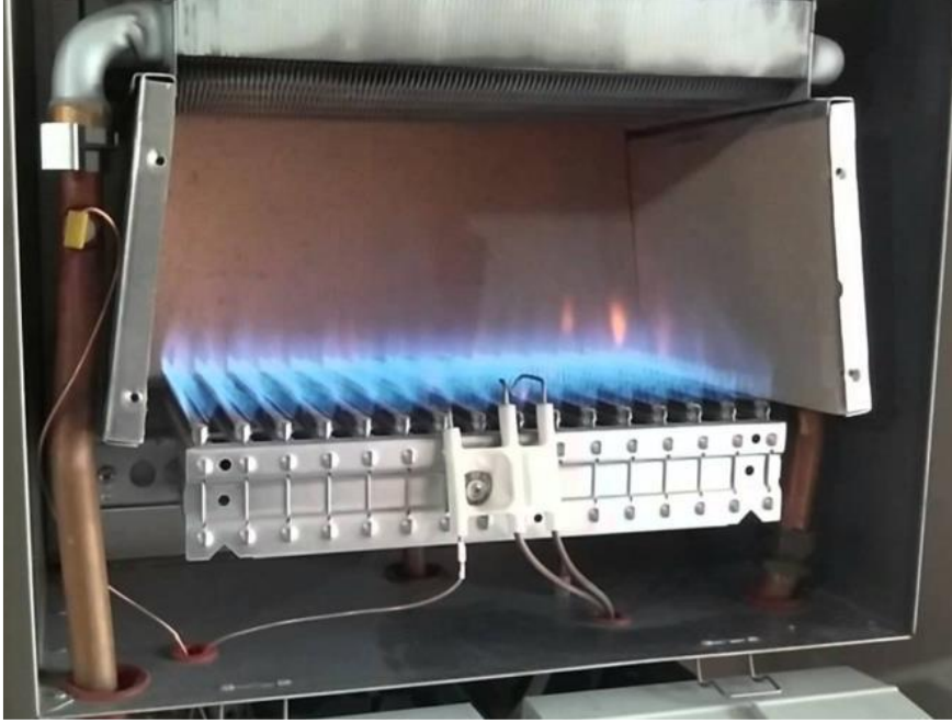
Resim 5.1. Yanma odası [46]
