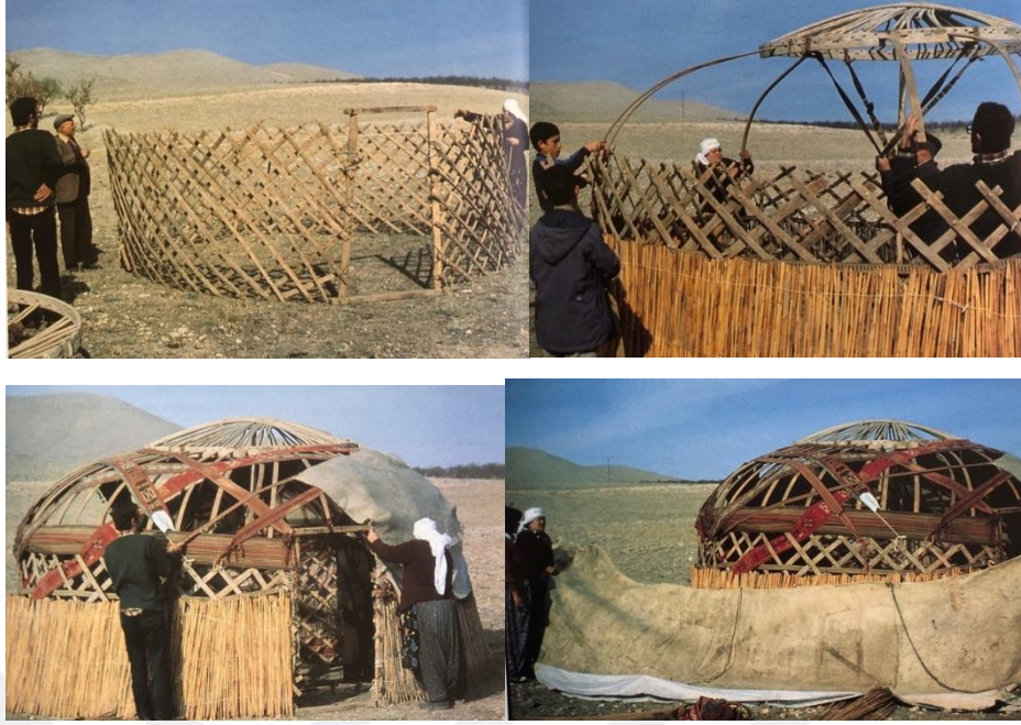
Şekil 16. Afyon, Emirdağ'da bir Topak evin kuruluş aşamaları (Powell, 2012a)
