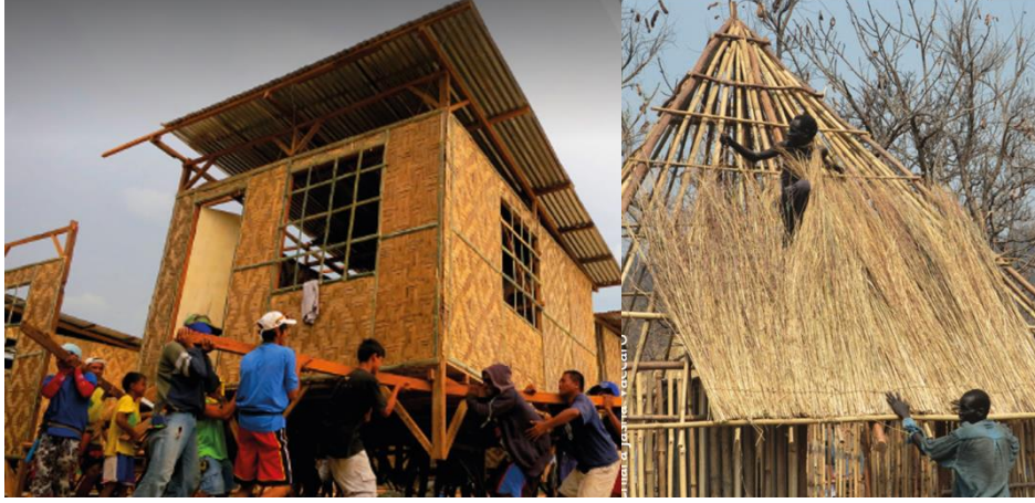
Şekil 94. Acil Barınma Birimi Projesinde Yer Alan Barınma Birimlerinin Kurulumu Shelter Project (Global Shelter Cluster, 2021)
