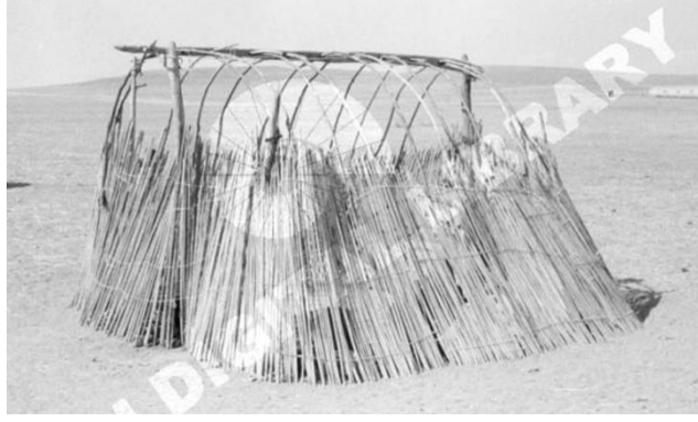
Şekil 11. Alaçık Çadır Taşıyıcı Sistemi ve Örtü Malzemesi (Johansen, 2016)
