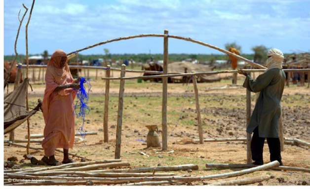
Şekil 88. Burkina Faso’da UNHCR Acil Barınma Birimlerini Kurulumunu Gerçekleştiren Tuareg Kadınları (Shelter Projects Working Group, 2024)
