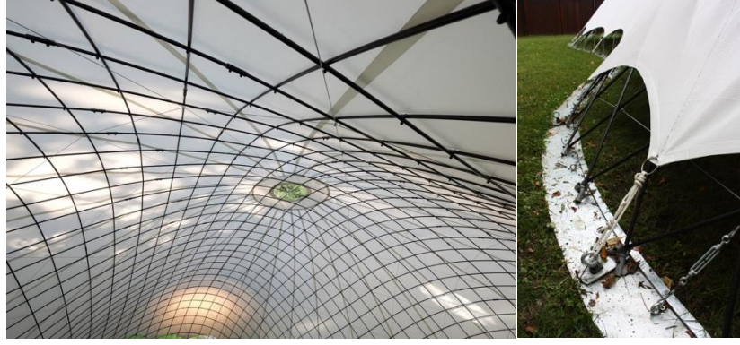
Şekil 57. SheltAir Barınma Birimi Prototipi Detayları (Hasan, 2017)
