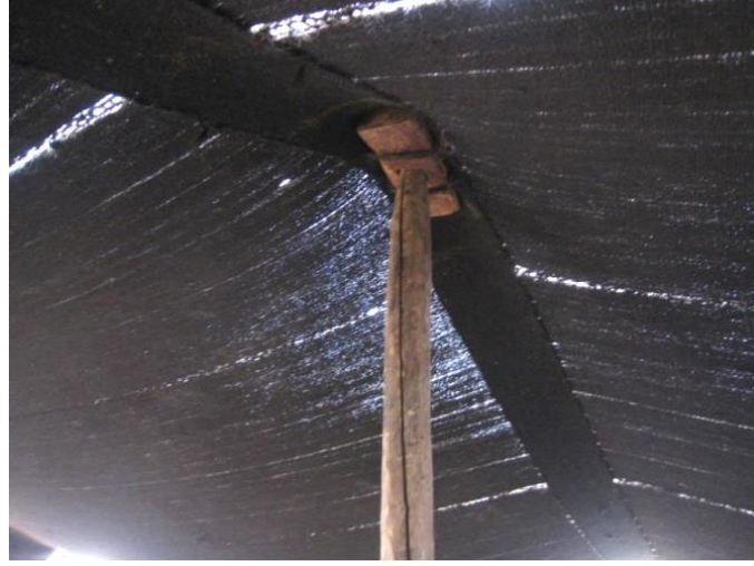
Şekil 22. Karacadırda Stil, Kolan, Direk ve Çadır Çanağı İlişkisi Detayı (Kumtepe, 2016)
