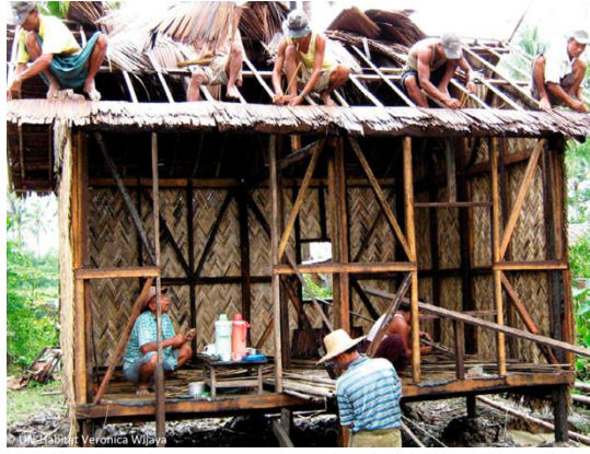
Şekil 93. Myanmar'da Acil Barınma Birimlerini Kurulumunu Gerçekleştiren Afetzedeler (Shelter Projects Working Group, 2024)
