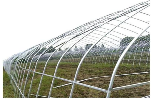
galvaniz çelik borular ile gerçekleştirilen sera çalışmaları
