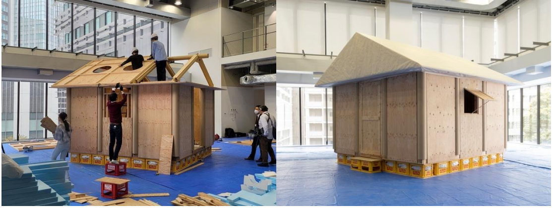
Şekil 75. Ödüllü Japon Mimar Shigeru Ban Tarafından Tasarlanan Kağıt Bobin Evi Yapımı, ODTÜ (Florian, 2023b)
