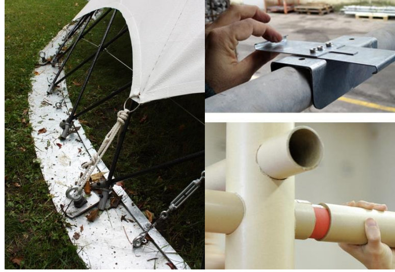
Şekil 95. Yeni Nesil Acil Barınma Birimleri Önerilerinde Uygulanan Birleşim Detayları
