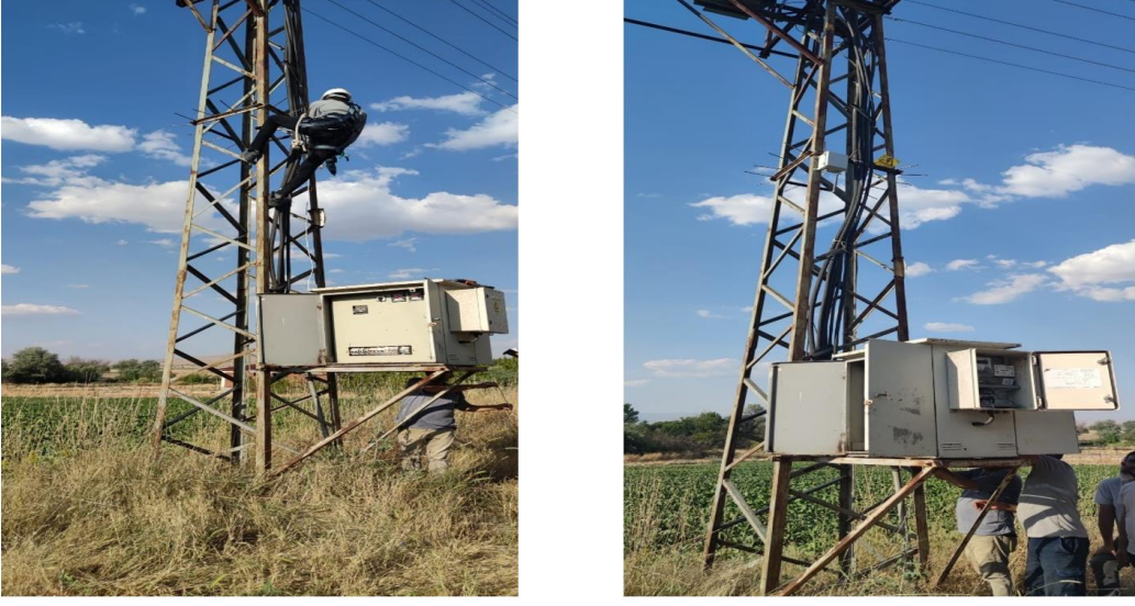
Şekil 44. Veri toplayıcısının montajı
