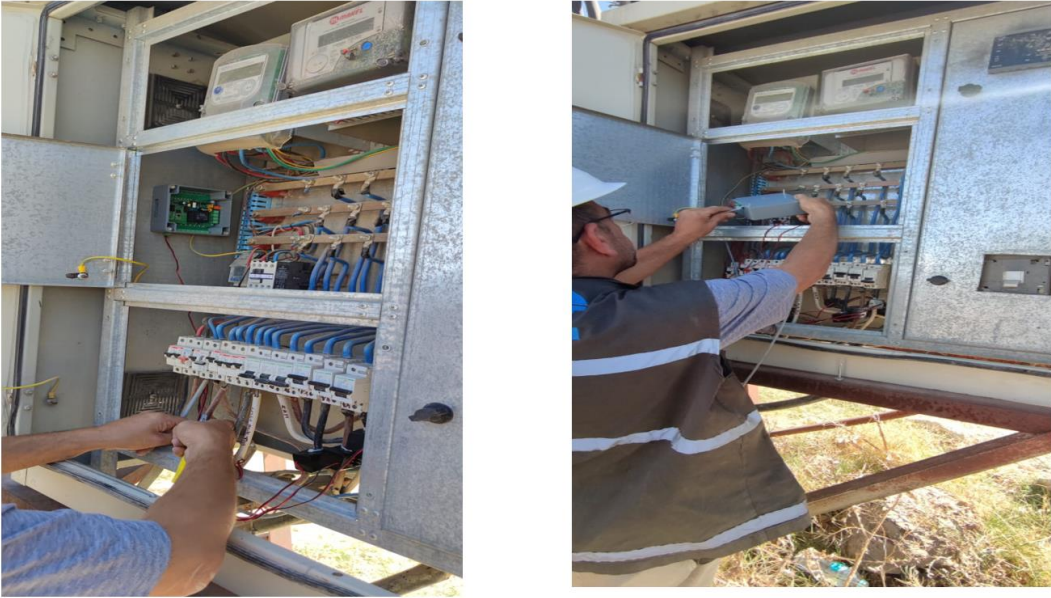
Şekil 43. Ölçüm bileşenlerinin ve veri örnekleme devresinin montajı
