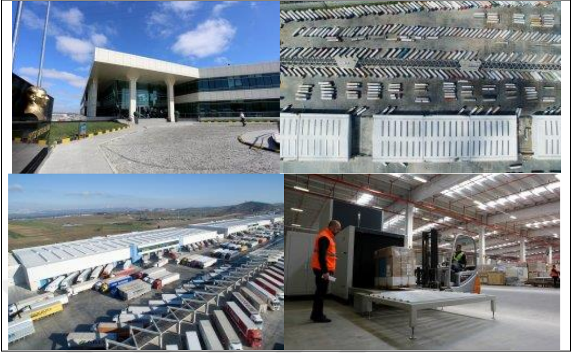
Şekil 5.26 Muratbey gümrük müdürlüğü modernizasyon sonrası (Anonim 2021a)
