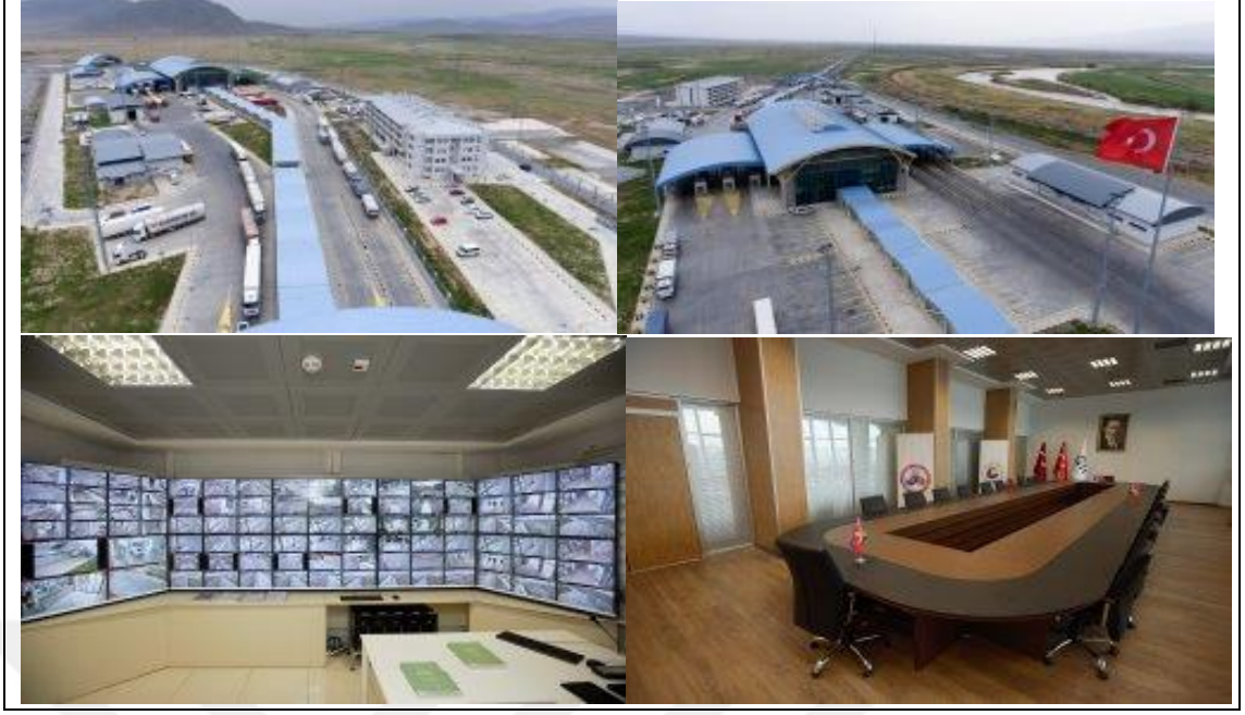
Şekil 5.28 Dilucu sınır kapısı modernizasyon sonrası (Anonim 2021a)
