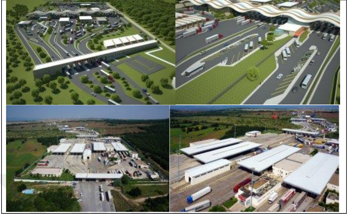
Şekil 5.30 Hamzabeyli sınır kapısı modernizasyon sonrası (Anonim 2021a)
