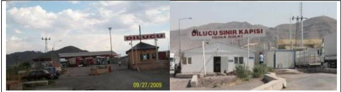
Şekil 5.27 Dilucu sınır kapısı modernizasyon öncesi (Anonim 2021a)
