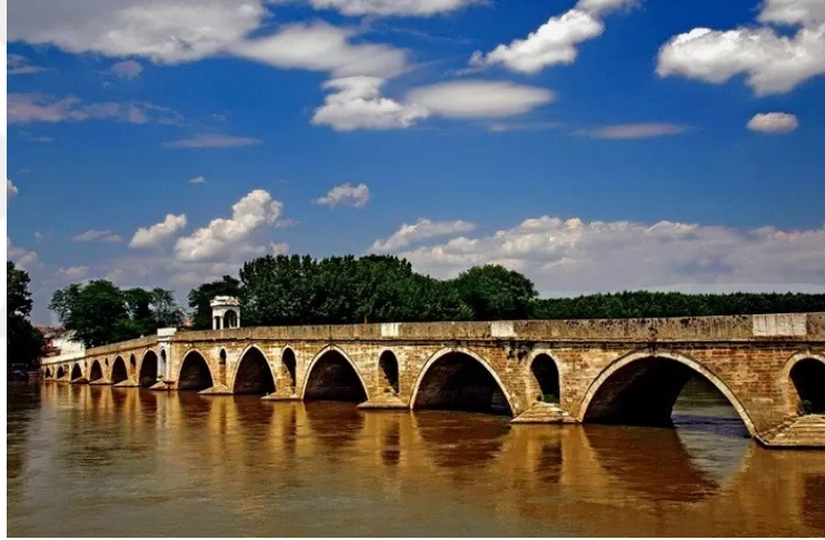
Şekil 3.60: Mustafa Paşa Köprüsü [ “Mustafa Paşa Köprüsü” , t.y.].
