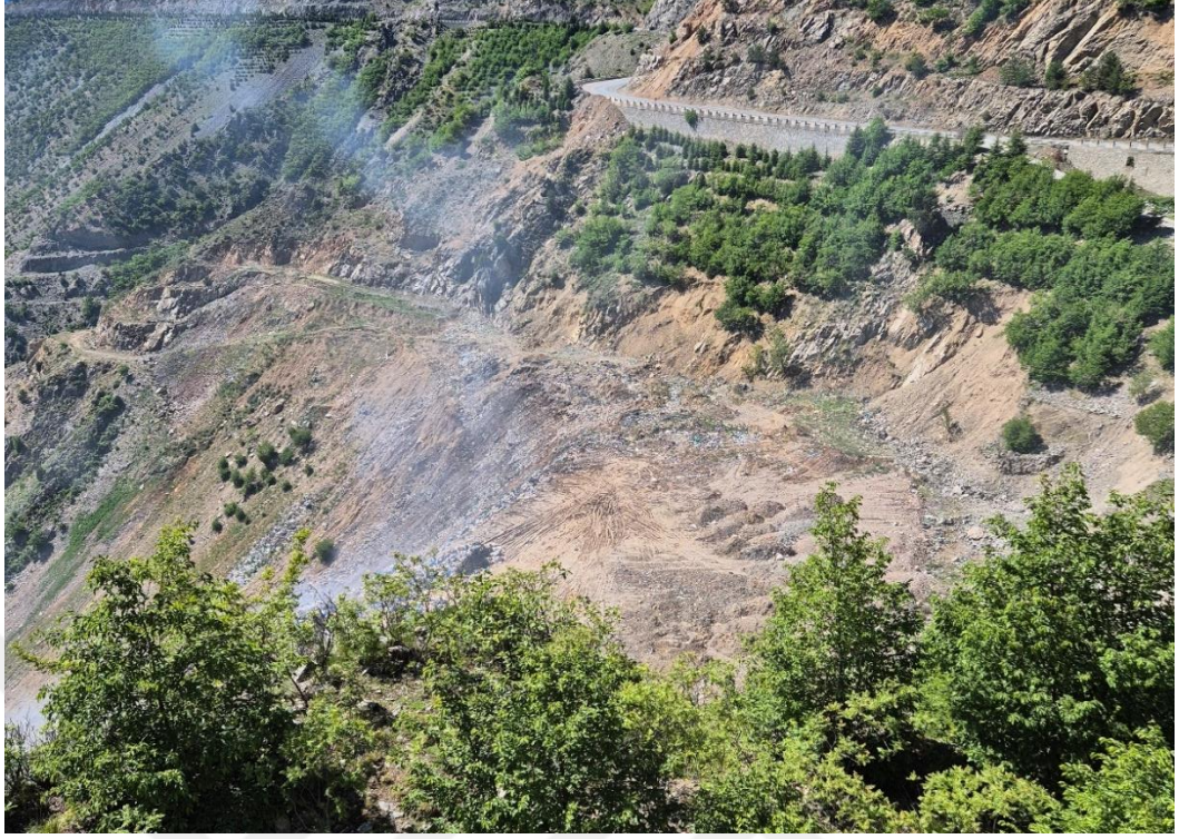
Şekil 8. Artvin İli, Merkez İlçesi yeni vahşi depolama alanı
