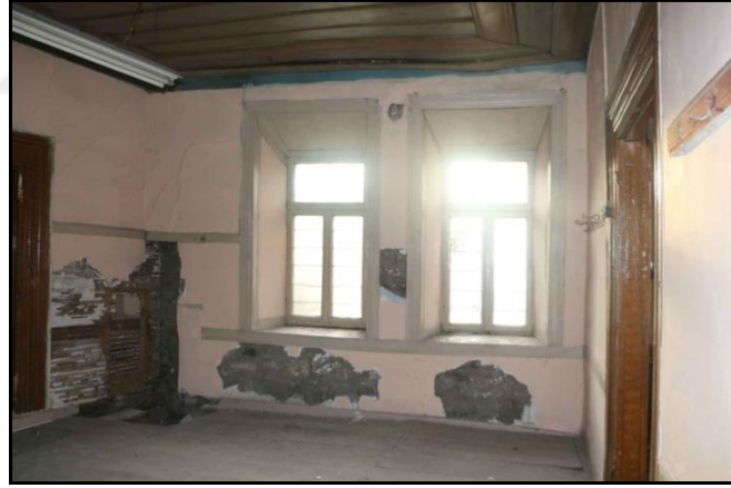
Şekil 4.112: Evin üst katında yer alan sofayı aydınlatan pencereler (Pekgöz, 2019).
