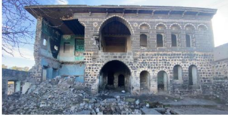
Şekil 4.92: DİY-O2 evi kuzey cephesi (Yoldaş, 2023).
