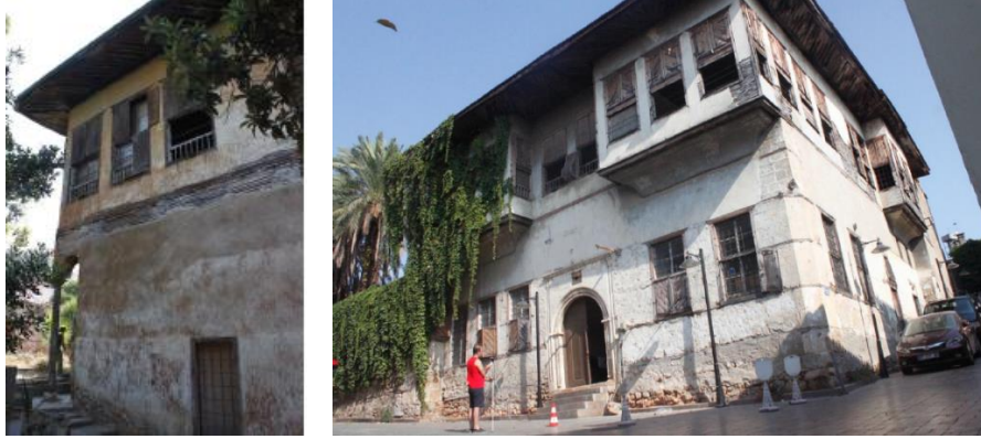
Şekil 4.38: Ömer Lütfü Lülü Konağı (Kara, 2015).
