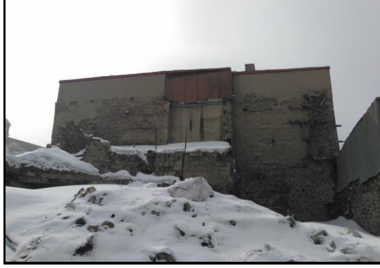
Şekil 4.114: 514 ada, 12 parsel numaralı evin doğu cephesi ve malzeme kullanımı.
