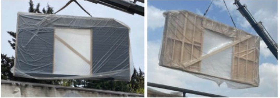
Şekil 5.3: CVZ101 evi yarı açık duvar paneli yapısı
