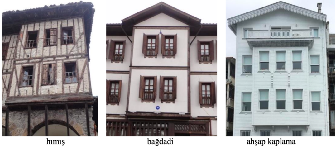
Şekil 1.7: Türkiye'deki geleneksel ahşap karkas yapılarda duvar oluşumu (Avlar ve Yıldırım, 2018)
