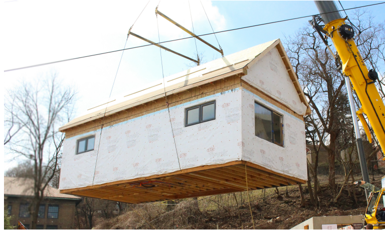
Şekil 1.24: Bütün binanın saha dışında üretildiği bir yapı (Url-11)
