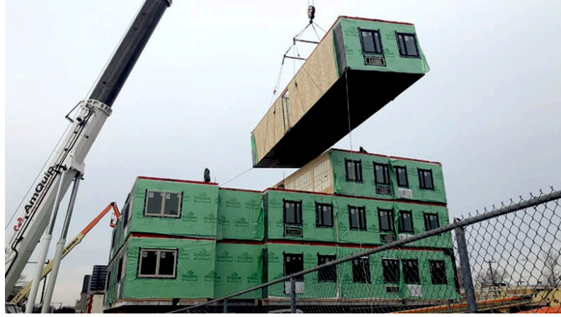
Şekil 1.23: Modüler ahşap yapı örneği (Url-10)
