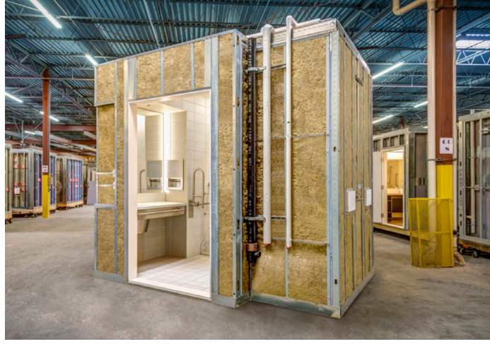
Şekil 1.22: Ön üretimli banyo ünitesi (Url-9)
