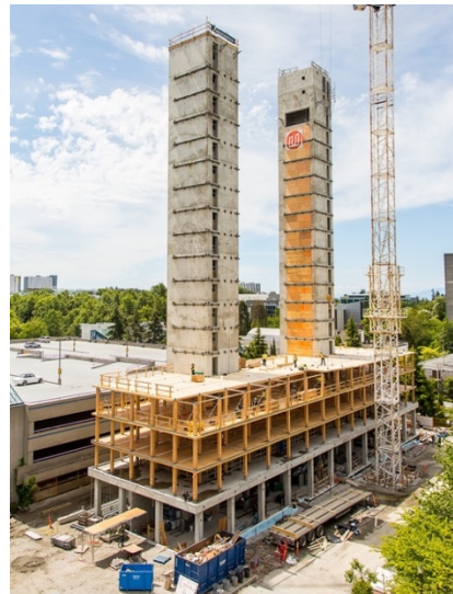
Şekil 1.20: Betonarme-ahşap karma sistem örneği (Url-7)
