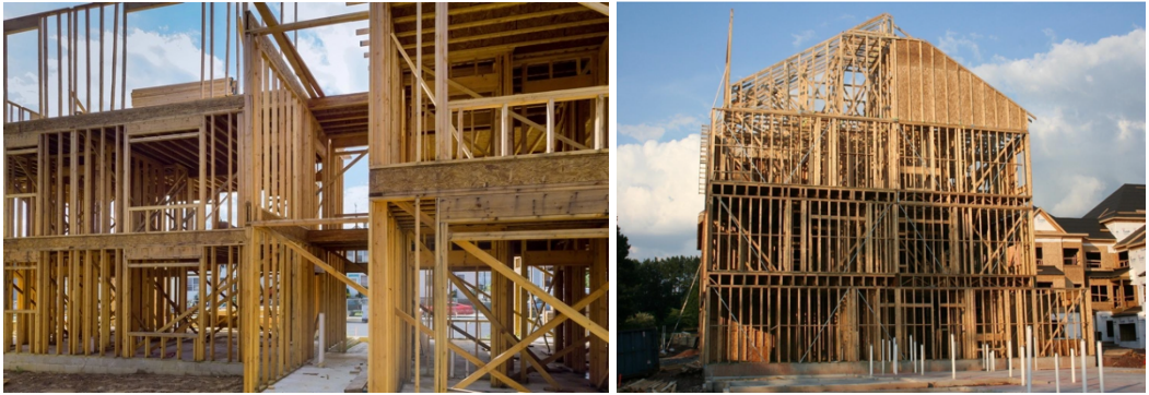
Şekil 1.13: Platform karkas sistem örneği (Loferski, 2015)
