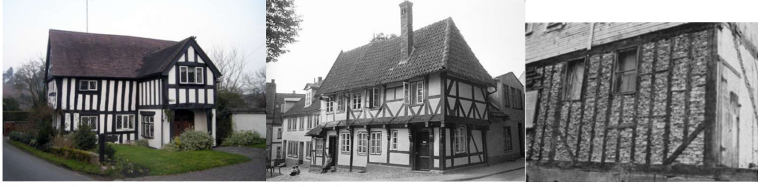
Şekil 1.8: Sırasıyla İngiltere, Almanya ve Amerika’dan half-timbering ahşap karkas sistem örnekleri (Url-2; Url-3; Kniffen & Glassie, 1966)
