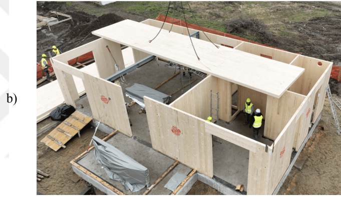
Şekil 1.17: a) CLT panel sistem; b) CLT panel sistem yapı örneği (Url-6)
