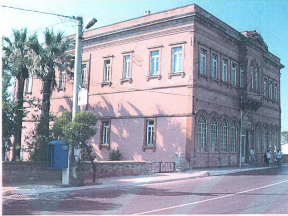
Foto 18: Ayvalık'ta sarımsak taşından yapılmış Vergi Dairesi
