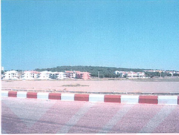
Foto 23: Küçükköy-Altınova yolu üzerinde, orman içine yapılmakta olan konutlar
