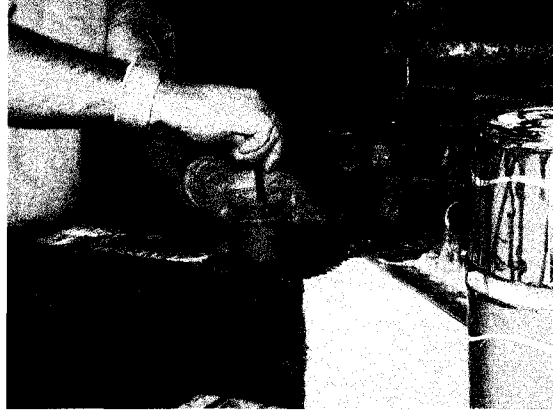
Şekil 2.5. Beton yapıştırıcısının hazırlanması
