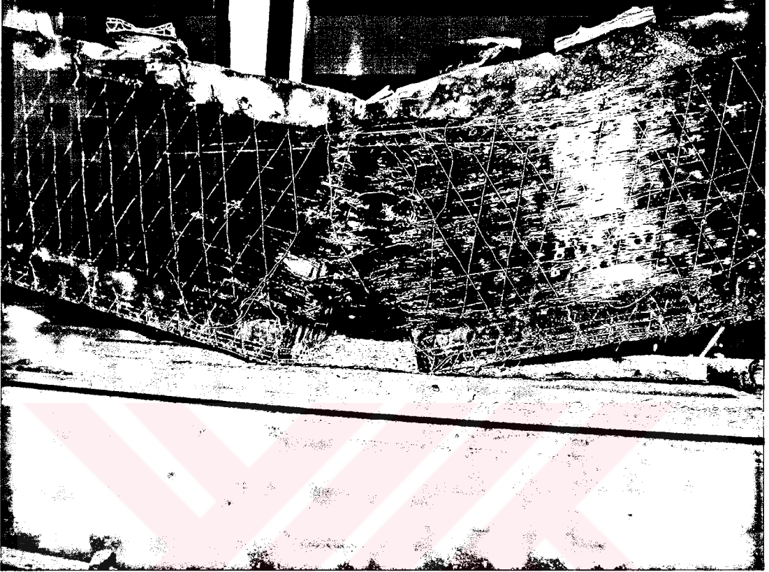
Şekil 3.23. C30 kalitesindeki bantlı beton yapıstırıcısız kirişlerin tipik göçme şekli
