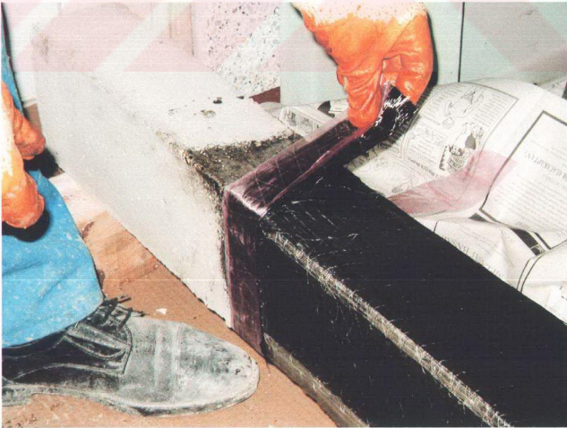
Şekil 2.23. Karbon elyaf etriye sarımı
