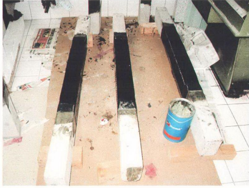
Şekil 2.22. Bohçalama sistemi ile sarılmış kirişler
