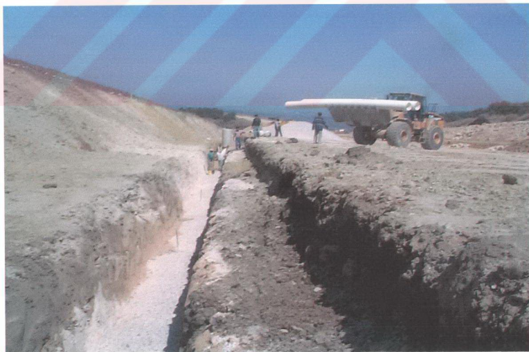
Şekil A2-2. Km 105+560 – 105+760 arasında drenaj kazısı çalışmalarından görünüş.
