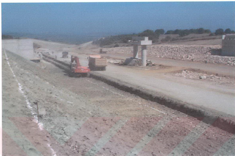
Şekil A2-1. Km 105+760 – 105+900 arasında taş topuk duvarı kazısı tamamlanan ve drenaj kazısı devam etmekte olan anın görünüşü.
