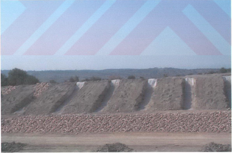
Şekil A2 – 4. Yer altı drenaj işlemi tamamlanmış, taş drenlerin altına serilen, jeotekstil ve drenaj malzemesi serilmiş taş topuk yapısı imal edilmiş kesitten görünüş.
