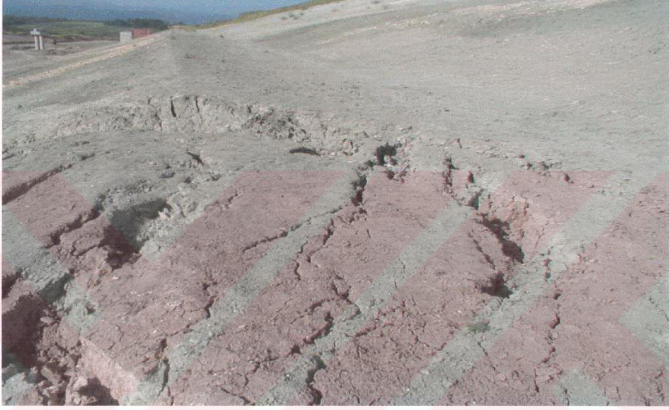
Şekil 6.5 Heyelanlı kesim taç bölgesi – 1. palye içinde ilerleyen çekme ve kesme çatlakları.
