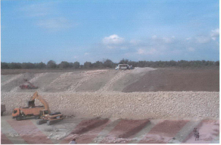
Şekil A2-5. Anayol gövdesi, taş topuk, düşey drenler ve yatay su drenlerinin imalatı.
