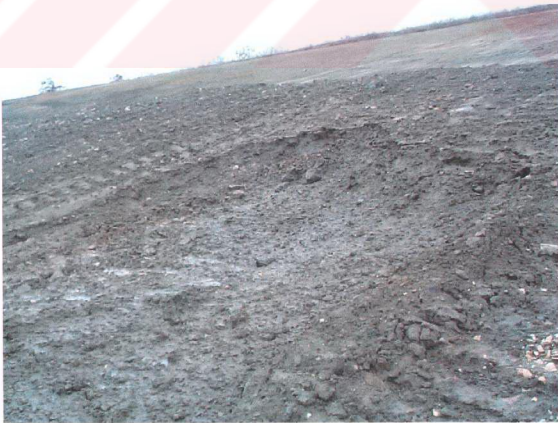
Şekil 6.10 Heyelanın olduğu km:104+360–105+400 arası yarma.
