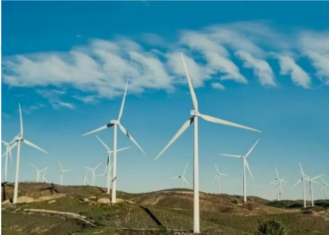
Şekil 1.7. Yatay eksen rüzgâr türbini (Türbini, 2023)
