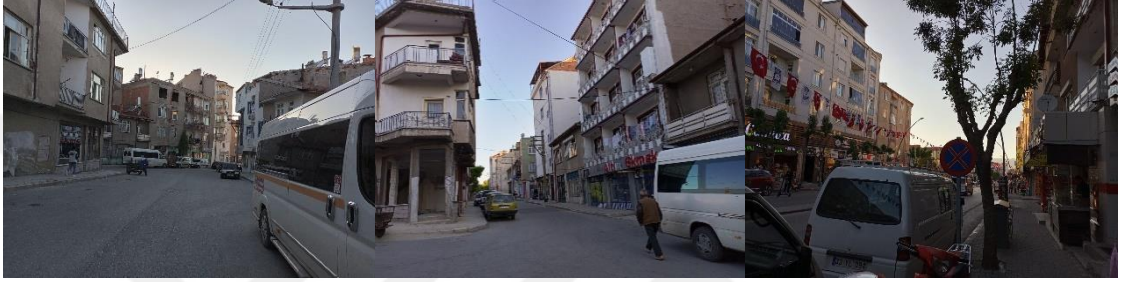
Şekil 12. Yenimahalle’de “Belediye Kentsel Gelişim ve Dönüşüm Alanı” na giren binalar (Kaynak: Yazar,2023)
