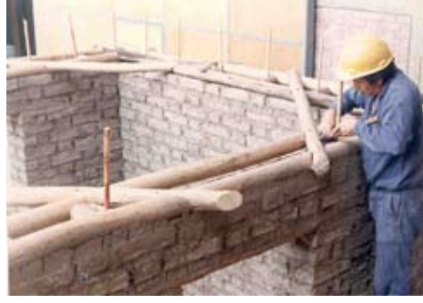
Şekil 2.12 Kat yüksekliğinde okalıptüs ağacı gövdelerinden oluşturulmuş ahşap yatay hatıllar (Blondet Vd. 2002, EERI)
