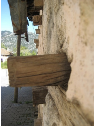
Şekil 2.16 Duvar Dışına Taşırılan Ahşap Hatıllar (Erol, 2021)
