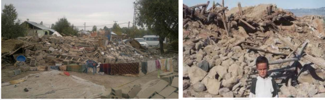
Resim 2.4 a) Briket yıkılmış bina (Van-Erciş Depremi-2011). b)Taş malzemeli yıkılmış bina bina. (Bingöl Depremi-2003)
