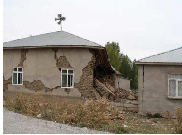
řekil 2.1. a) Yığma yapıda kesme atlağı (Ko,2016) b) Duvara dik doėrultuda deprem kuvvetleri sonucu duvarın dzlem dıřı devrilmesi (Van-Erciř depremi 2011).
