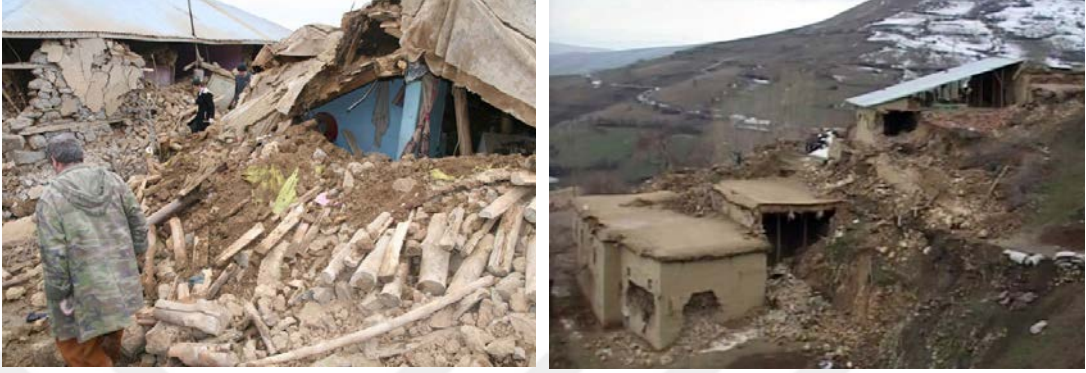
Şekil 2.6 Kırsal kesimde hasar gören yığma yapılar (2010 Elazığ depremi)
