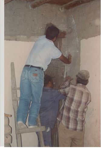
Şekil 2.25 Kerpiç binanın iç görünümü (Quiun, 2008) (EERI ve IAEE)
