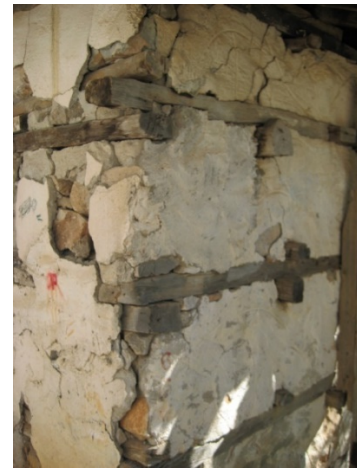
Şekil 2.19 Duvar köşe birleşim detayı (Erol, 2021)
