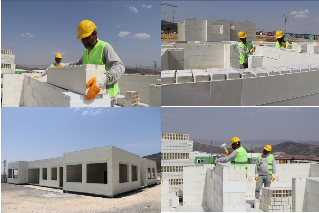
Şekil 2.28 Fiber kompozit bloklar ile duvar örümü ( https://www.aa.com.tr/2023 )
