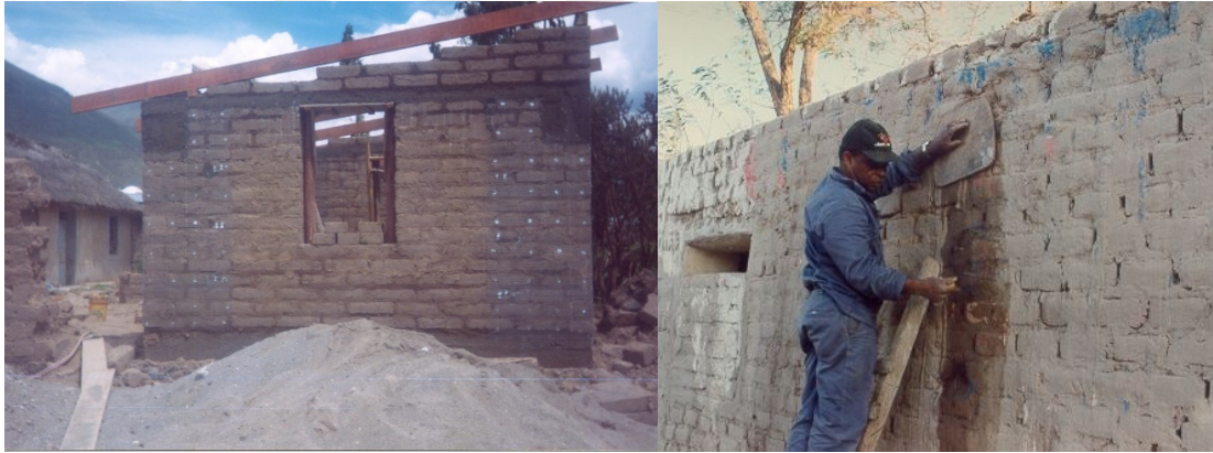
Şekil 2.23 Kerpiç yapıda duvar yüzeyine kafes teli uygulaması (Zegarra Vd., 1997, Kerpiç Çalıştay)
