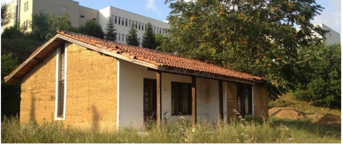
Sekil 2.9 Yapılan alçı katkılı kerpiç malzemeli deneme evi, İTÜ Ayazağa Kampüsü
