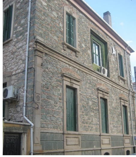
Şekil 1.2 Taş yığma yapı (Erol arşivi, 2019)
