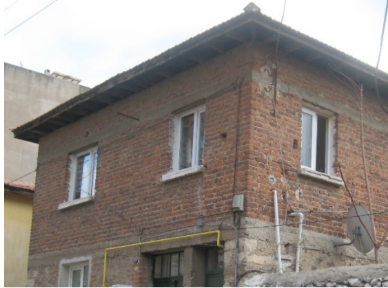
Şekil 1.3 Tuğla yığma yapı (Erol arşivi, 2019)
