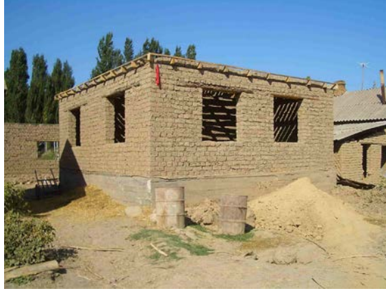
Şekil 1.5 Kerpiç yığma yapı ( https://insaathesabi.com )
