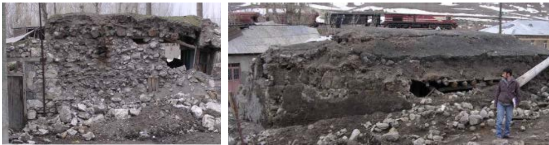
Şekil 2.5 Kırsal kesimde kalın toprak damlı yığma yapılar (2004 Erzurum depremi)
