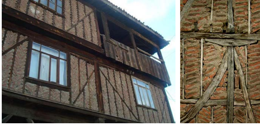
Şekil 1.6 Hımiş yapı (Gülkan, Langenbach, 2004)
