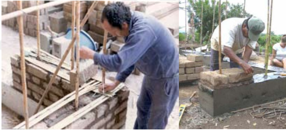
Şekil 2.20 Kerpiç malzeme ile inşa edilen duvar içinde bambu donatı kullanımı (Blondet Vd. 2002, EERI)
