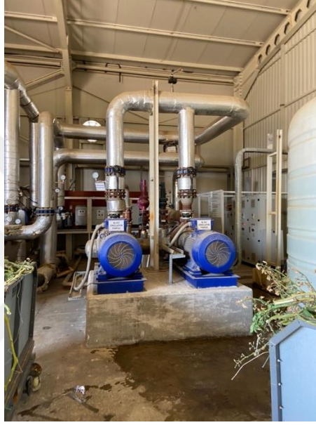
Fotoğraf 15. Jeotermal ısıtma sirkülasyon pompaları
