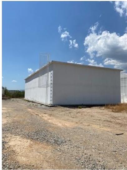
Fotoğraf 17. Beton su deposu
