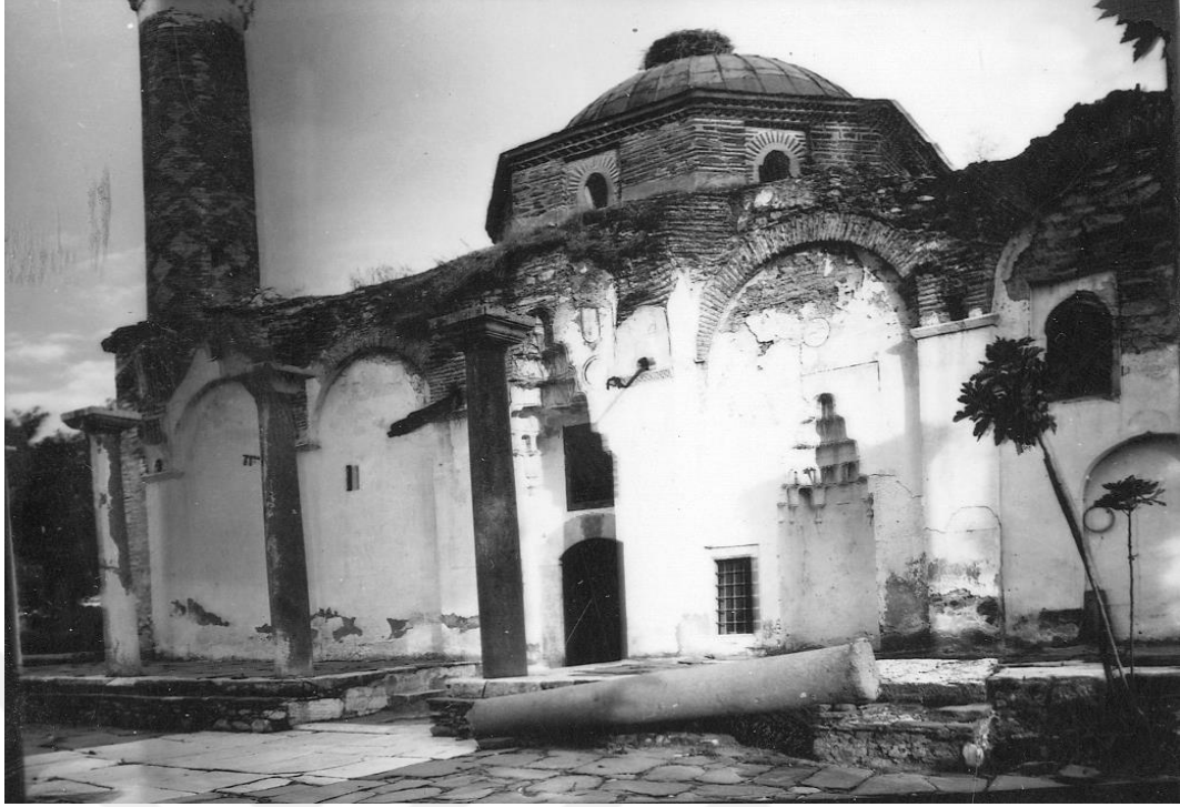
Fotoğraf 13. Son Cemaat Yerinin Restorasyon Öncesi Durumu (Vakıflar Genel Müdürlüğü Arşivi, 2023)
