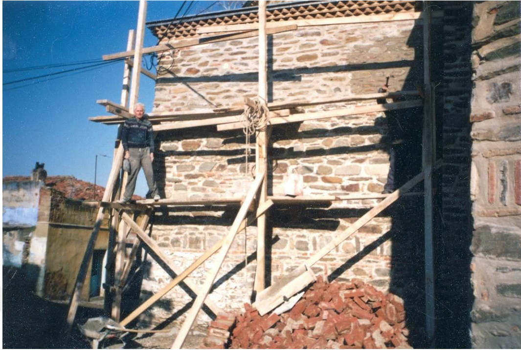
Fotoğraf 21. Beden Duvarı ve Saçak Onarımı (Vakıflar Genel Müdürlüğü Arşivi, 2023)
