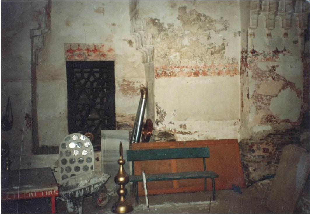
Fotoğraf 63. 1992-1995 Tarihli Restorasyon Sürecinde İç Avlu Doğu Duvarı (Vakıflar Genel Müdürlüğü Arşivi, 2023)
