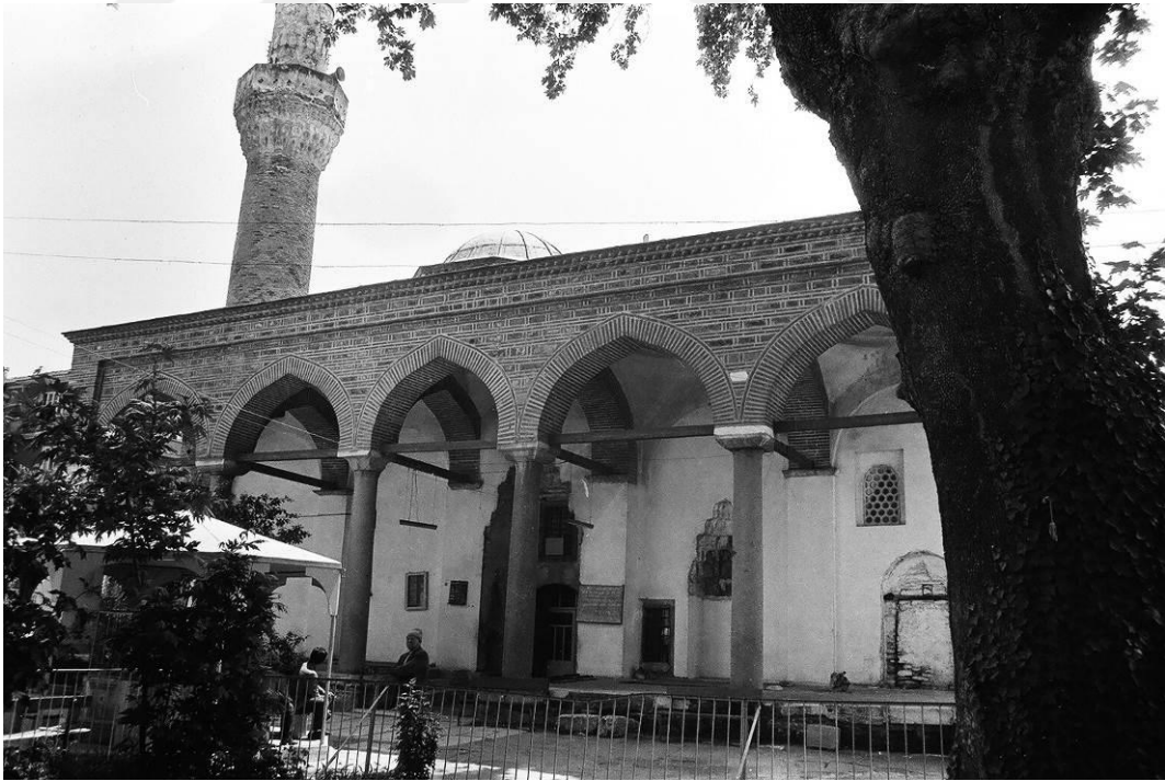
Fotoğraf 14. Son Cemaat Yerinin Restorasyon Sonrası Durumu (Vakıflar Genel Müdürlüğü Arşivi, 2023)
