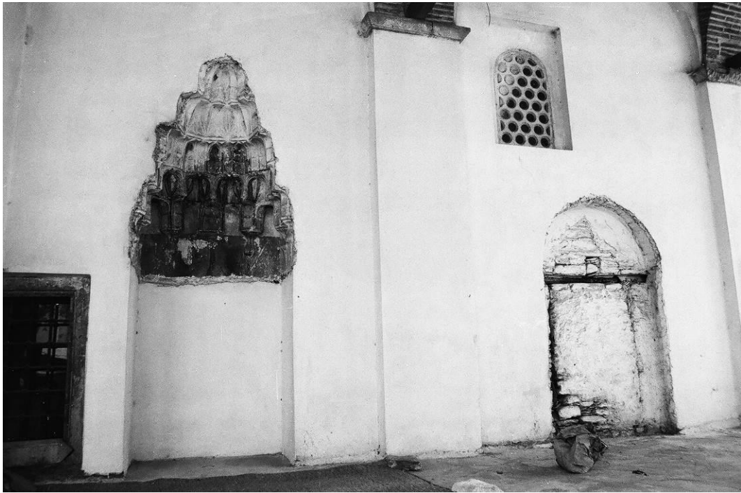
Fotoğraf 71. Restorasyon Öncesi Batı Tabhâne Kuzey Duvarının Dıştan Görünümü (Vakıflar Genel Müdürlüğü Arşivi, 2023)
