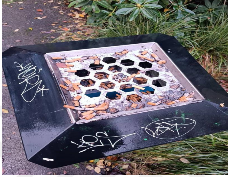
Görsel 4.37. St. John's Gardens izmarit kalıntıları (Kaynak: Araştırmacı)
