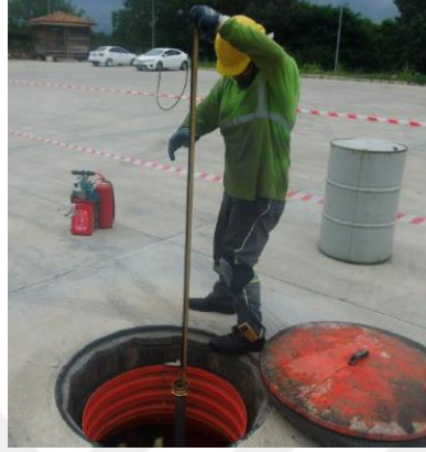
Şekil 4.8 : Operasyonel kayıplar – depolama tankı kontrolleri.
