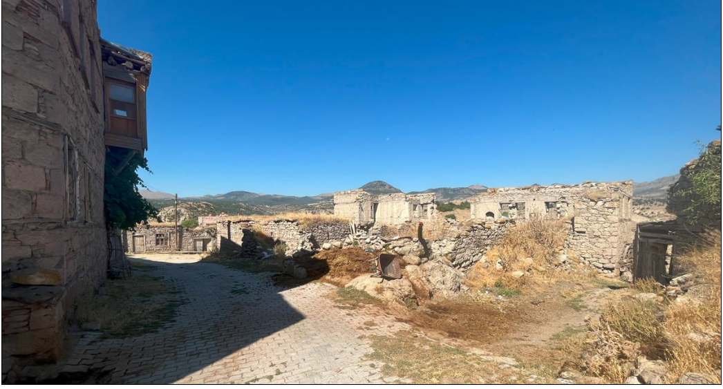
Şekil 4.90. Yerleşimdeki harabe yapı örnekleri (Kişisel arşiv, 2023)
