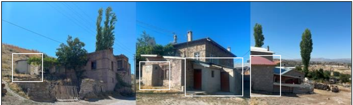
Şekil 4.59. Geleneksel yapılara ilave inşa edilen betonarme ek yapılar (Kişisel arşiv, 2023)
