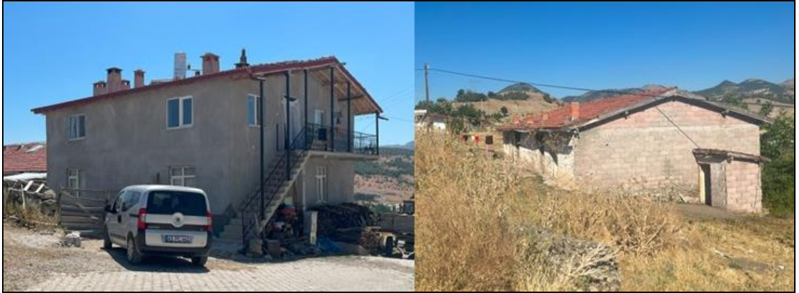
Şekil 4.70. Yerleşimde bulunan betonarme ve yığma tuğla yapı örnekleri (Kişisel arşiv, 2023)
