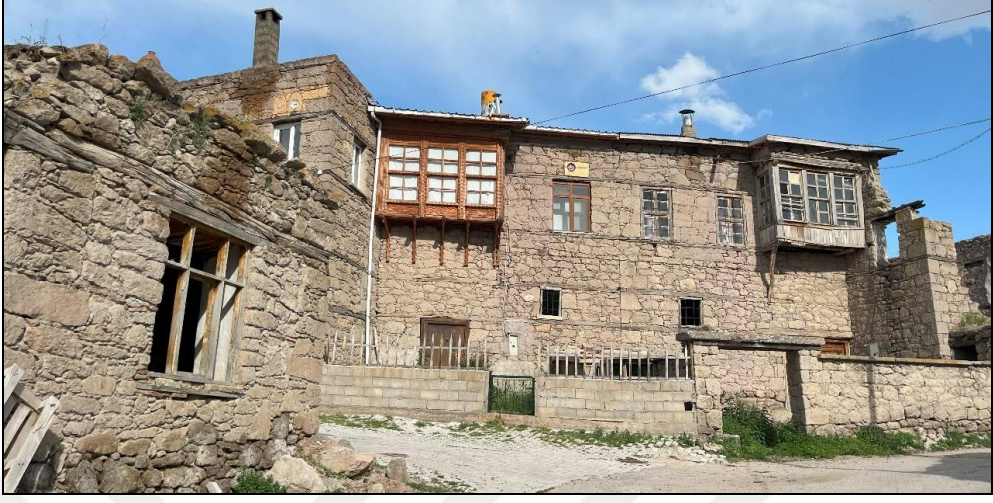
Şekil 4.69. Yerleşimde bulunan yığma taş yöntemiyle inşa edilmiş yapı örneği (Kişisel arşiv, 2023)
