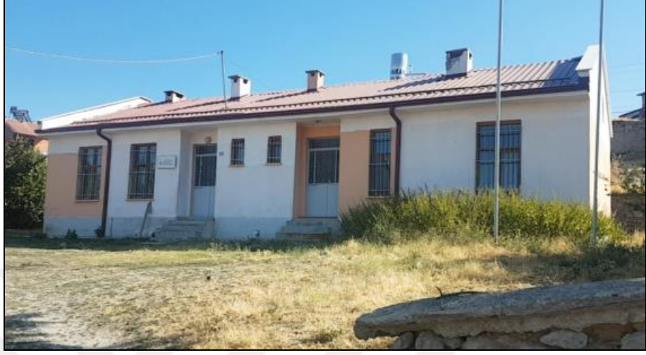
Şekil 4.52. Yerleşimdeki sağlık ocağı binası (Kişisel arşiv, 2023)
