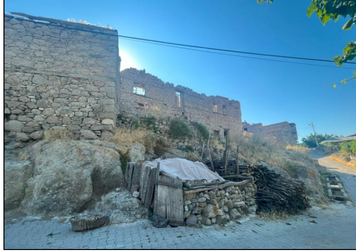
Şekil 4.17. Kayalık zemin üzerine inşa edilen yapılar (Kişisel arşiv, 2023)
