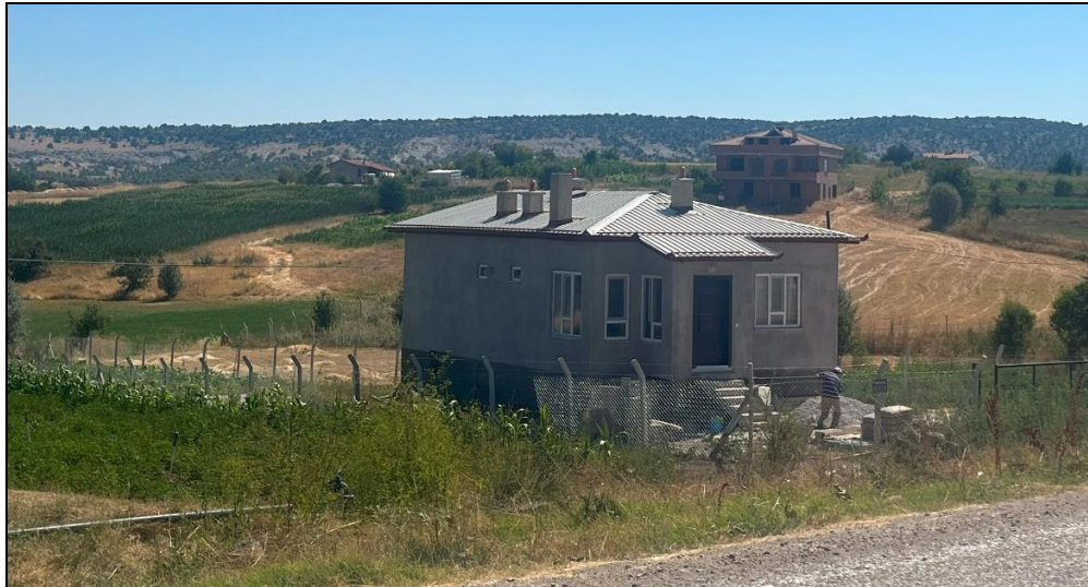
Şekil 4.77. Yerleşimin kuzeyinde yer alan tarım ve bahçe arazileri (Kişisel arşiv, 2023)
