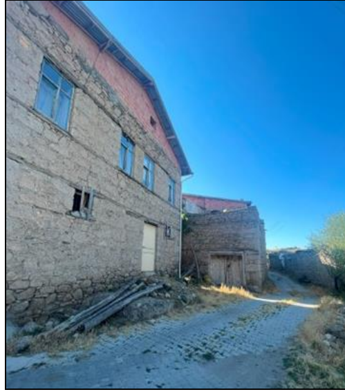
Şekil 4.44. Müdahale görmüş geleneksel yapı örneği (Kişisel arşiv, 2023)
