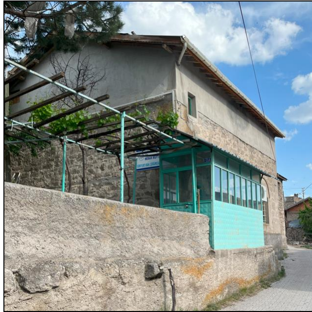
Şekil 4.45. Dokuyla uyumsuz yeni yapı + geleneksel yapı örneği (Kişisel arşiv, 2023)
